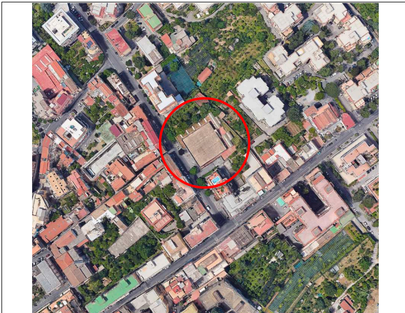
Foto 1: vista satellitare - Fabbricato sito in Piano di Sorrento (NA), alla Via Bagnulo n. 21.
