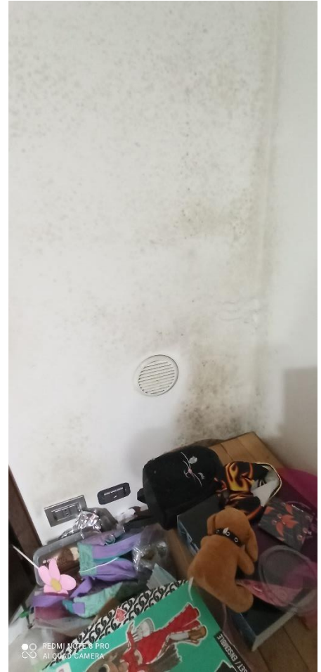
viste camera da letto, dettaglio fenomeni di umidità e presa d'aria per il ricambio.
