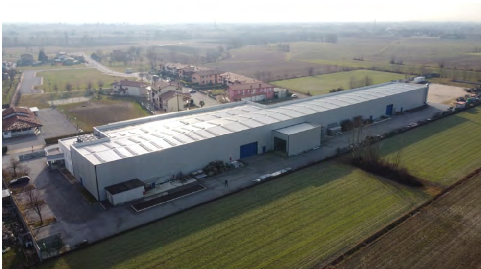
5. Foto: foto stabilimento lato ovest (drone)
