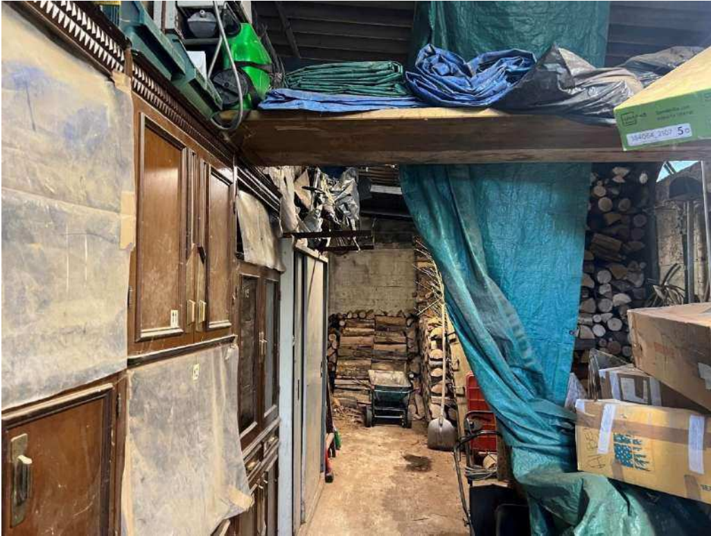
Figura 21 tettoia realizzata sul nm. 991
