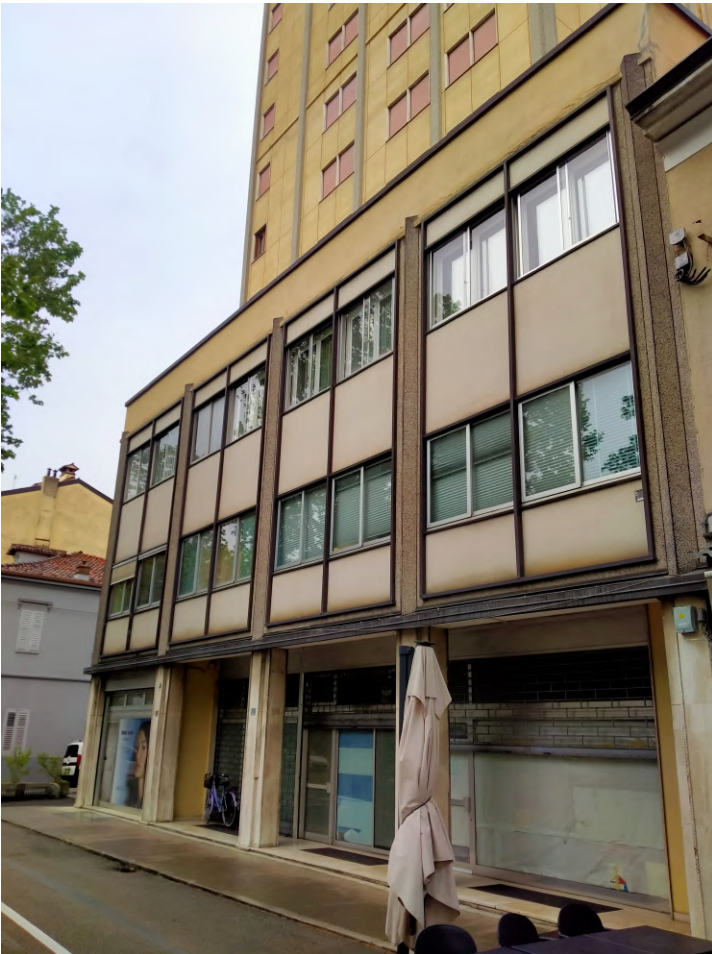
FOTO 2 – inquadramento generale; facciata lato via Arcadi
