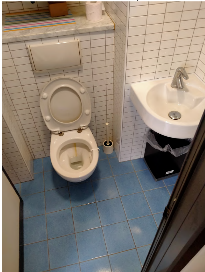
FOTO 16 – secondo w.c. al pianoterra
