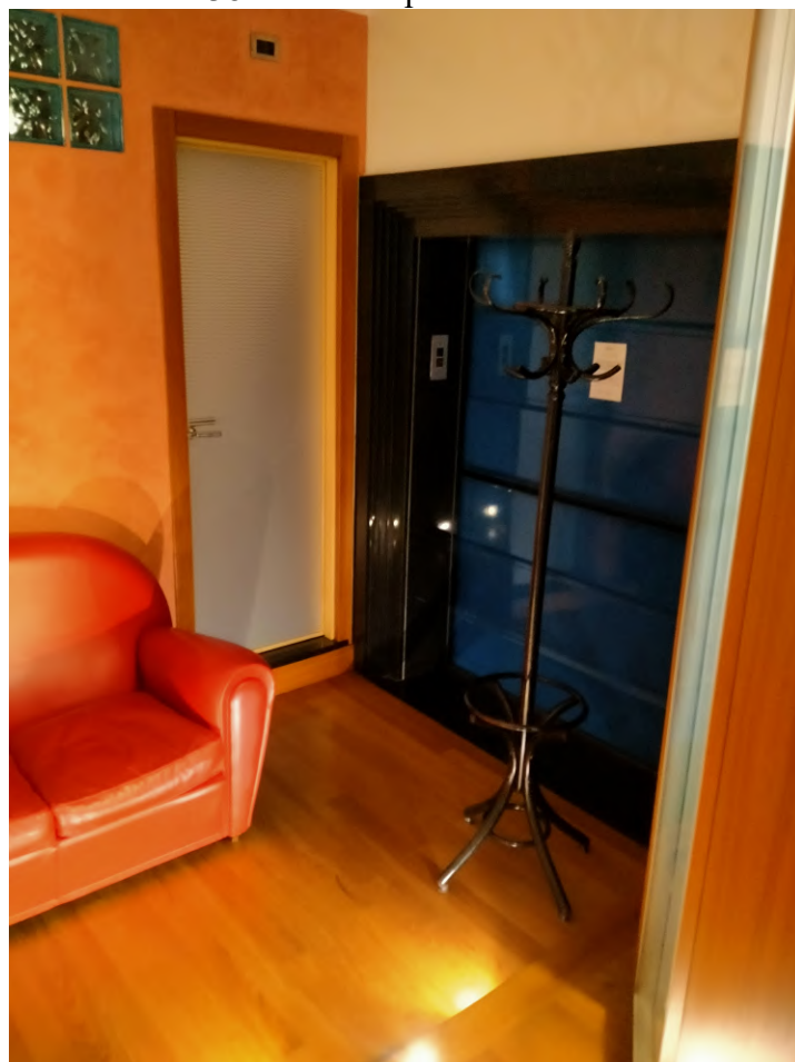
FOTO 38 – secondo piano – montacarichi
