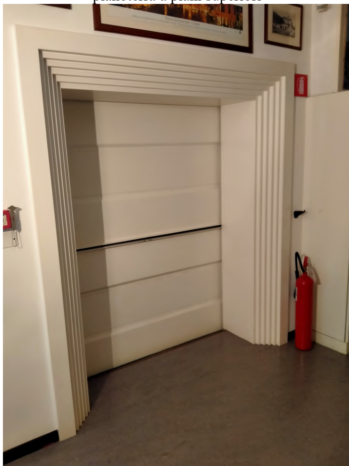
FOTO 19 – montacarichi di collegamento tra pianoterra a piani superiori
