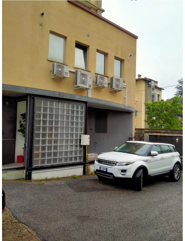
FOTO 4 – pianoterra; zona ingresso (da altra unità immobiliare in capo a terzo soggetto)
