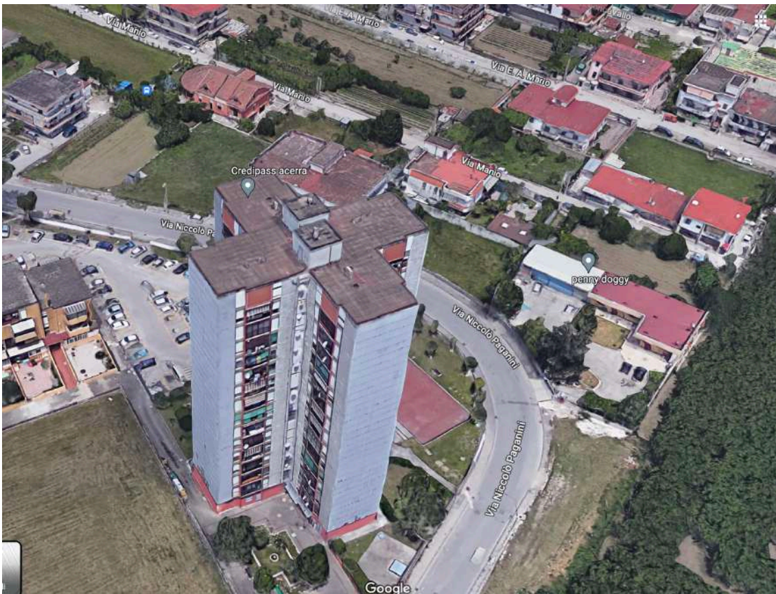
Foto 4. Vista aerea dell'edificio
