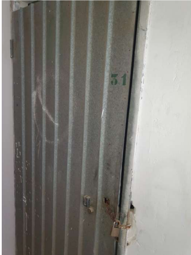
Foto 35. Locale cantinato n. 31 - esterno
