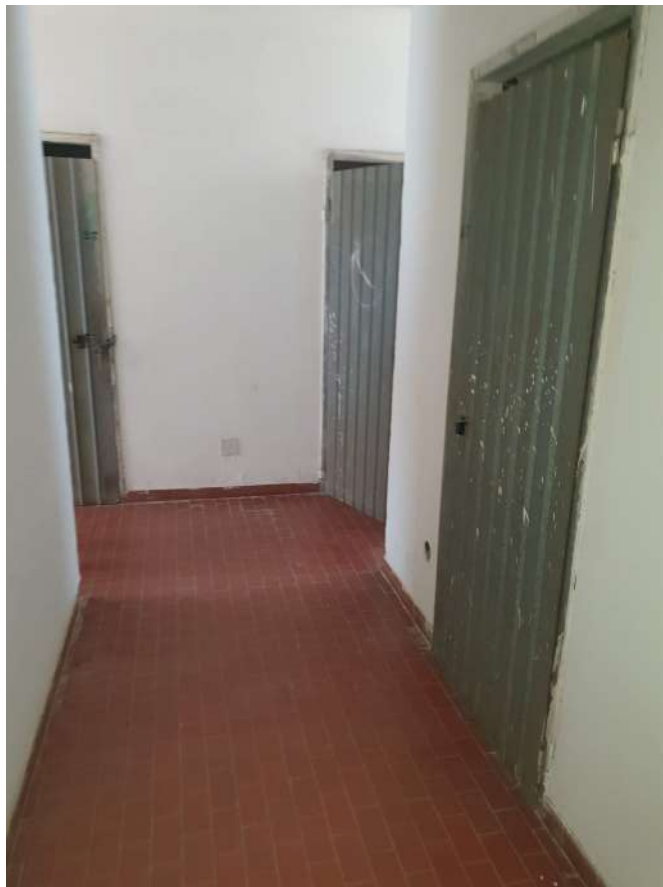
Foto 34. Corridoio di accesso al locale cantinato
