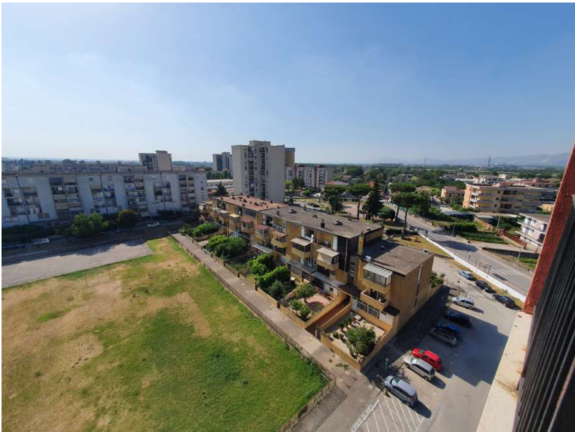
Foto 30. Vista lato nord-ovest
