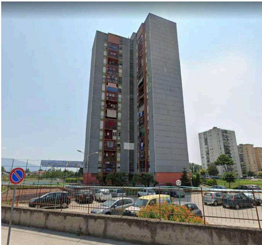
Foto 6. Prospetto nord su via Niccolò Paganini
