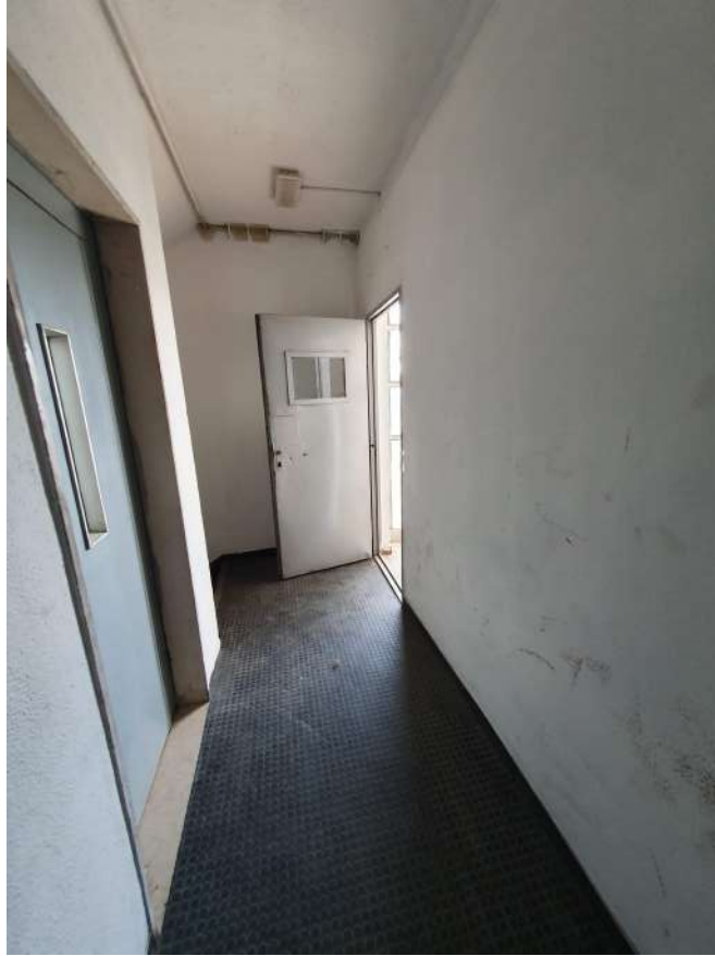
Foto 31. Corridoio di accesso al locale cantinato
