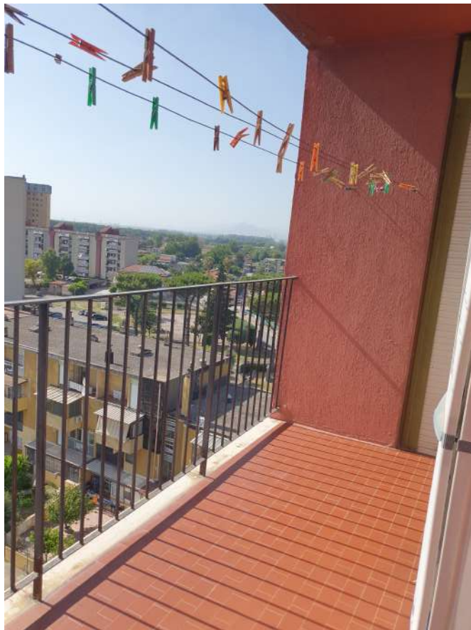
Foto 28. Balcone lato est
