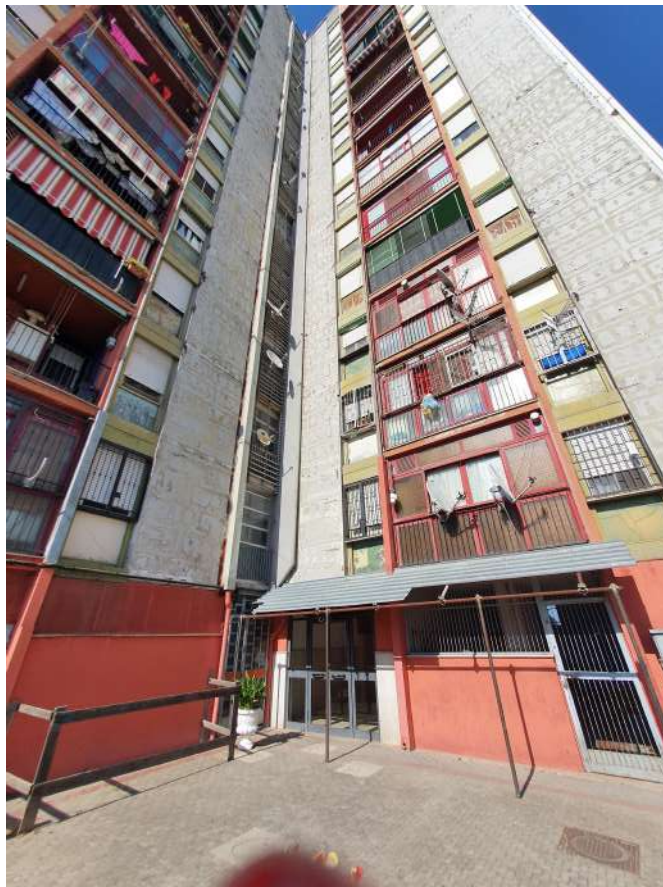
Foto 8. Ingresso all'edificio - lato sud
