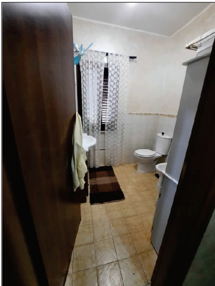
Servizio igienico piano primo.
