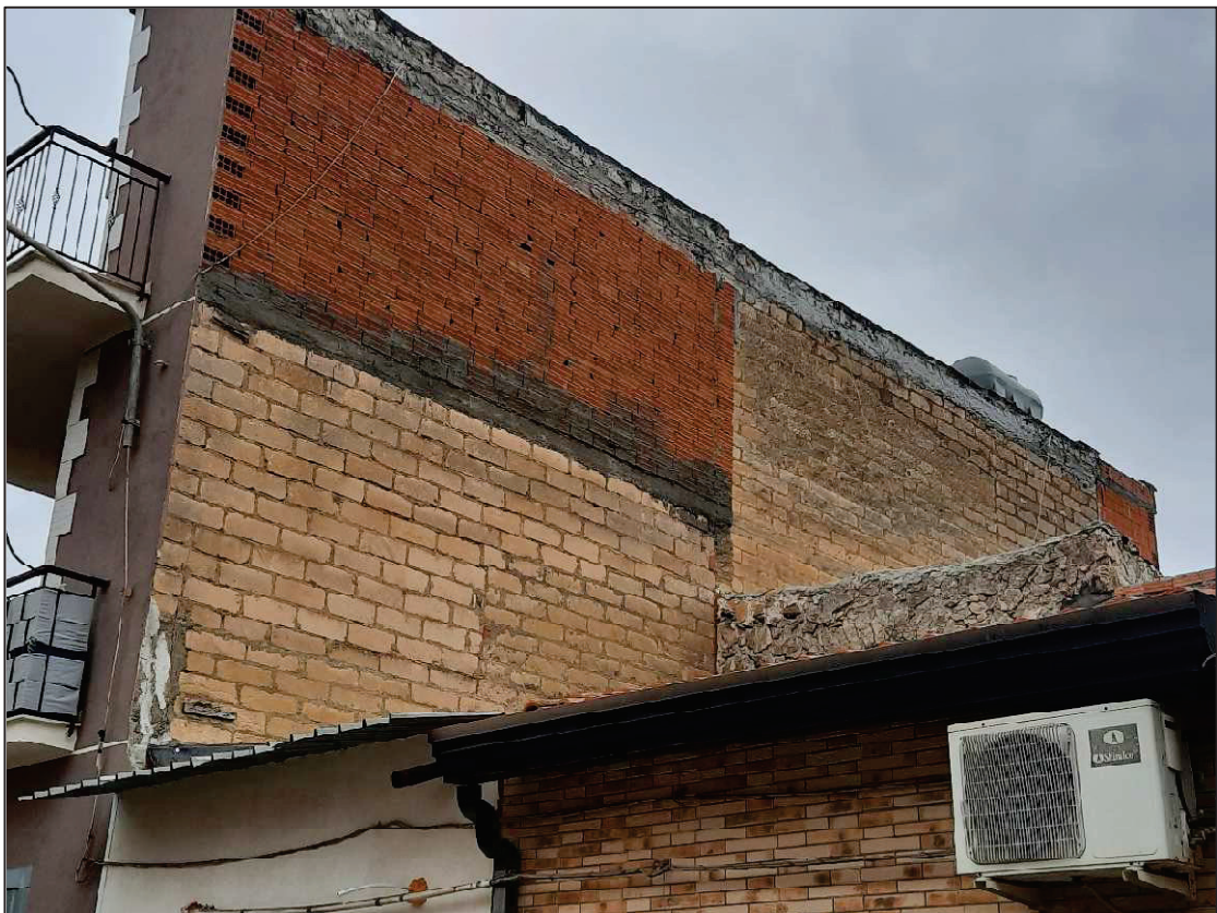
Prospetto nord, muratura a vista con evidenza delle diversità nei materiali
