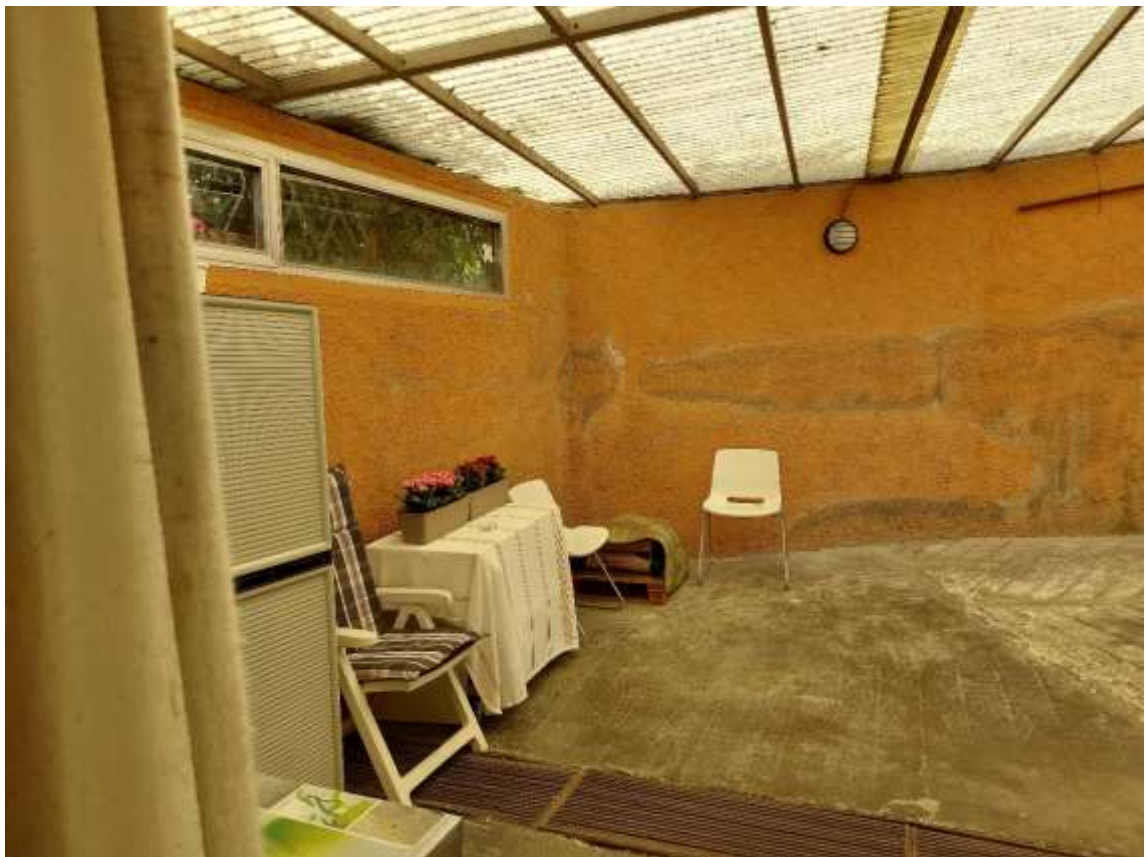
Tettoia su rampa accesso al PS1
