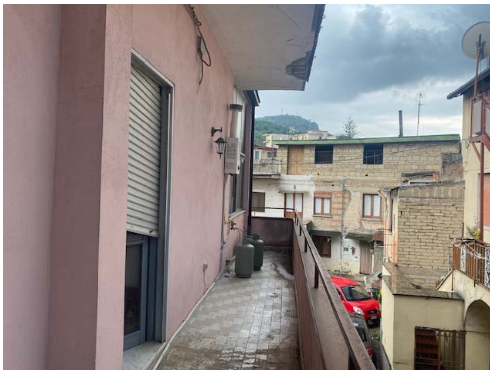
Foto 22_ Balcone – piano primo
