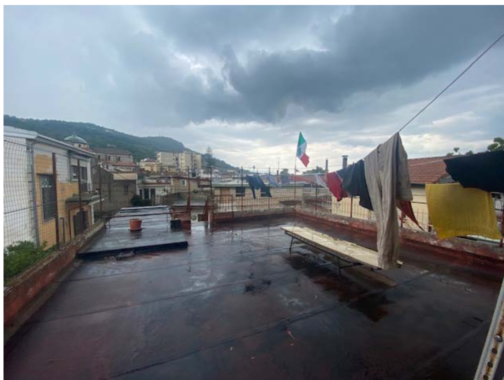
Foto 20_ Terrazzo di copertura - lastrico
