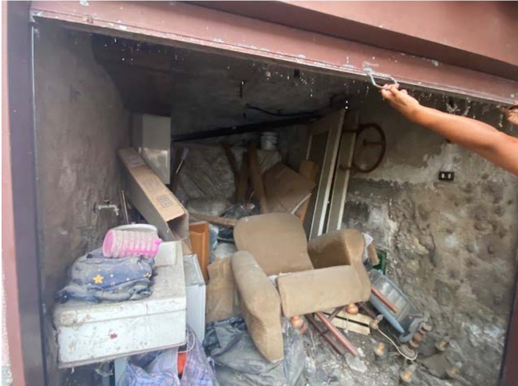
Foto 3_ Autorimessa (Bene n. 2)
