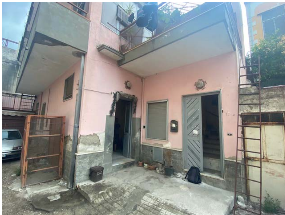
Foto 1_ Vista ingresso dal cortile Ugo di Fazio ( ingresso a destra )
