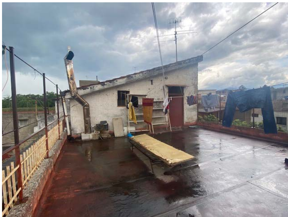
Foto 19_ Terrazzo di copertura - lastrico
