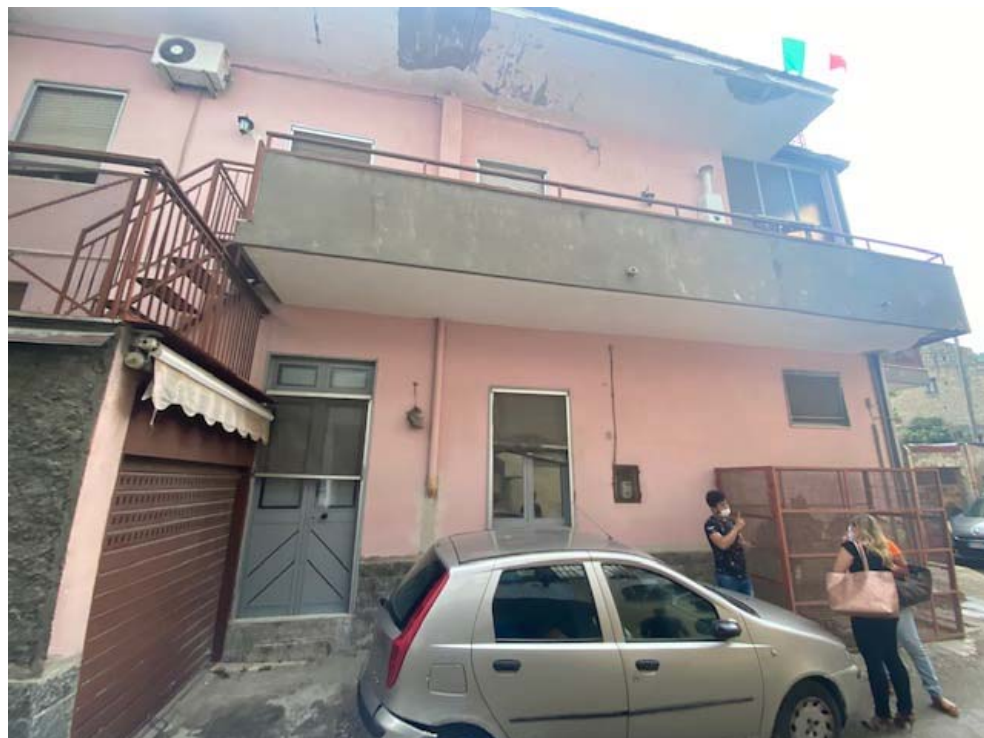
Foto D_ Vista del fabbricato lungo via Ferrari, cortile Ugo di Fazio
