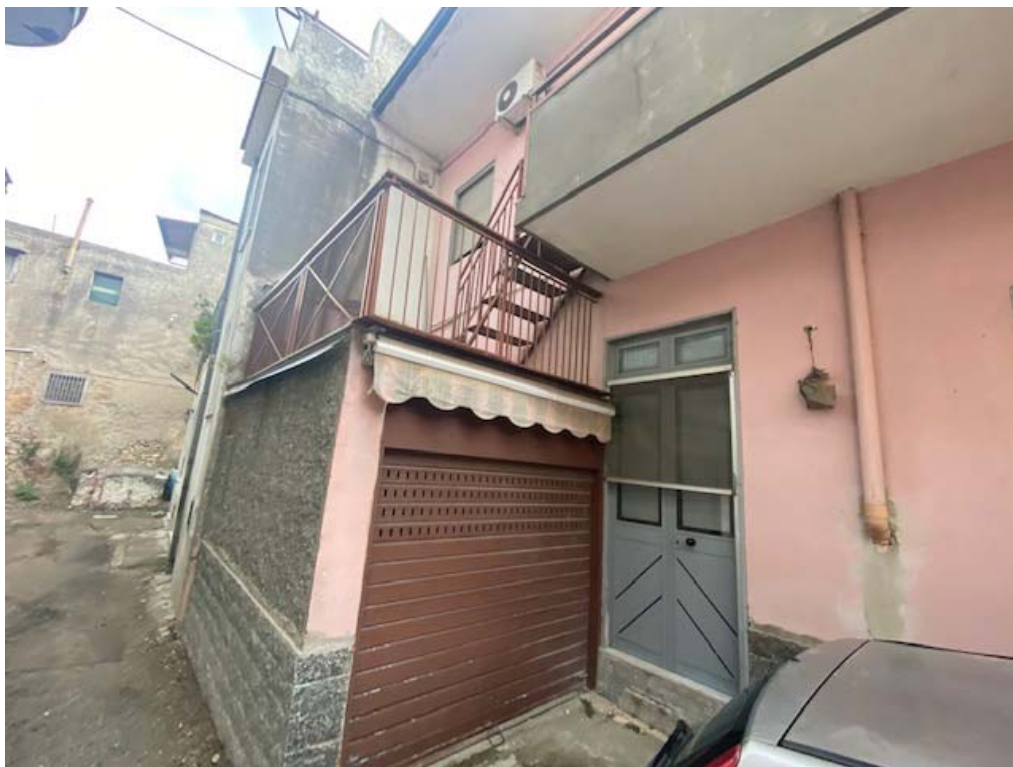
Foto 2_ Vista ingresso all'autorimessa
