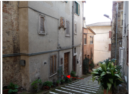
FOTO 3 - vista da via Regina Margherita
