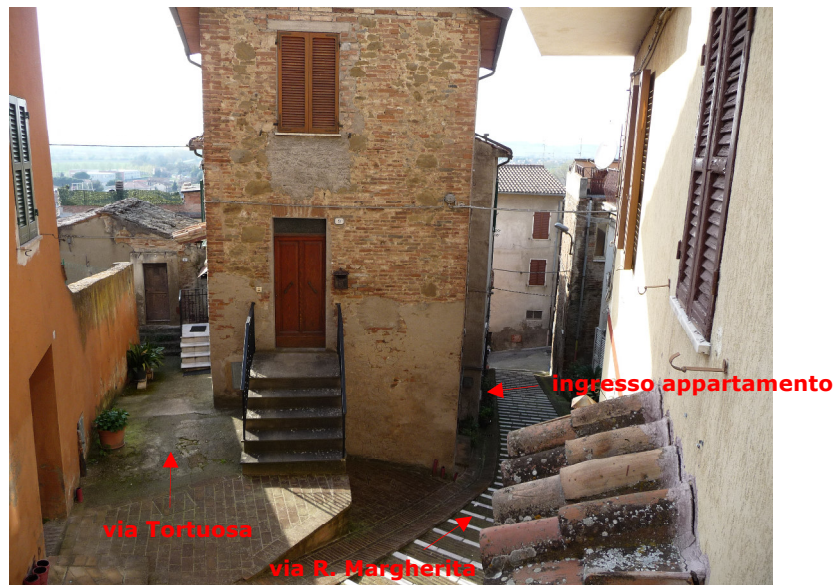
FOTO 1 - Fabbricato condominiale visto di testa
