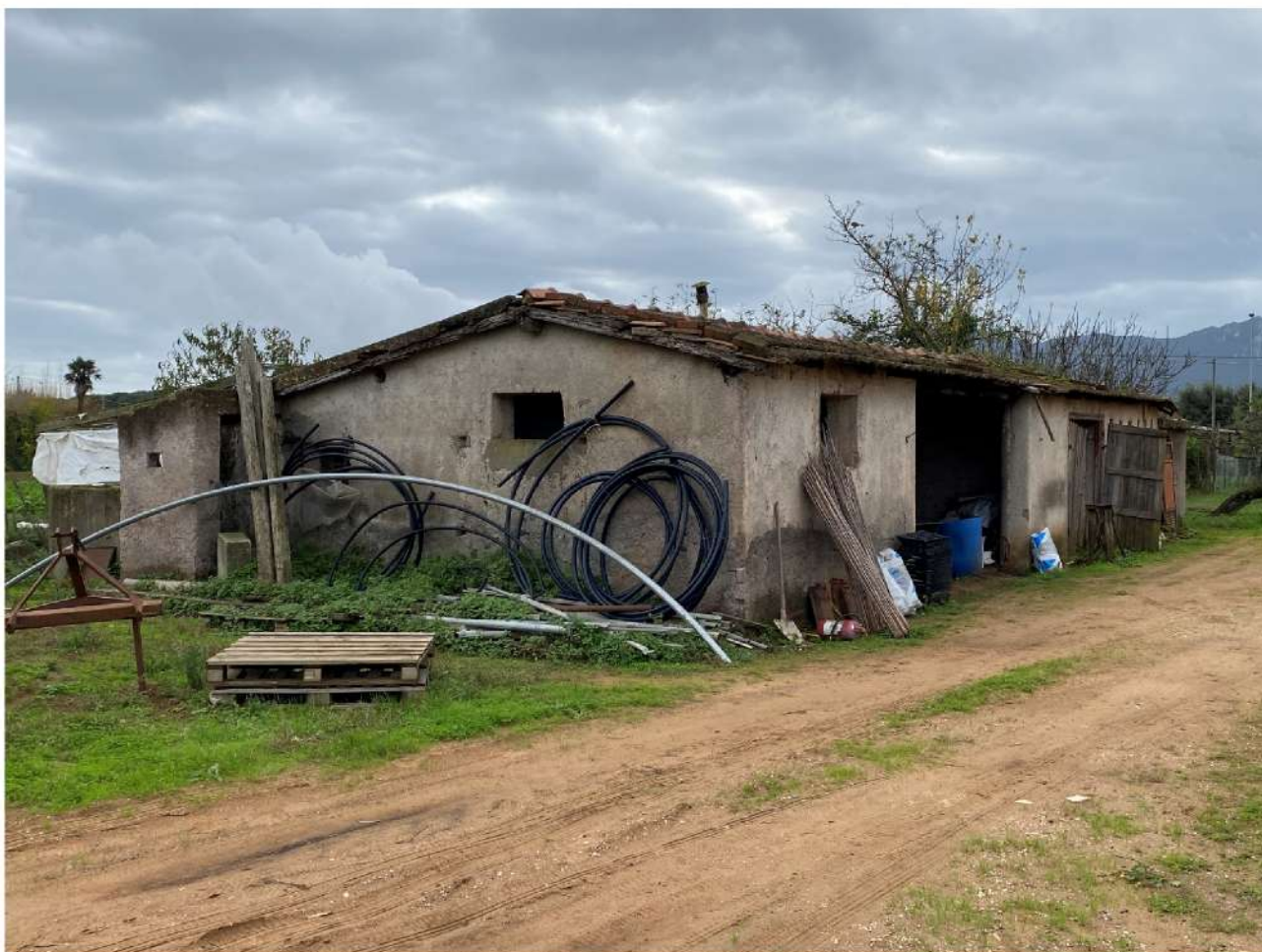
ESTERNO RAVVICINATO - FABBRICATO AD USO DEPOSITO LATO SUD-EST
