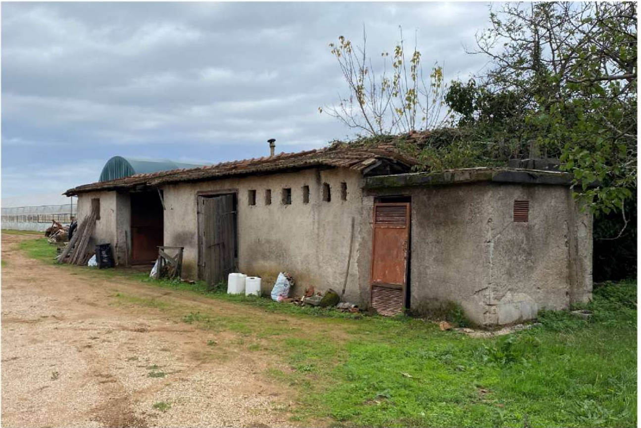
ESTERNO RAVVICINATO - FABBRICATO AD USO DEPOSITO LATO SUD-EST
