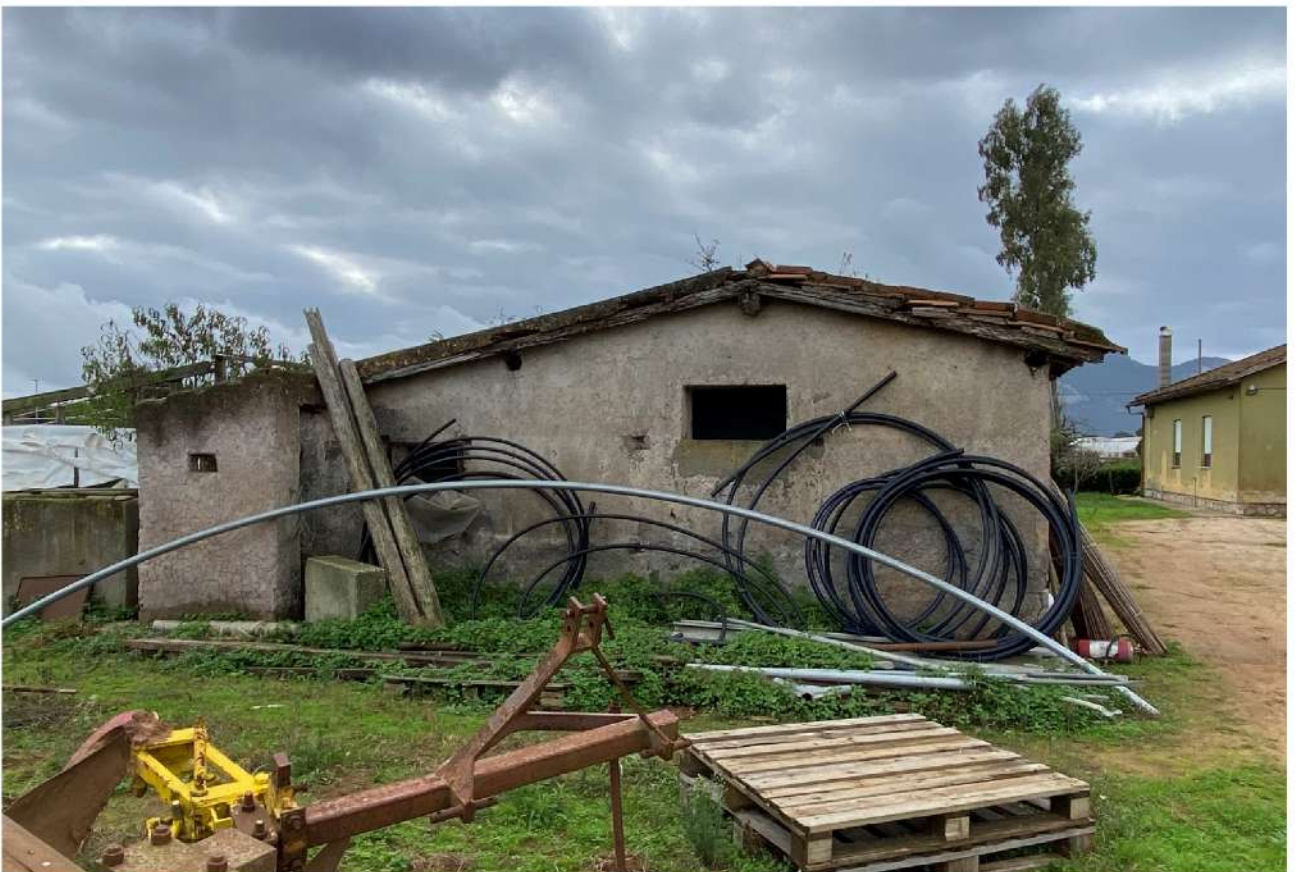
ESTERNO RAVVICINATO - FABBRICATO AD USO DEPOSITO LATO NORD
