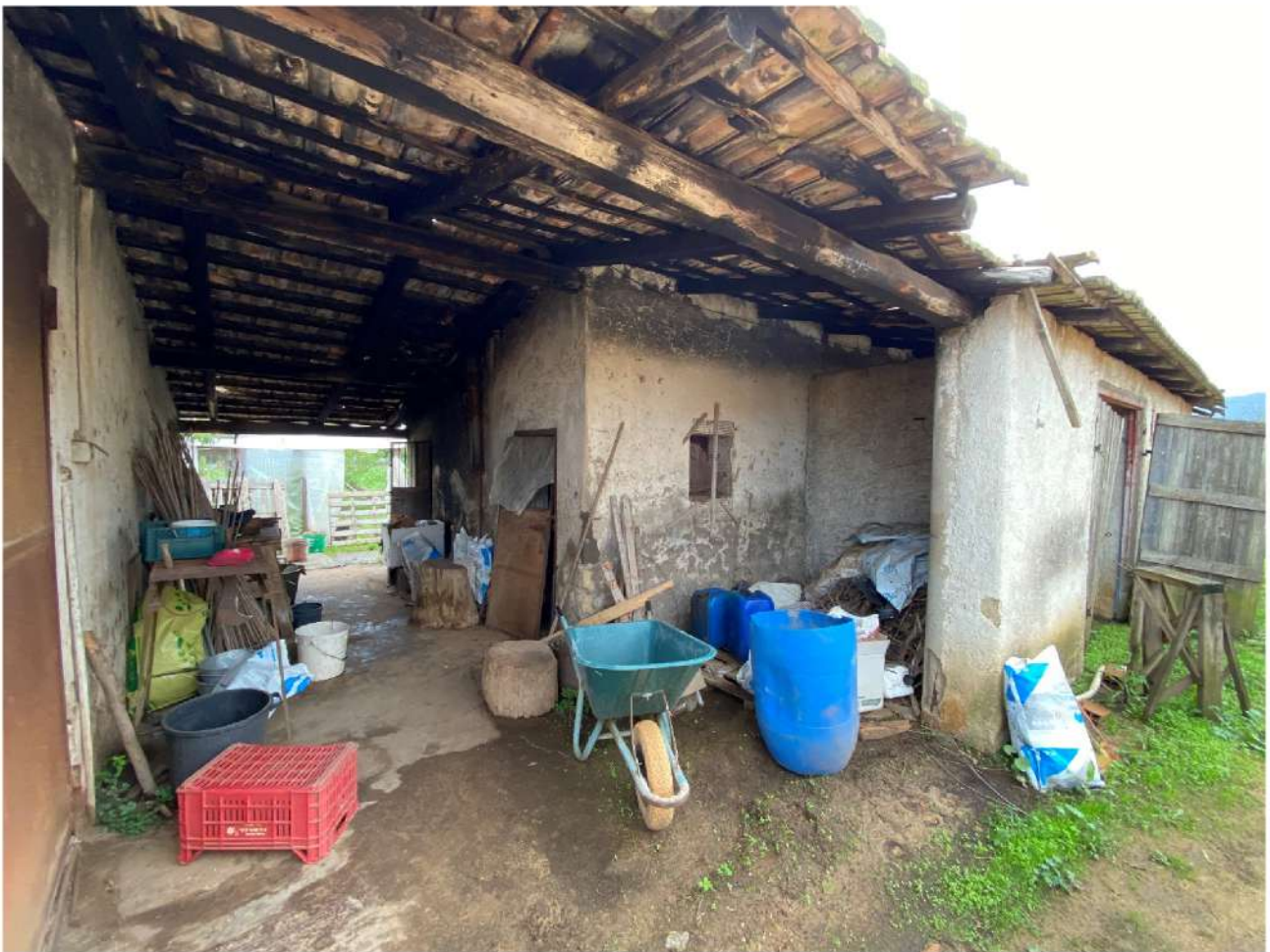
INTERNO RAVVICINATO – STATO DI CONSERVAZIONE FABBRICATO AD USO DEPOSITO
