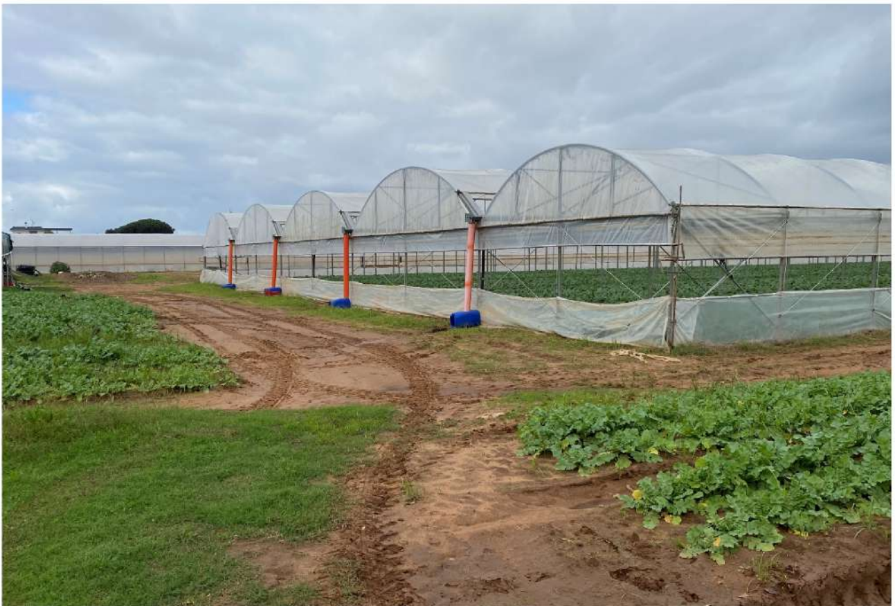
ESTERNO RAVVICINATO - BLOCCO DI SERRE E STRADONE DI ACCESSO
