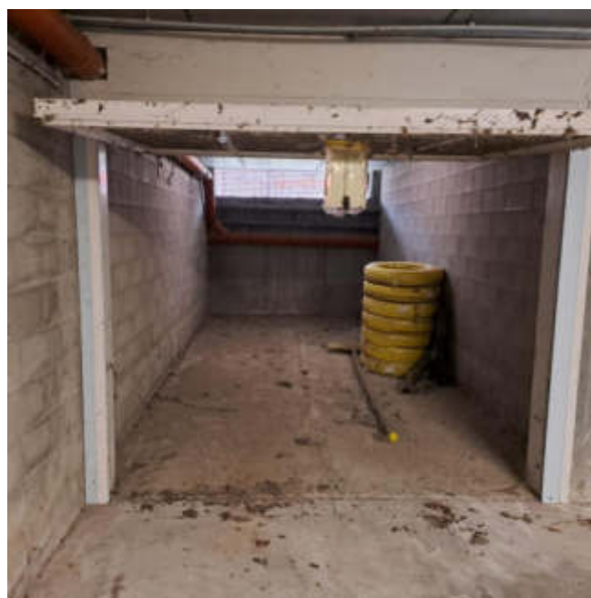
Foto 14 – Autorimessa al sub 60
