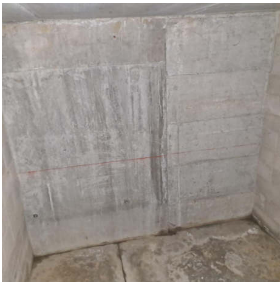
Foto 17 – Cantina al sub 31 – PS1-
