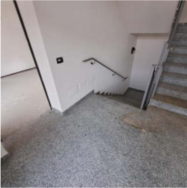
Foto 3 – Vano scala e porta d'ingresso al sub 31
