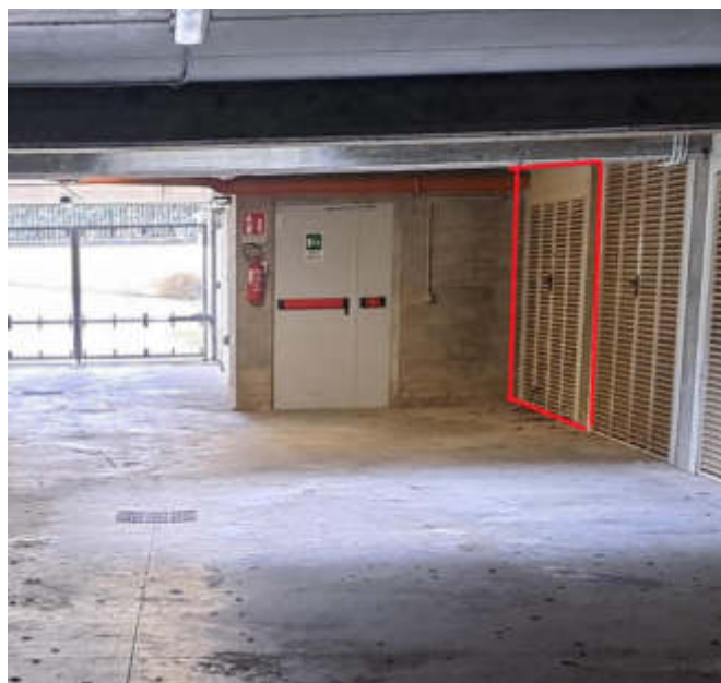
Foto 12 – Autorimessa al sub 60
