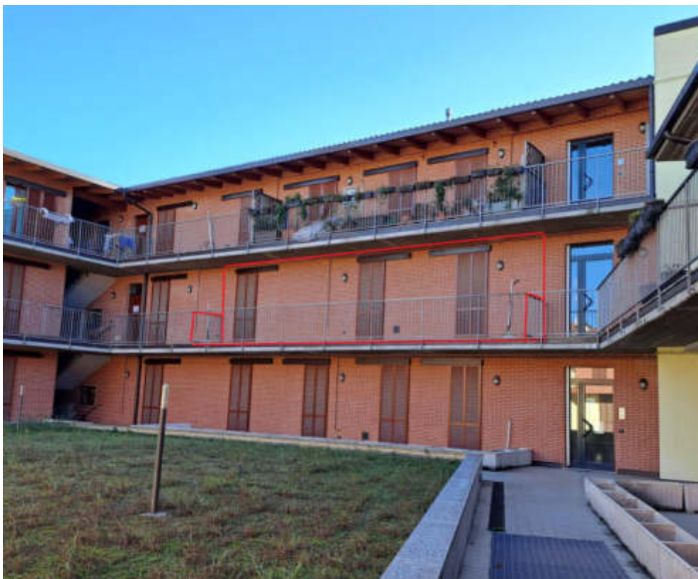
Foto 1 – Abitazione al sub 31 –P1- ed ingresso condominiale dalla corte interna – Lato nord
