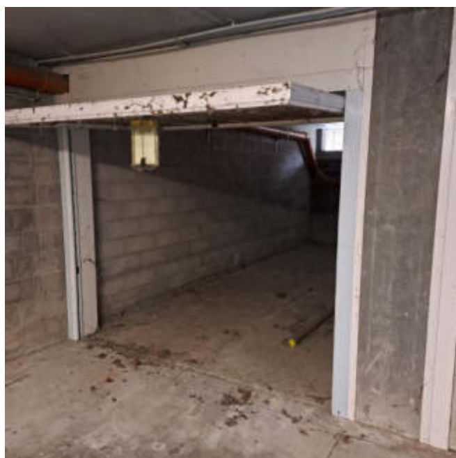
Foto 13 – Autorimessa al sub 60
