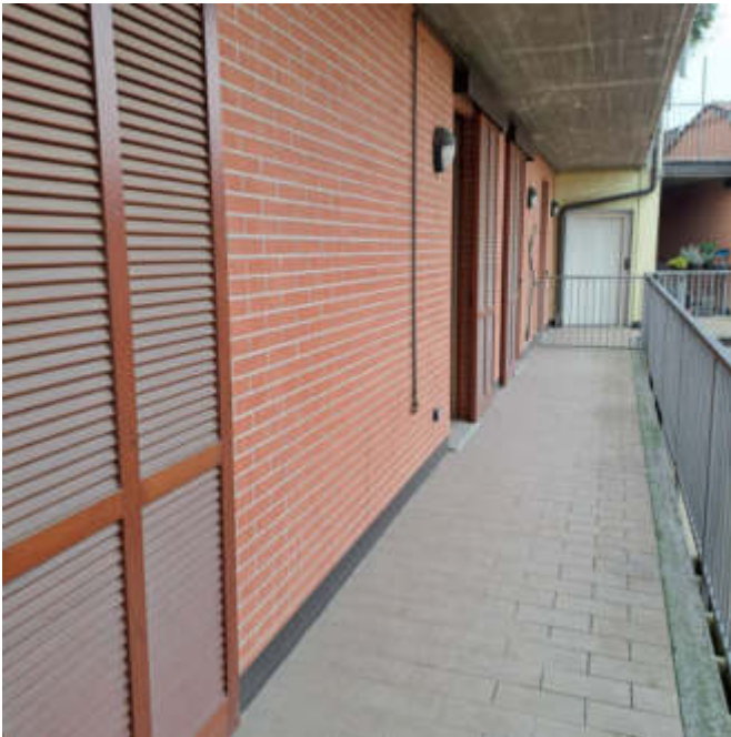
Foto 9 – Balcone al piano primo - sub 31
