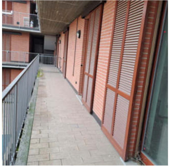
Foto 8 – Balcone al piano primo - sub 31
