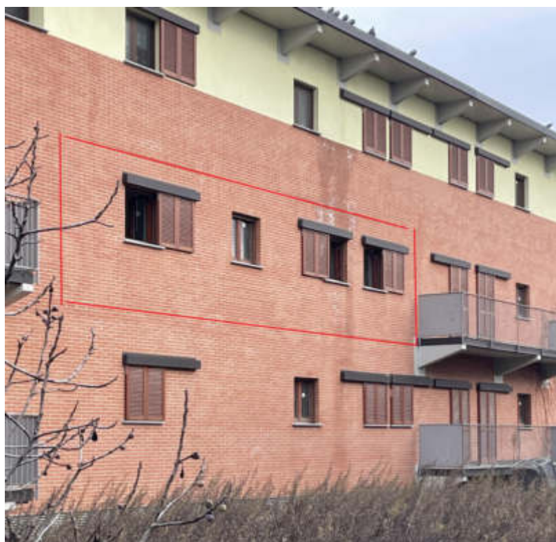
Foto 2 – Abitazione al sub 31 – Lato sud
