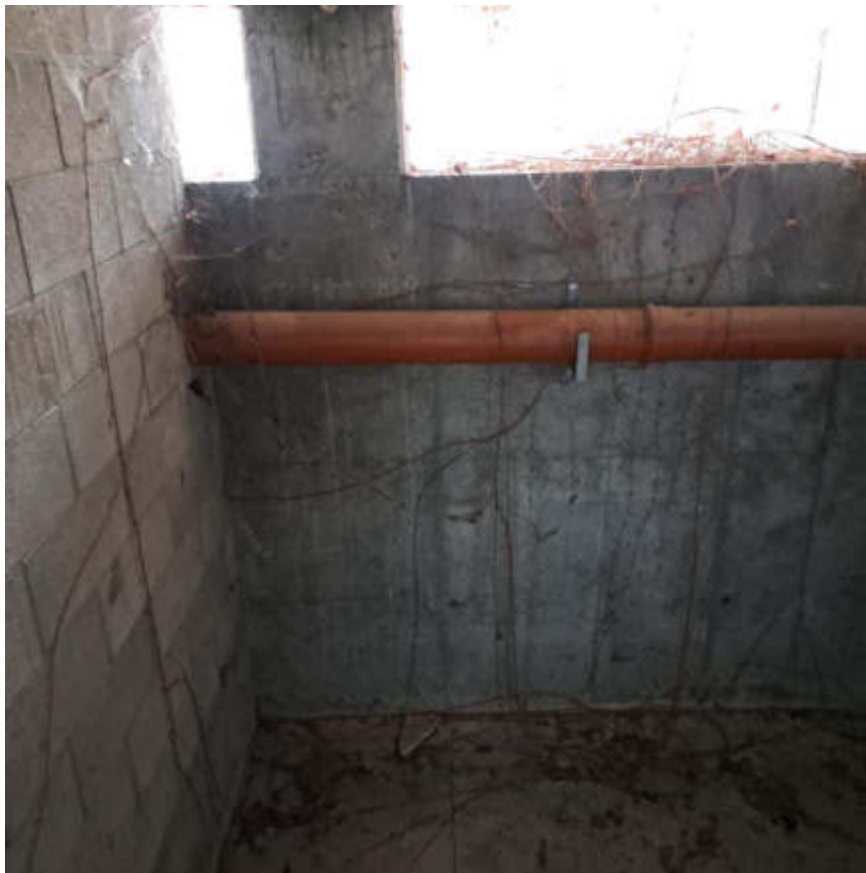
Foto 17 – Cantina al sub 29
