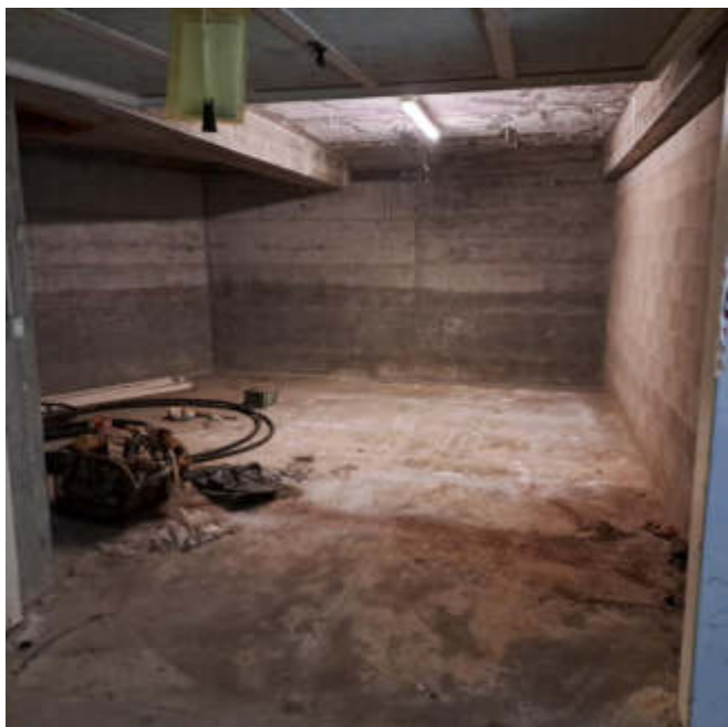
Foto 13 – Autorimessa al sub 55
