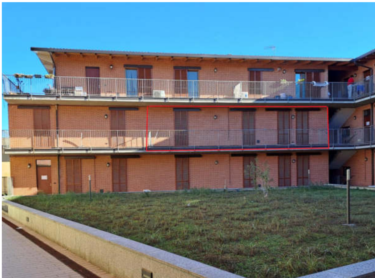
Foto 1 – Abitazione al sub 28 dalla corte interna – Lato nord
