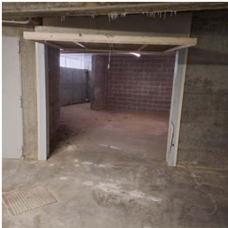
Foto 17 – Autorimessa al sub 56 al PS1
