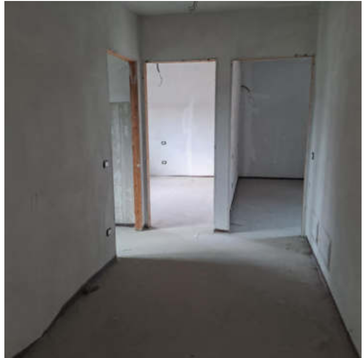
Foto 9 – Disimpegno al sub 30
