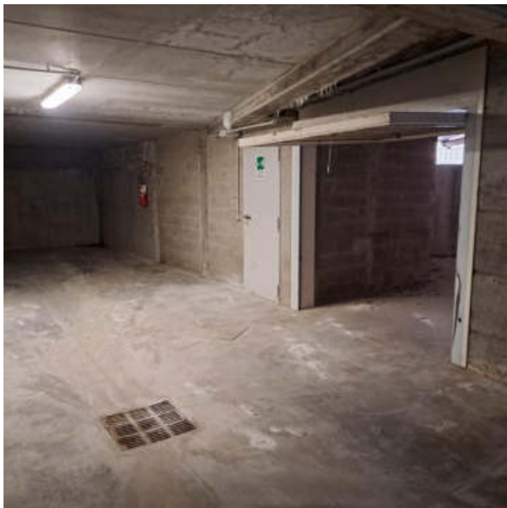
Foto 16 – Autorimessa al sub 56 al PS1
