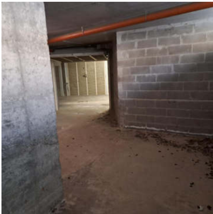
Foto 18 – Autorimessa al sub 56 al PS1-Interno
