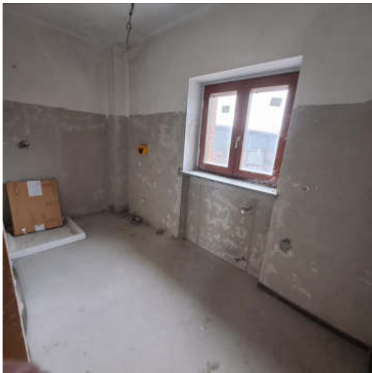
Foto 12 – Bagno al sub 30 P1
