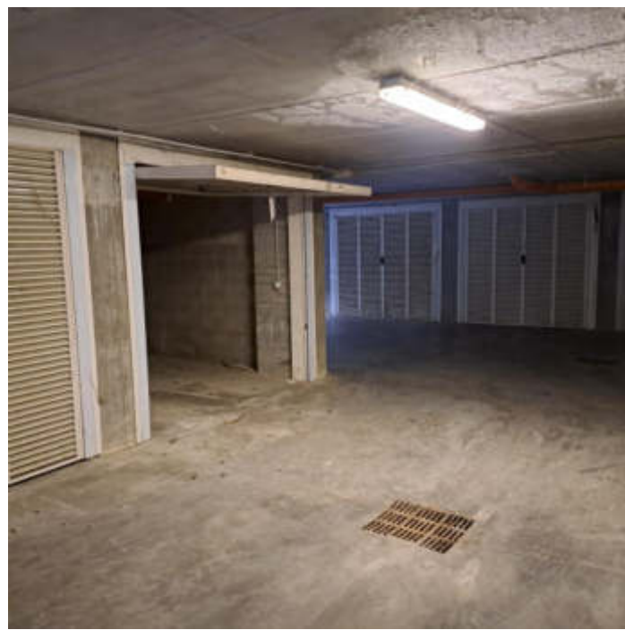
Foto 14 – Autorimessa al sub 50
