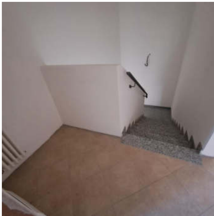
Foto 8 – Arrivo scala e disimpegno al P1
