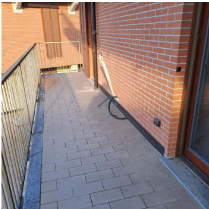
Foto 11 – Balcone al P1
