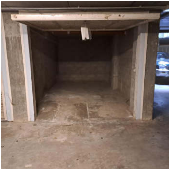
Foto 15 – Autorimessa al sub 50
