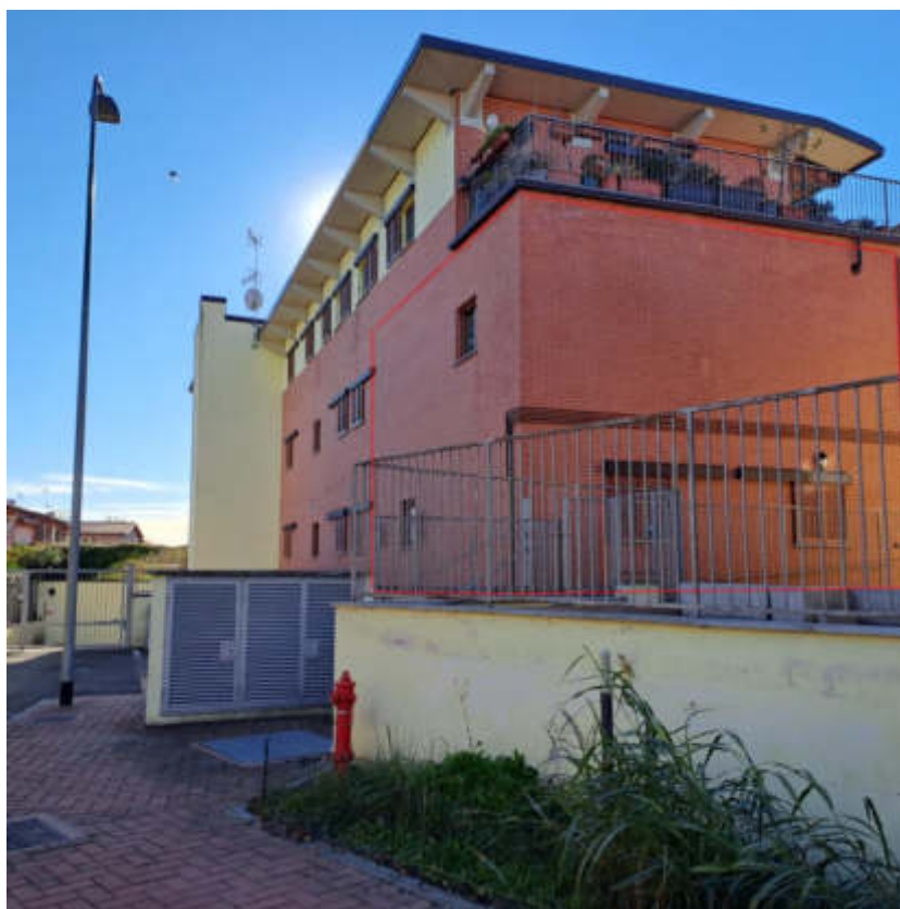
Foto 2 – Abitazione al sub 24 dalla strada privata di accesso alle autorimesse – Lato nord-est
