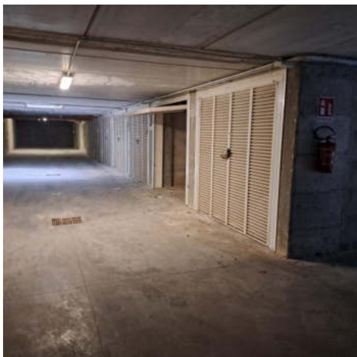
Foto 17 – Autorimessa al sub 51
