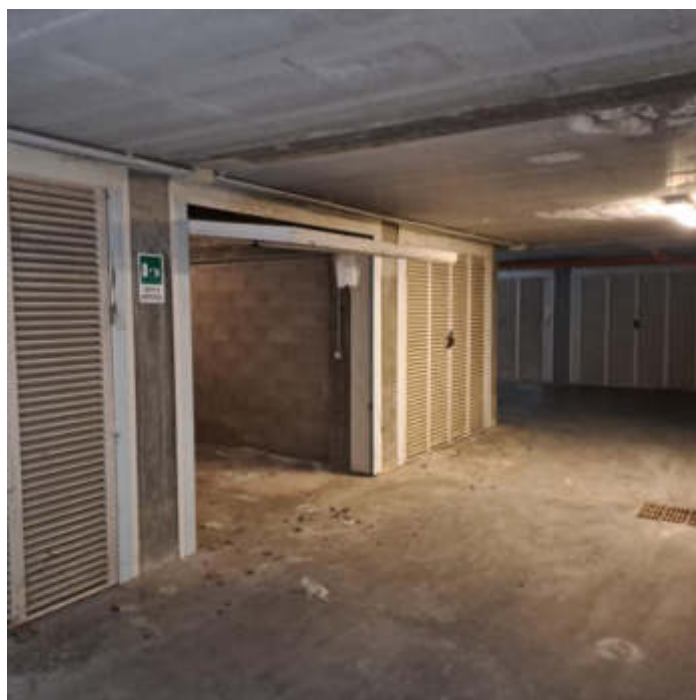
Foto 18 – Autorimessa al sub 51
