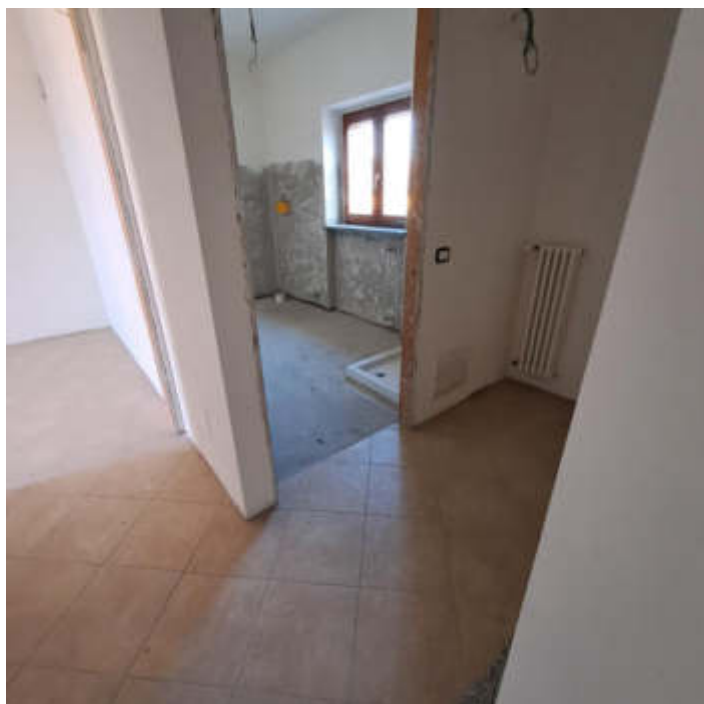
Foto 9 – Bagno al P1
