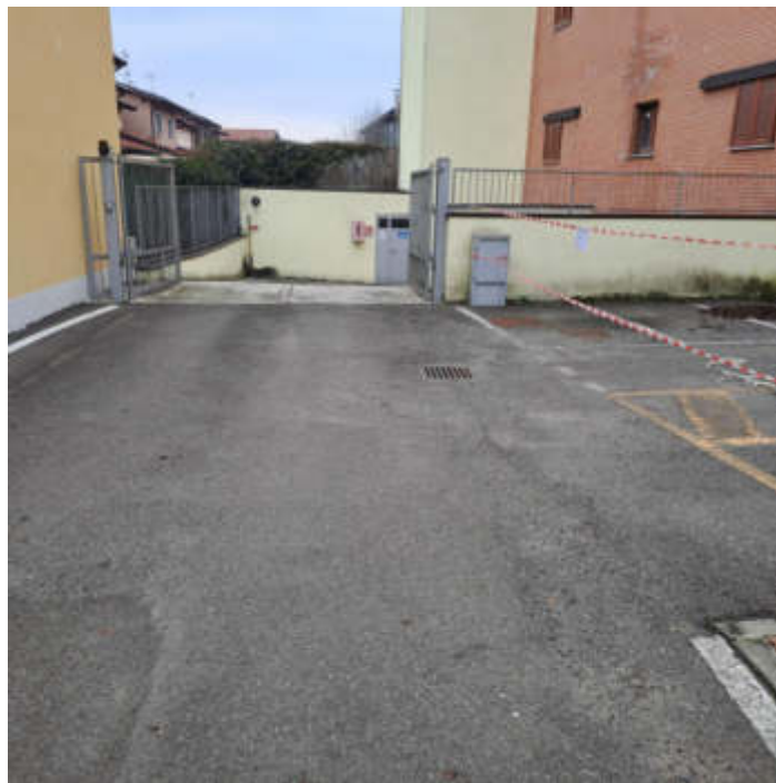
Foto 12 – Strada di accesso al piano interrato.
