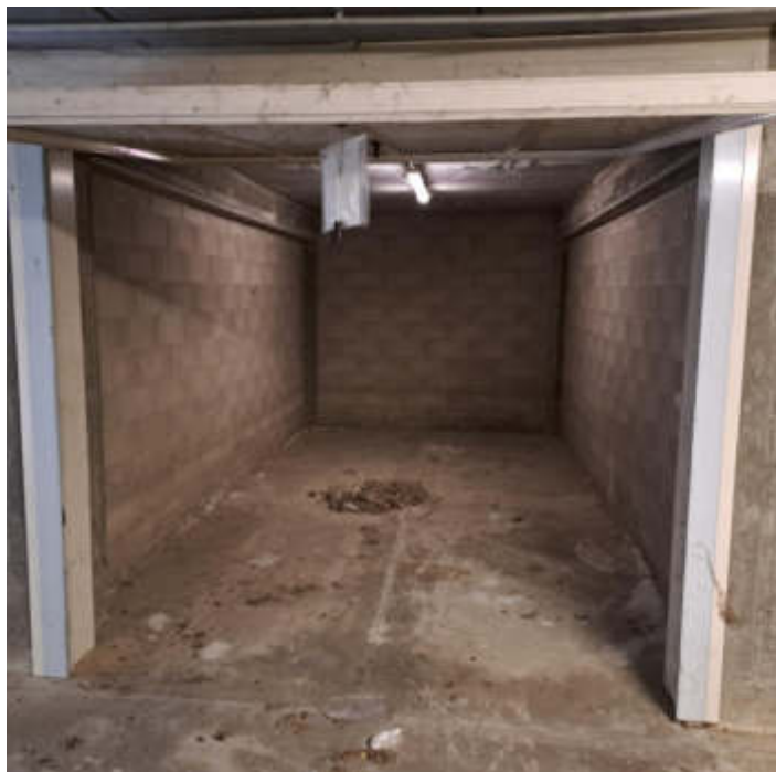
Foto 19 – Autorimessa al sub 51
