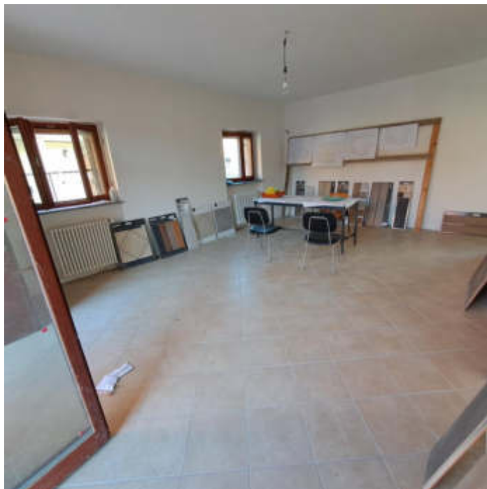
Foto 4 – Soggiorno del sub 24
