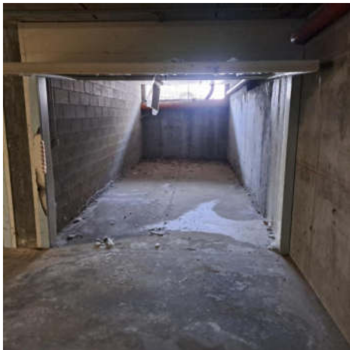
Foto 19 – Garage al sub 49 al piano S1
