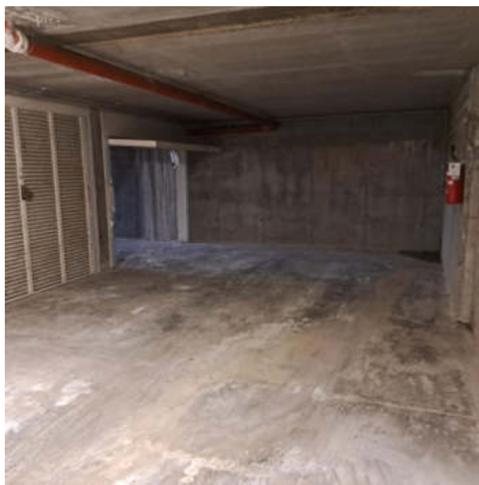
Foto 18 – Garage al sub 49 al piano S1.
