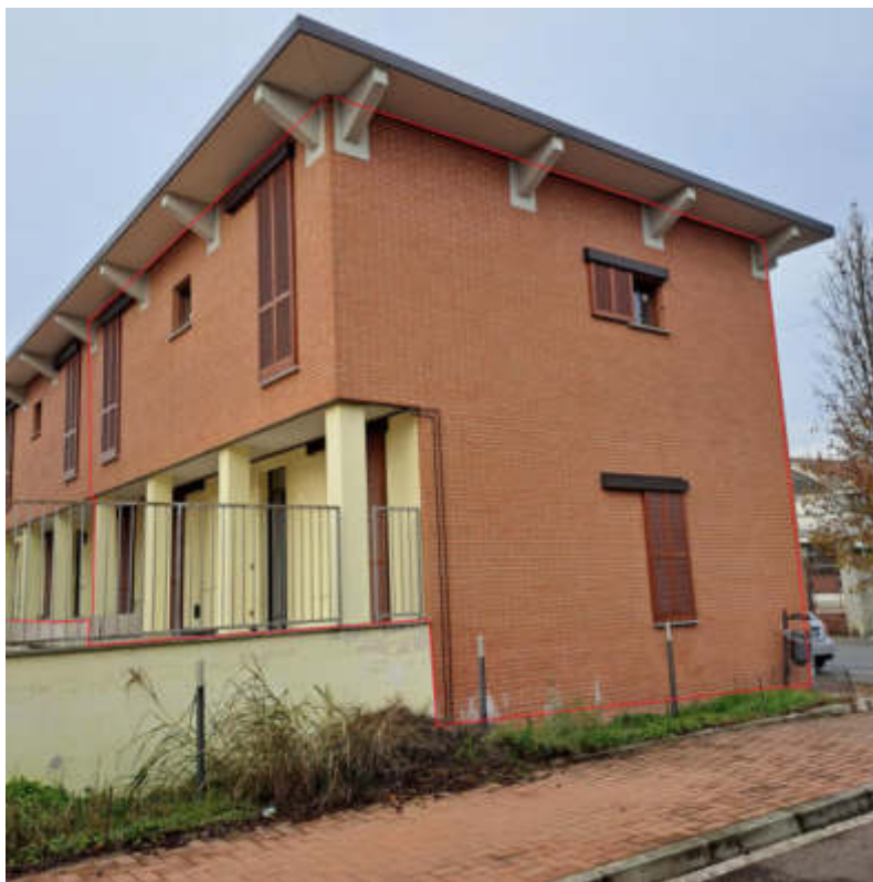
Foto 2 – Abitazione al sub 23 dalla strada di accesso alle autorimesse – Lato est
