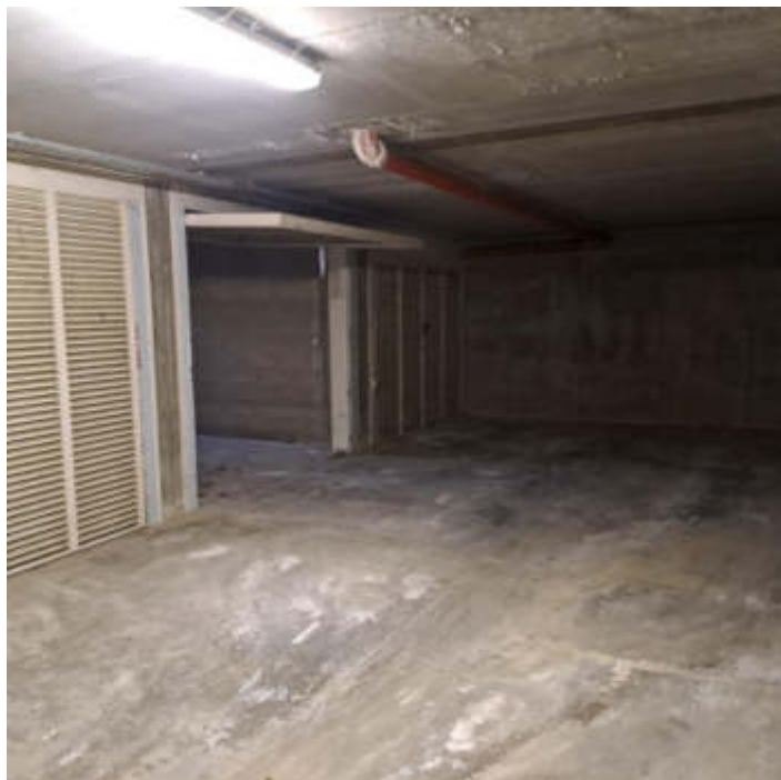
Foto 15 – Garage al sub 48 al piano S1
