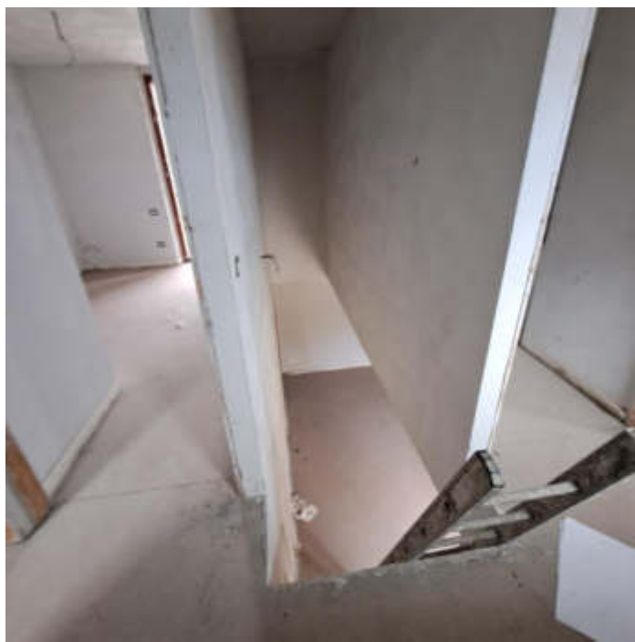
Foto 6 – Disimpegno al piano primo
