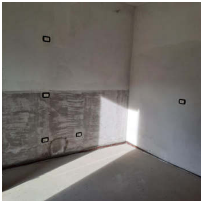
Foto 5 – Cucina al piano terra
