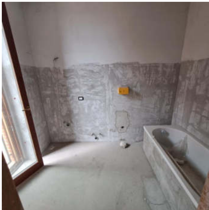
Foto 8 – Bagno al piano primo al sub 23
