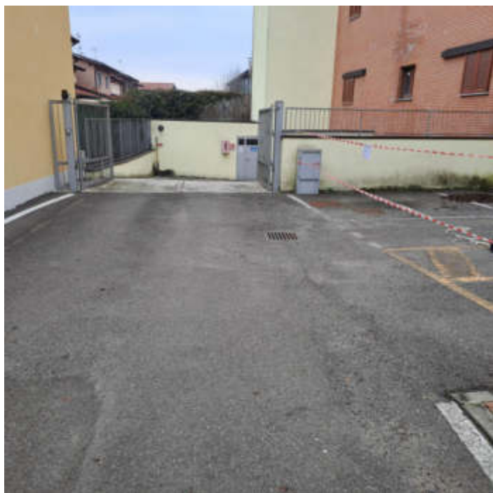
Foto 13 – Strada di accesso al piano interrato.
