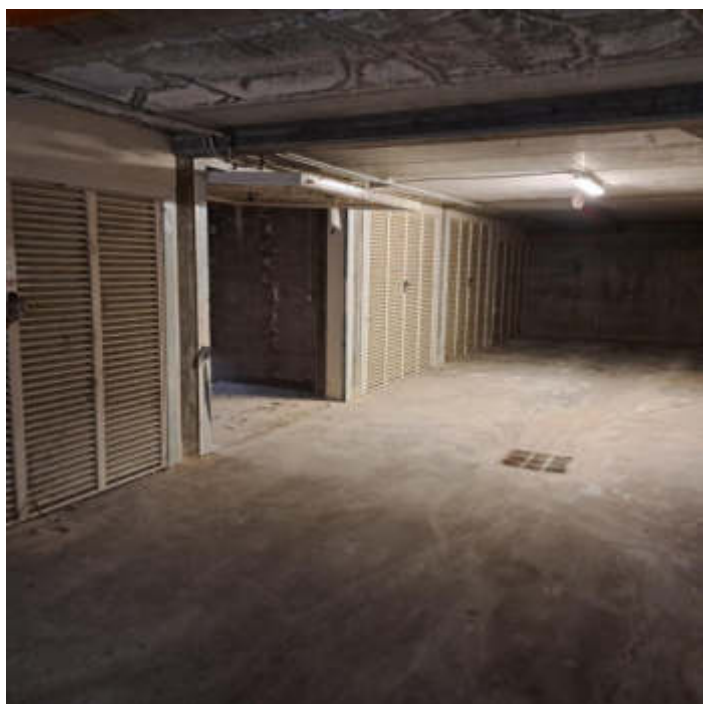
Foto 18 – Autorimessa al piano semi-interrato al sub 46
