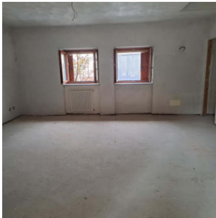
Foto 4 – Locale soggiorno al sub 22
