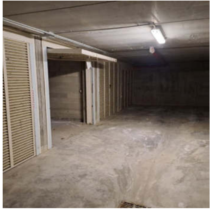
Foto 21 – Autorimessa al piano semi-interrato al sub 46
