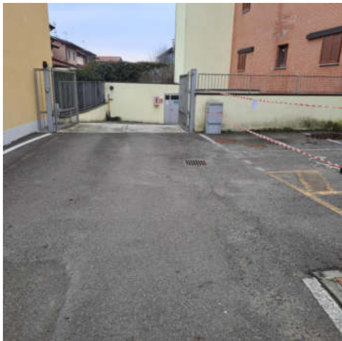
Foto 16 – Strada di accesso al piano interrato.
