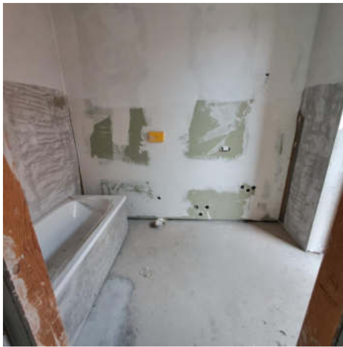
Foto 13 – Bagno al piano primo sub 22
