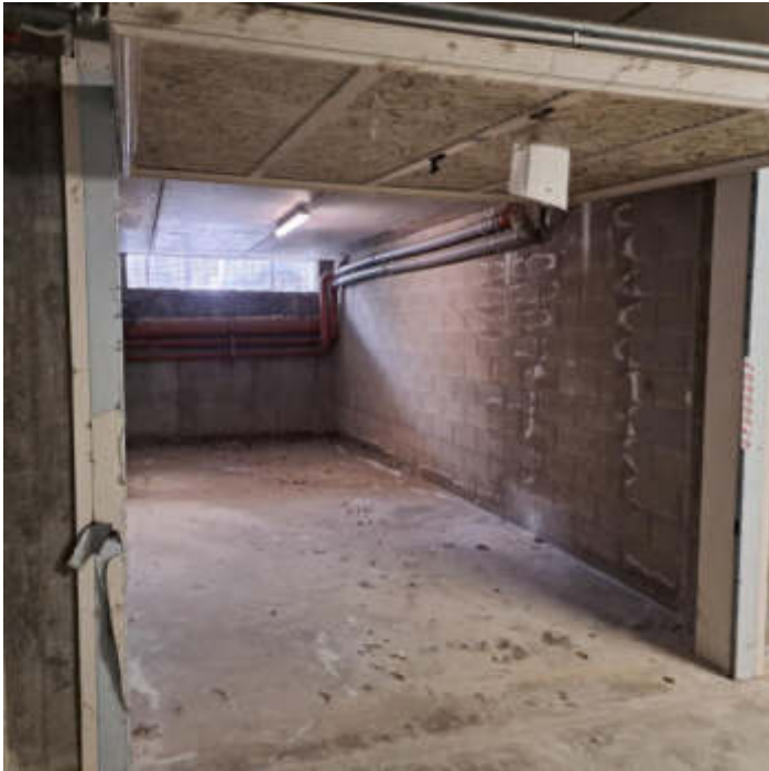
Foto 20 – Autorimessa al piano semi-interrato al sub 46
