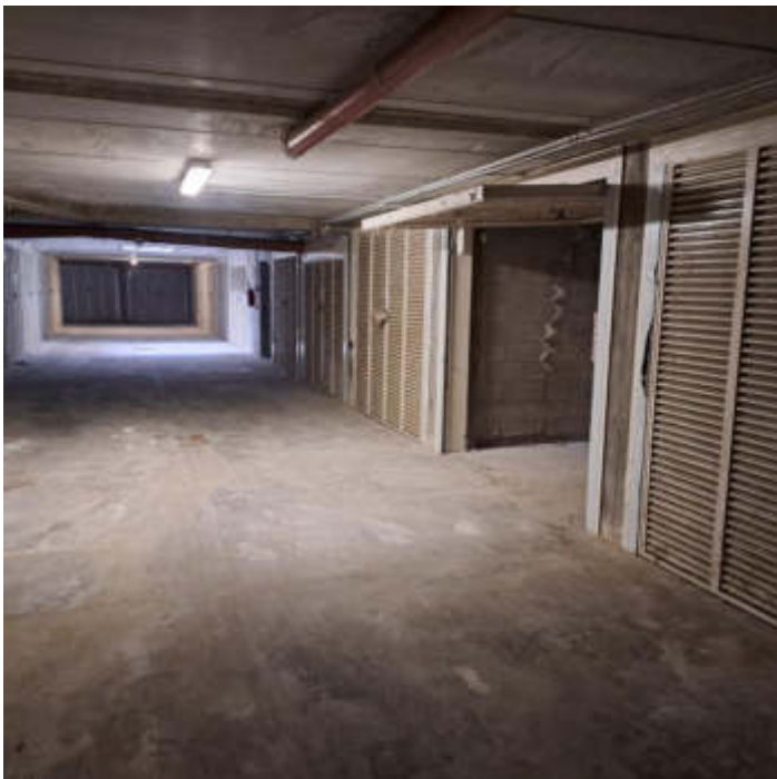
Foto 22 – Autorimessa al piano semi-interrato al sub 47
