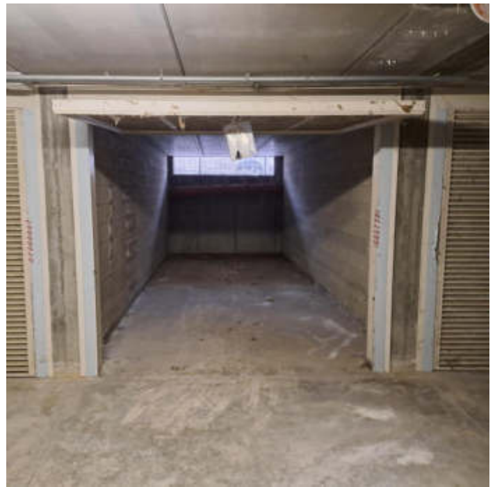
Foto 23 – Autorimessa al piano semi-interrato al sub 47
