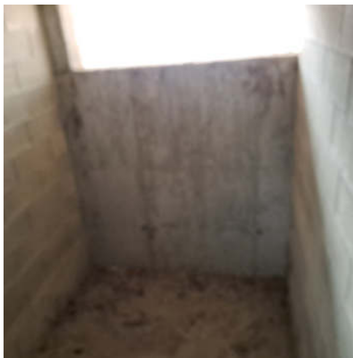
Foto 27 – Cantina al piano semi-interrato al sub 22
