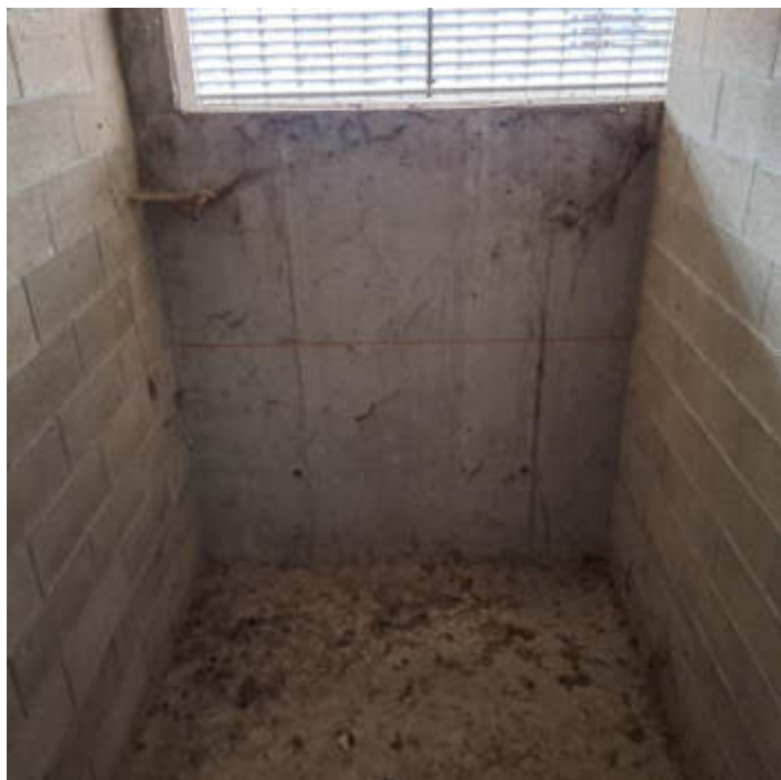
Foto 21 – Autorimessa al piano interrato – sub 21
