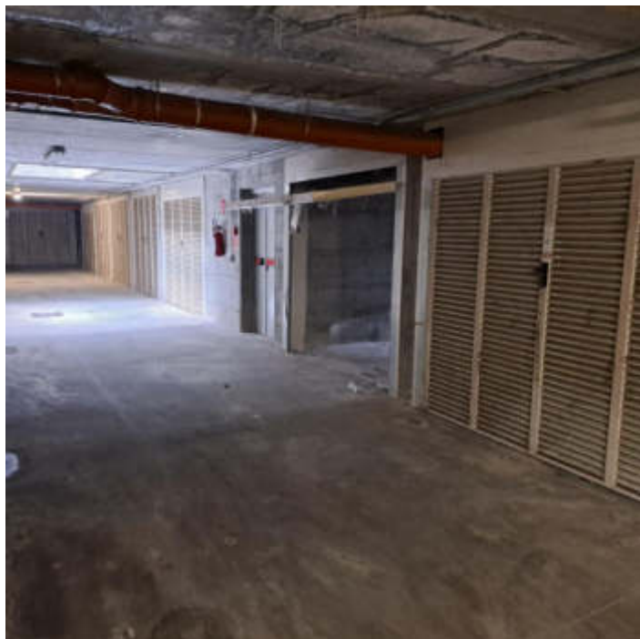
Foto 15 – Autorimessa al piano interrato – sub 44
