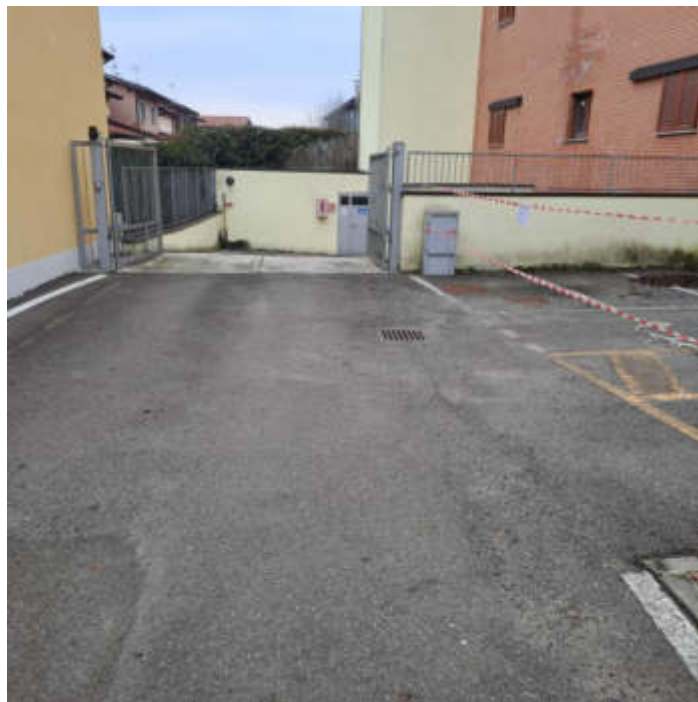
Foto 12 – Strada di accesso al piano interrato.
