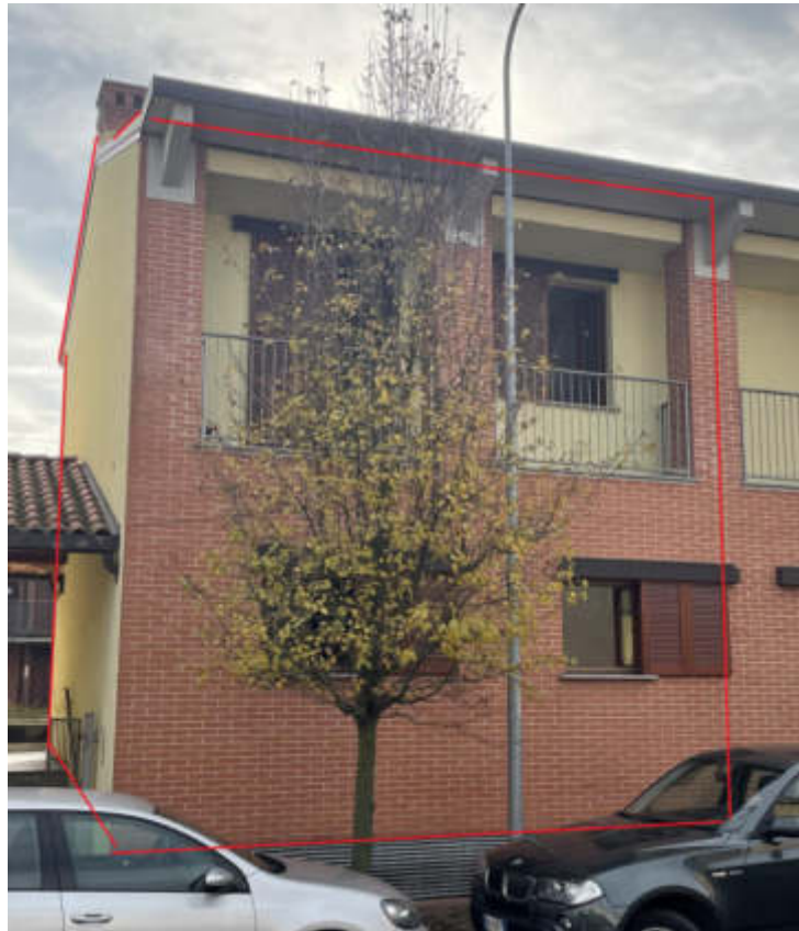
Foto 1 – Abitazione al sub 21 da Via Riviera – Lato nord
