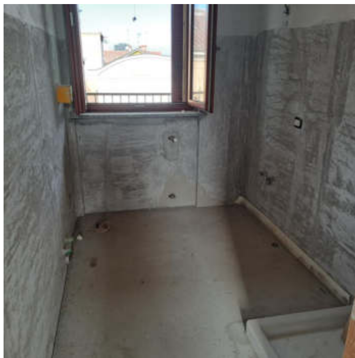
Foto 10 – Bagno al piano primo
