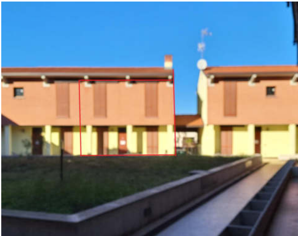
Foto 2 – Abitazione al sub 21 da Via Riviera – Lato sud
