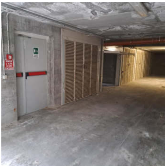
Foto 17 – Autorimessa al piano interrato – sub 45
