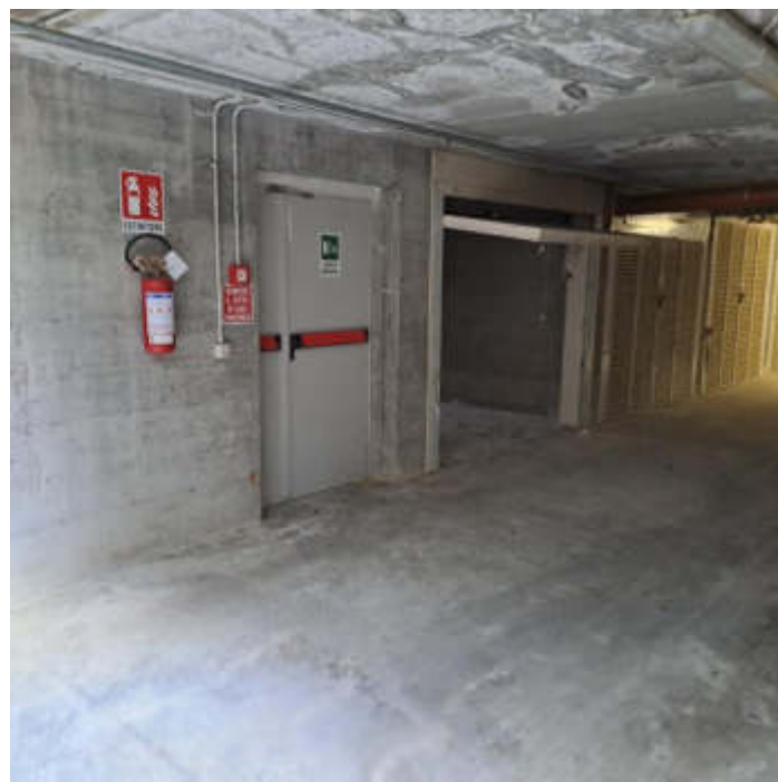
Foto 14 – Autorimessa al piano interrato – sub 44
