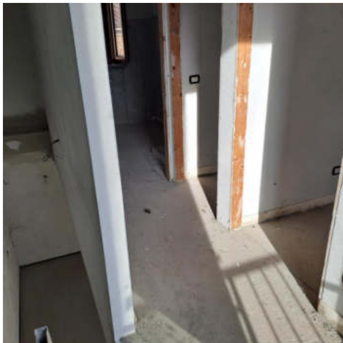
Foto 7 – Disimpegno al piano primo
