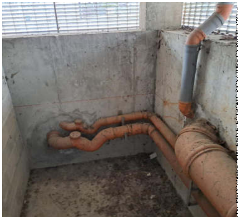
Foto 22 – Autorimessa al piano interrato – sub 65
