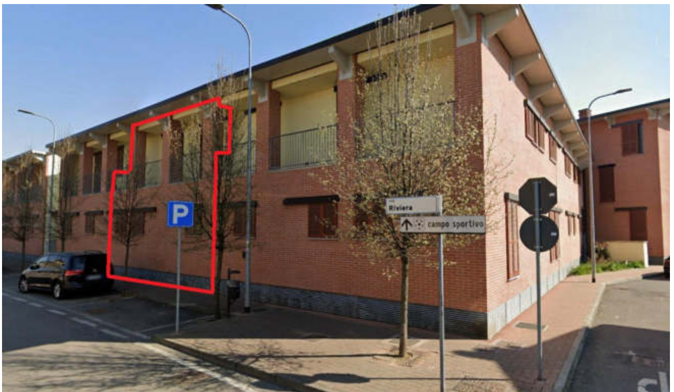
Foto 2 – Abitazione al sub 20 dalla Via Riviera – Lato nord
