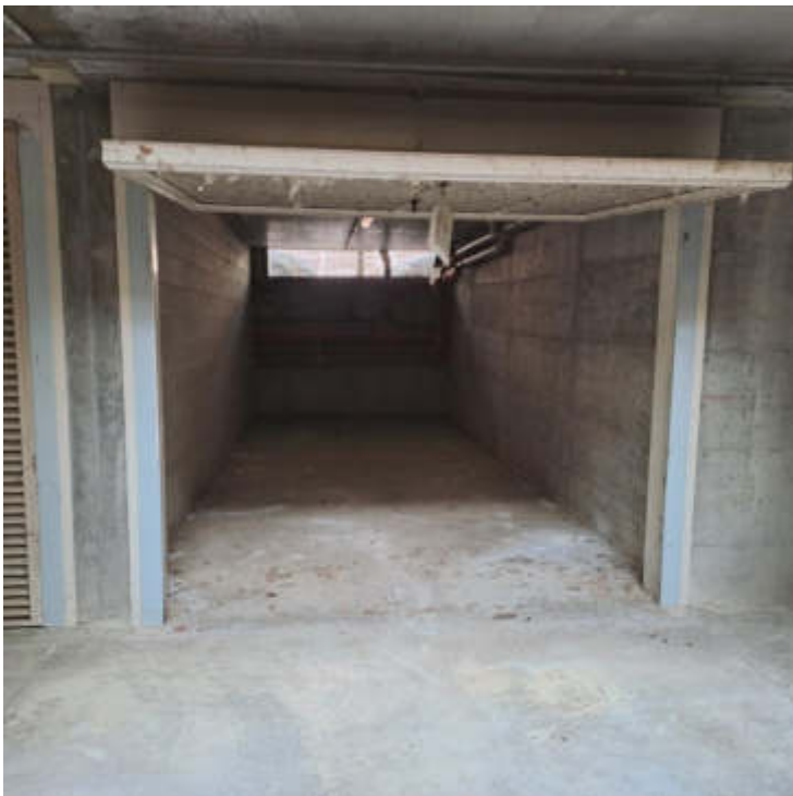
Foto 17 – Autorimessa al sub 14 – PS1
