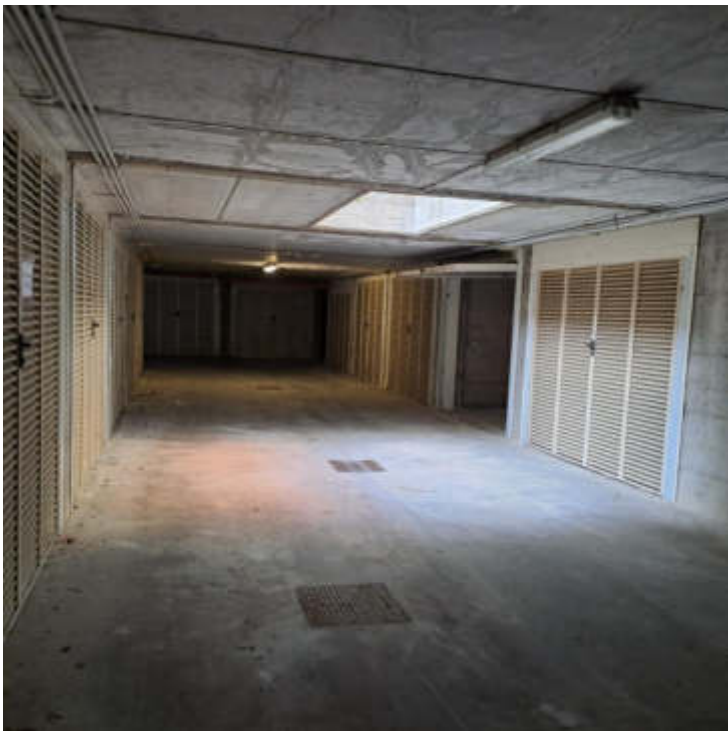
Foto 21 – Autorimessa al sub 14 – PS1
