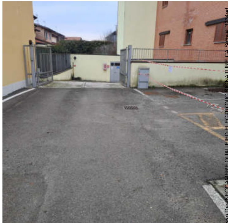
Foto 14 – Strada di accesso al piano interrato.
