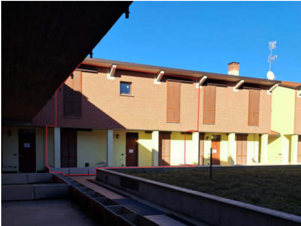
Foto 1 – Abitazione al sub 20 dalla corte interna – Lato sud
