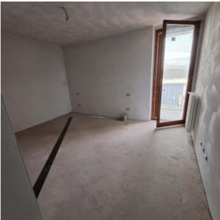
Foto 9 - Camera singola 1 al sub 20 - P1
