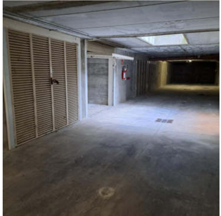
Foto 16 – Autorimessa al sub 14 – PS1
