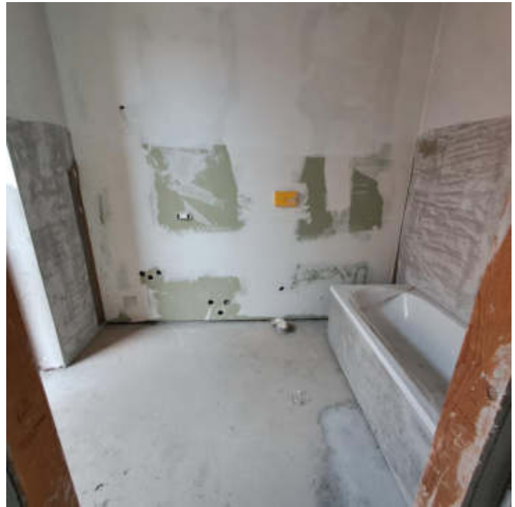
Foto 12 – Bagno al sub 20 – P1
