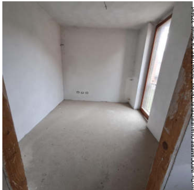
Foto 10 - Camera singola 2 al sub 20 - P1
