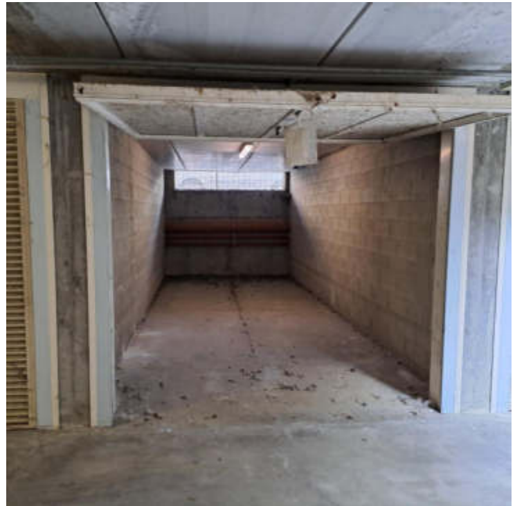
Foto 20 – Autorimessa al sub 43 – PS1
