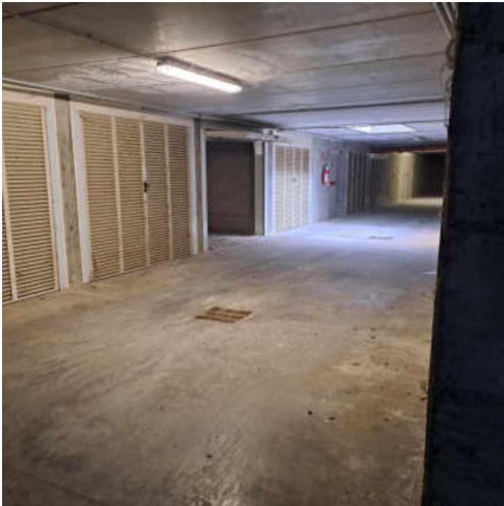
Foto 19 – Autorimessa al sub 43 – PS1
