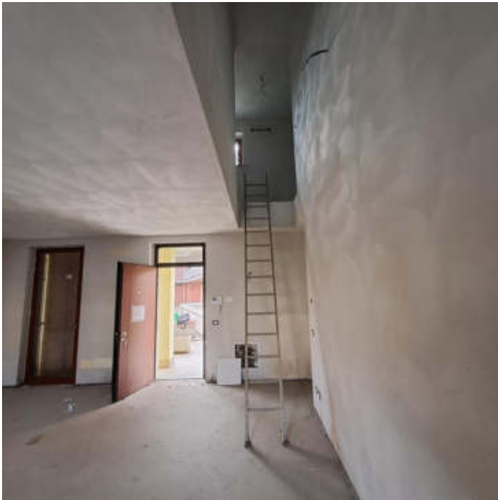
Foto 7 - Vano scala per access al piano primo al sub 20
