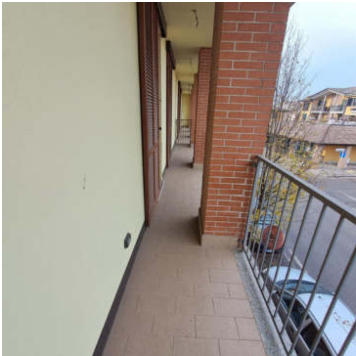
Foto 13 – Balcone al sub 20 – P1 – Lato nord
