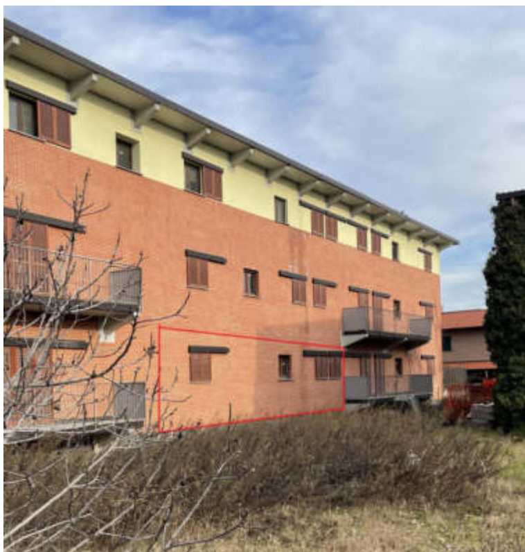
Foto 2 – Abitazione al sub 27 – Lato sud
