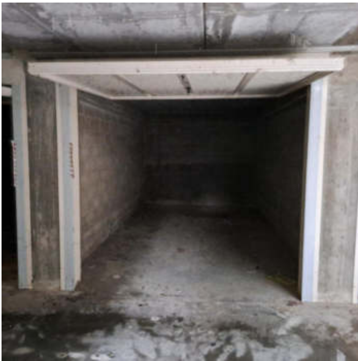
Foto 13 – Autorimessa al sub 54 PS1
