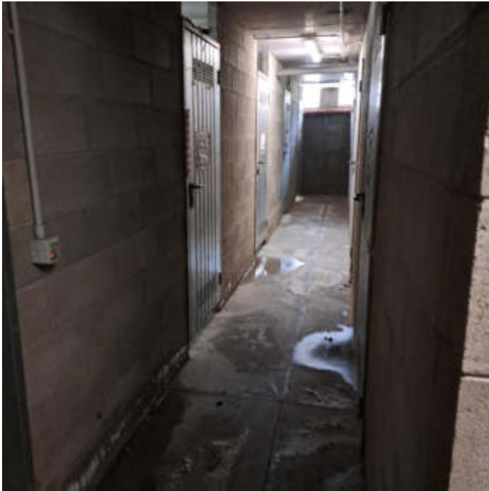
Foto 15 – Corridoio comune cantina al PS1
