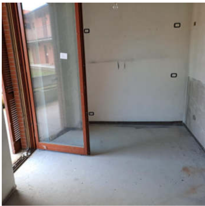
Foto 5 – Cucina al sub 27 PT
