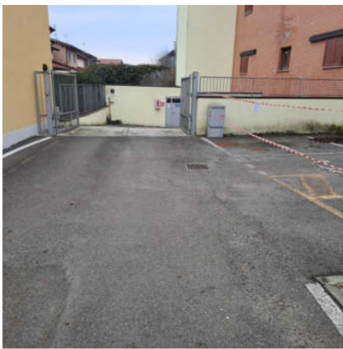
Foto 10 – Strada di accesso al piano interrato
