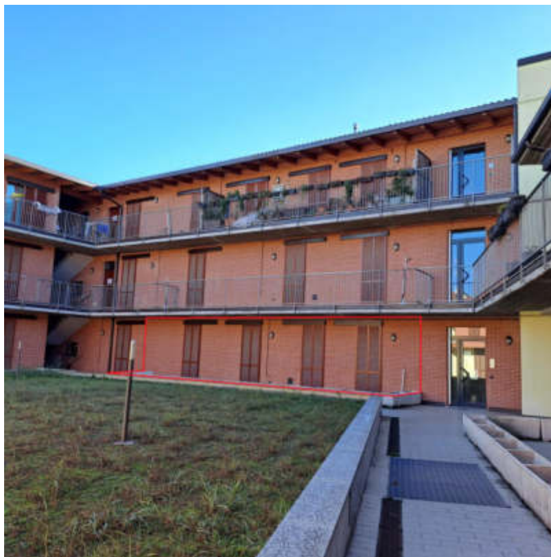
Foto 1 – Abitazione al sub 27 dalla corte interna – Lato nord
