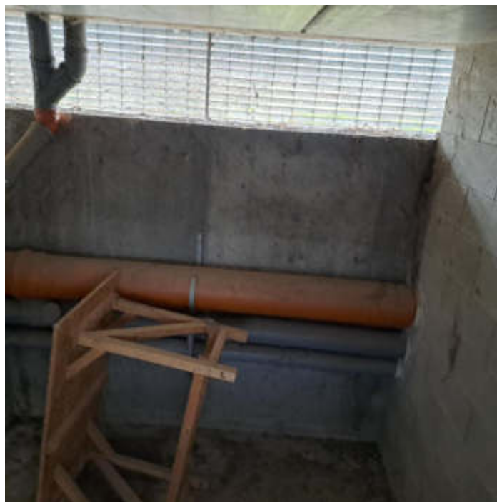
Foto 17 – Cantina al sub 27 PS1
