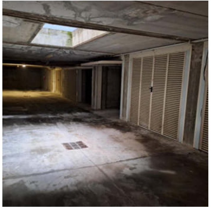
Foto 12 – Autorimessa al sub 54 PS1
