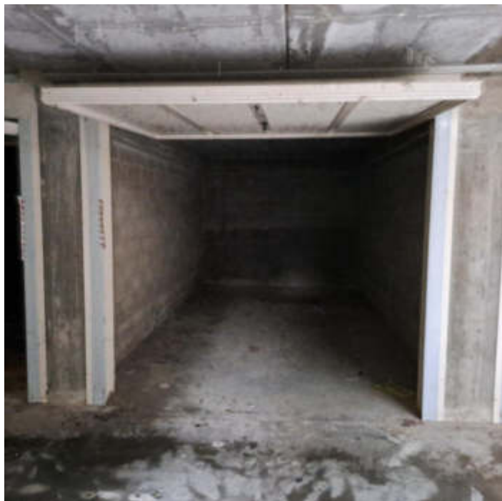
Foto 16 – Garage al sub 53 – PS1
