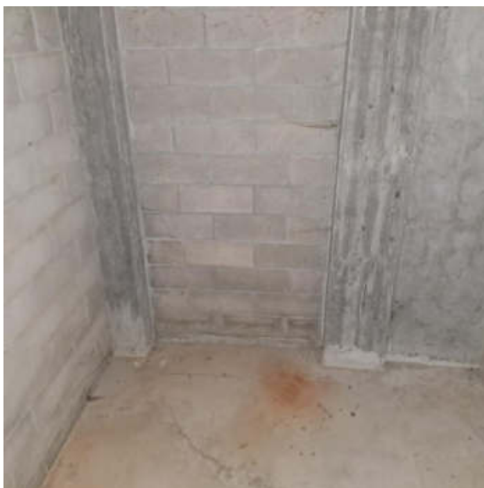
Foto 19 – Cantina al sub 26 PS1
