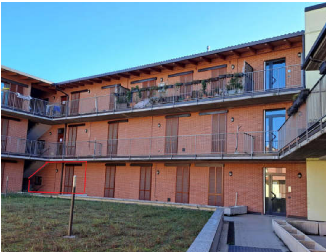
Foto 1 – Abitazione al sub 26 dalla corte interna – Lato nord
