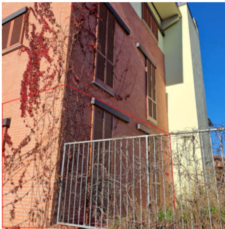
Foto 3 – Abitazione al sub 26 – Lato est
