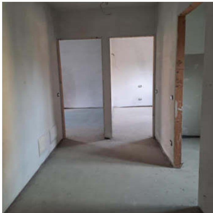
Foto 8 – Disimpegno del sub 25
