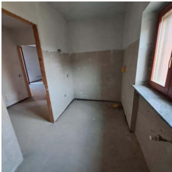
Foto 12– Bagno del sub 25
