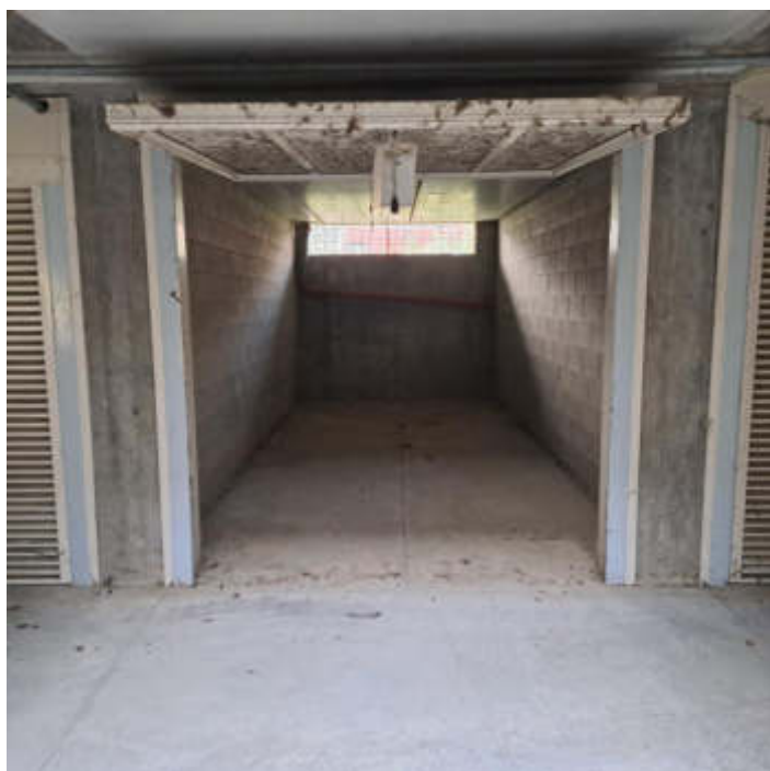
Foto 17 – Autorimessa al sub 37 – Piano S1
