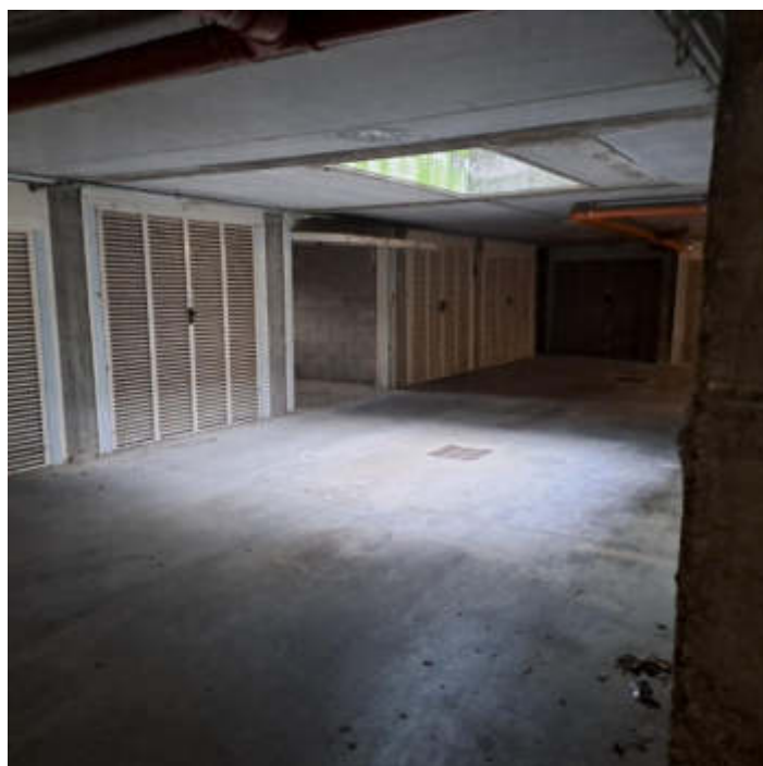
Foto 18 – Autorimessa al sub 38 – PS1
