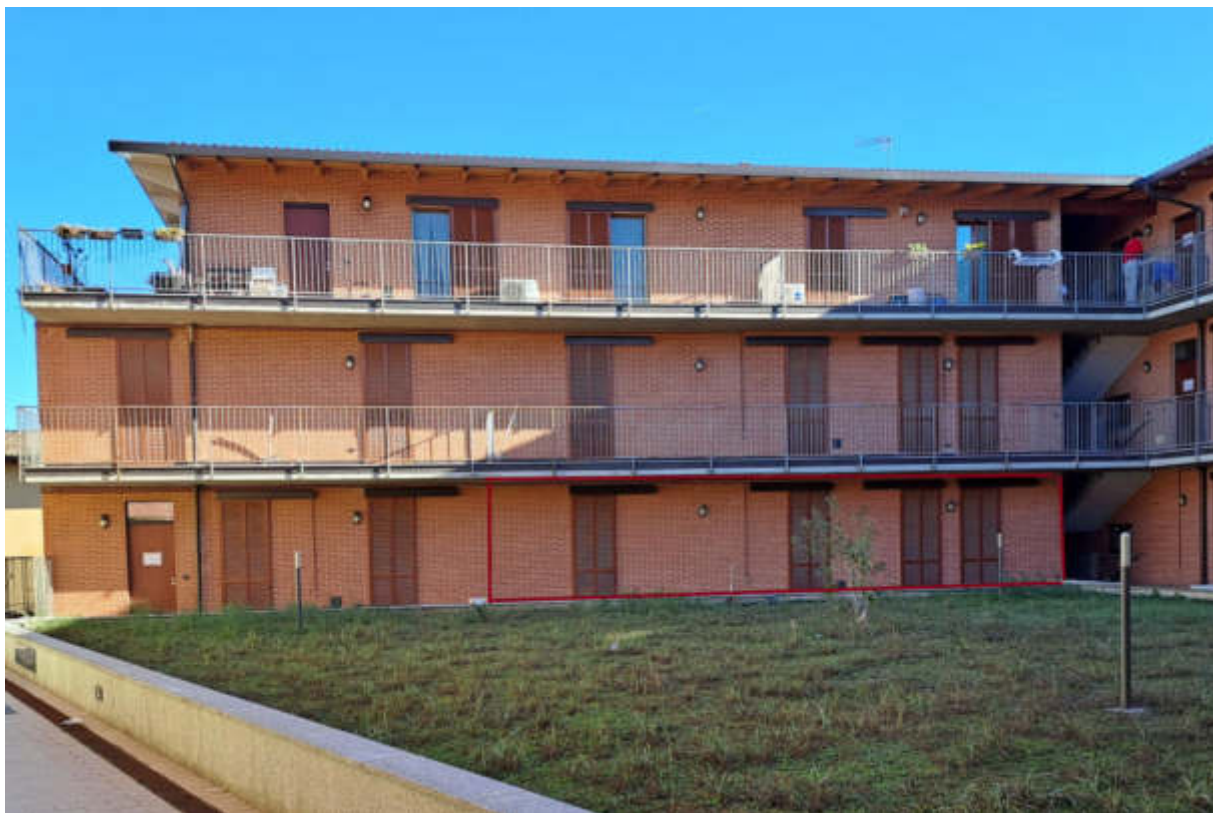
Foto 1 – Abitazione al sub 25 dalla corte interna – Lato ovest
