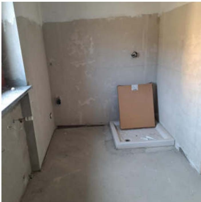
Foto 11 – Bagno del sub 25
