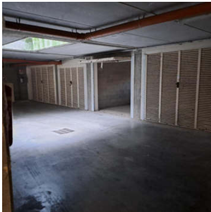
Foto 16 – Autorimessa al sub 37
