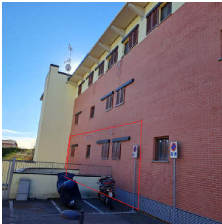
Foto 2 – Abitazione al sub 25 dalla strada privata di accesso alle autorimesse – Lato est
