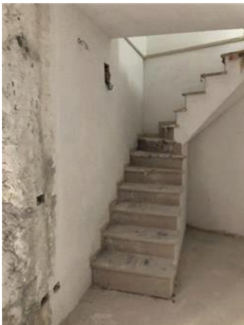
Via Pollino vista scala interna piano terra
