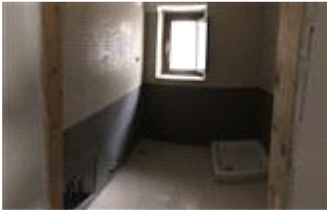
Via Pollino vista interno piano primo
