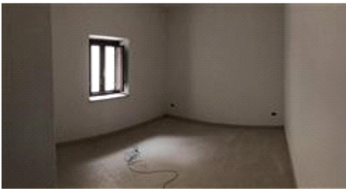
Via Pollino vista interno piano primo
