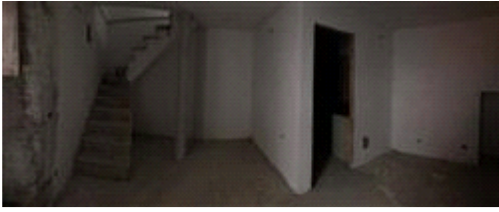
Via Pollino vista interno piano terra
