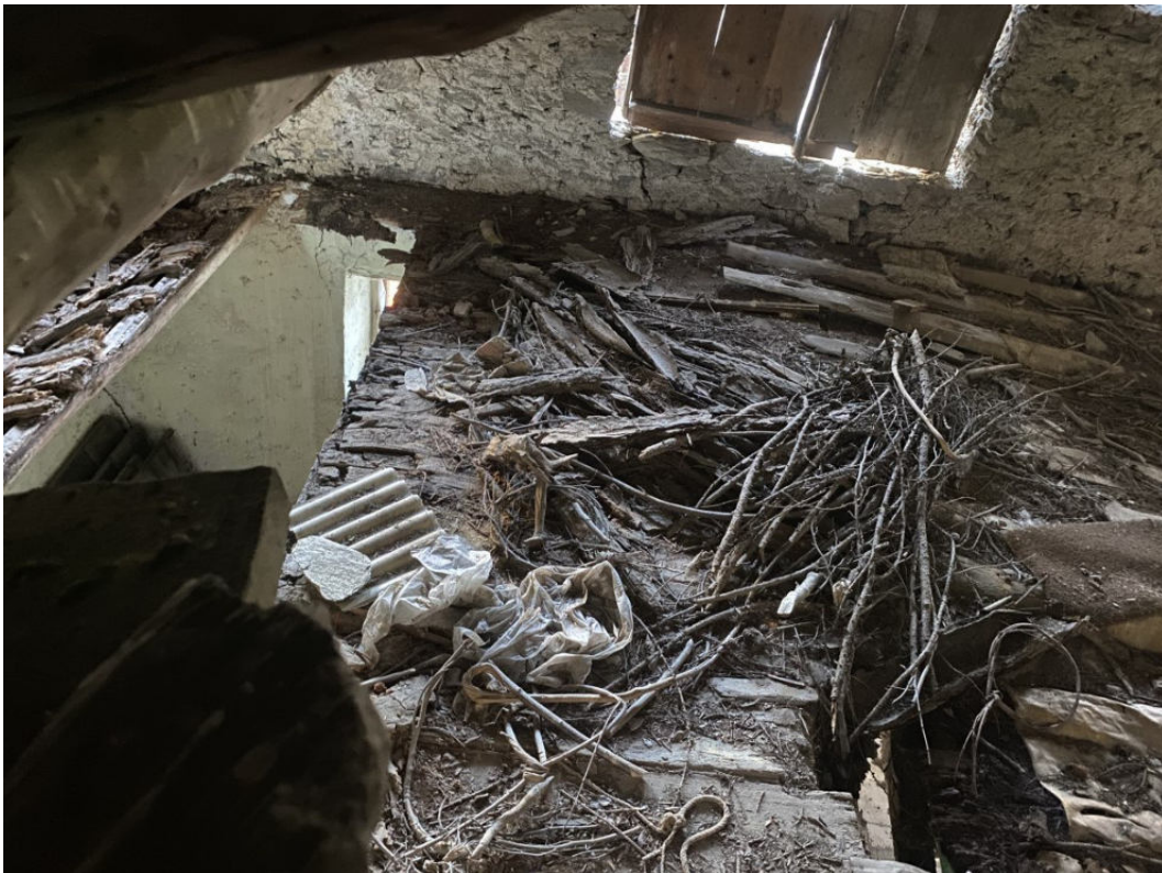
MAPPALE 568 VISTA INTERNA PIANO PRIMO
