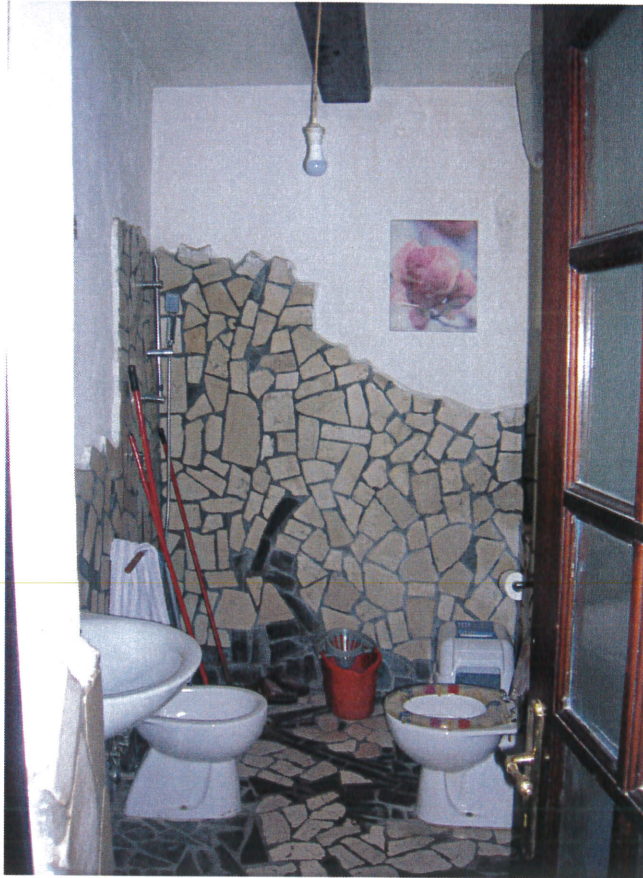
Vedute interne – bagno al piano primo
