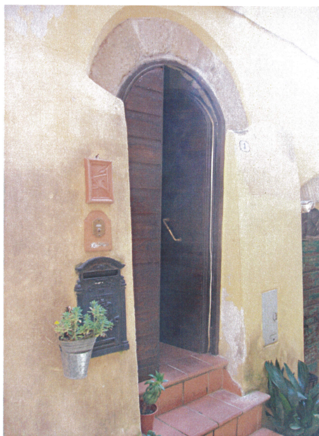
Vedute esterne del fabbricato – ingresso da vicolo Cairolì
