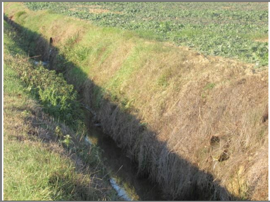
Foto n. 3 Fosso collettore lungo la strada Vicinale della Croce e tubi di drenaggio
