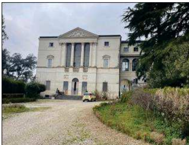
Corpo di fabbrica "E"
