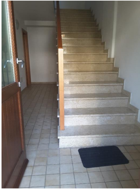
Vista scala comune condominiale
