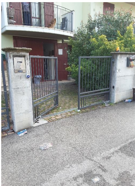
Vista ingresso autorimessa dalla via Luigi Bernardini
