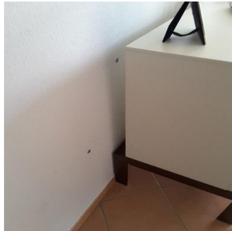
Vista presenza di alcuni fori nelle pareti sia del soggiorno sia delle camere da letto
