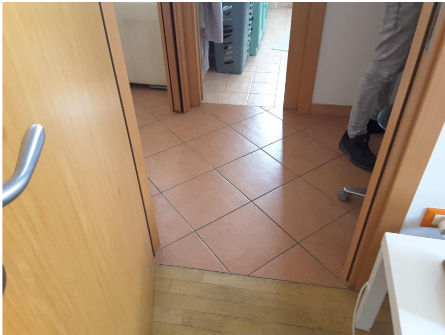
Vista porte interne
