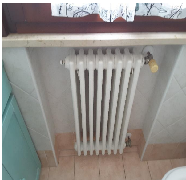
Vista impianto di riscaldamento con termosifoni in acciaio
