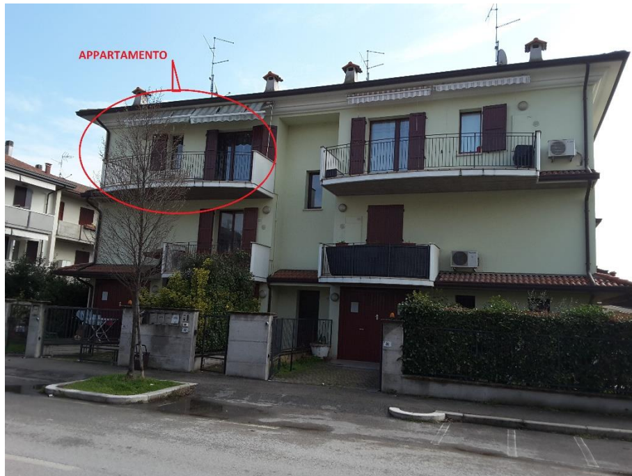
Vista esterna del fabbricato che comprende la proprietà immobiliare oggetto di procedura di liquidazione costituita dalla quota di 600/1000 di proprietà indivisa
