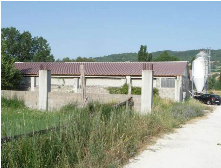
Foto n. 8 Capannone centrale (in secondo piano – parte ultimata)
