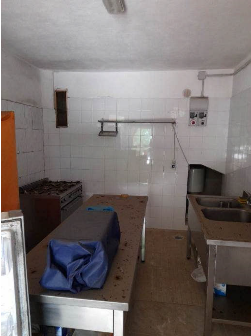
Vista CUICA LOCALE SUB 6
