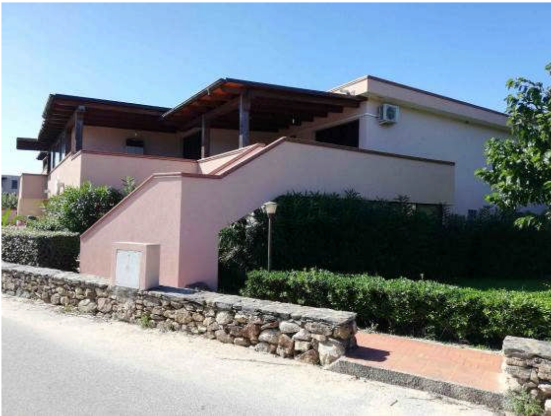
vista PROSPETTO PRINCIPALE DALLA VIA ISCIA PIUMICA NORD EST
