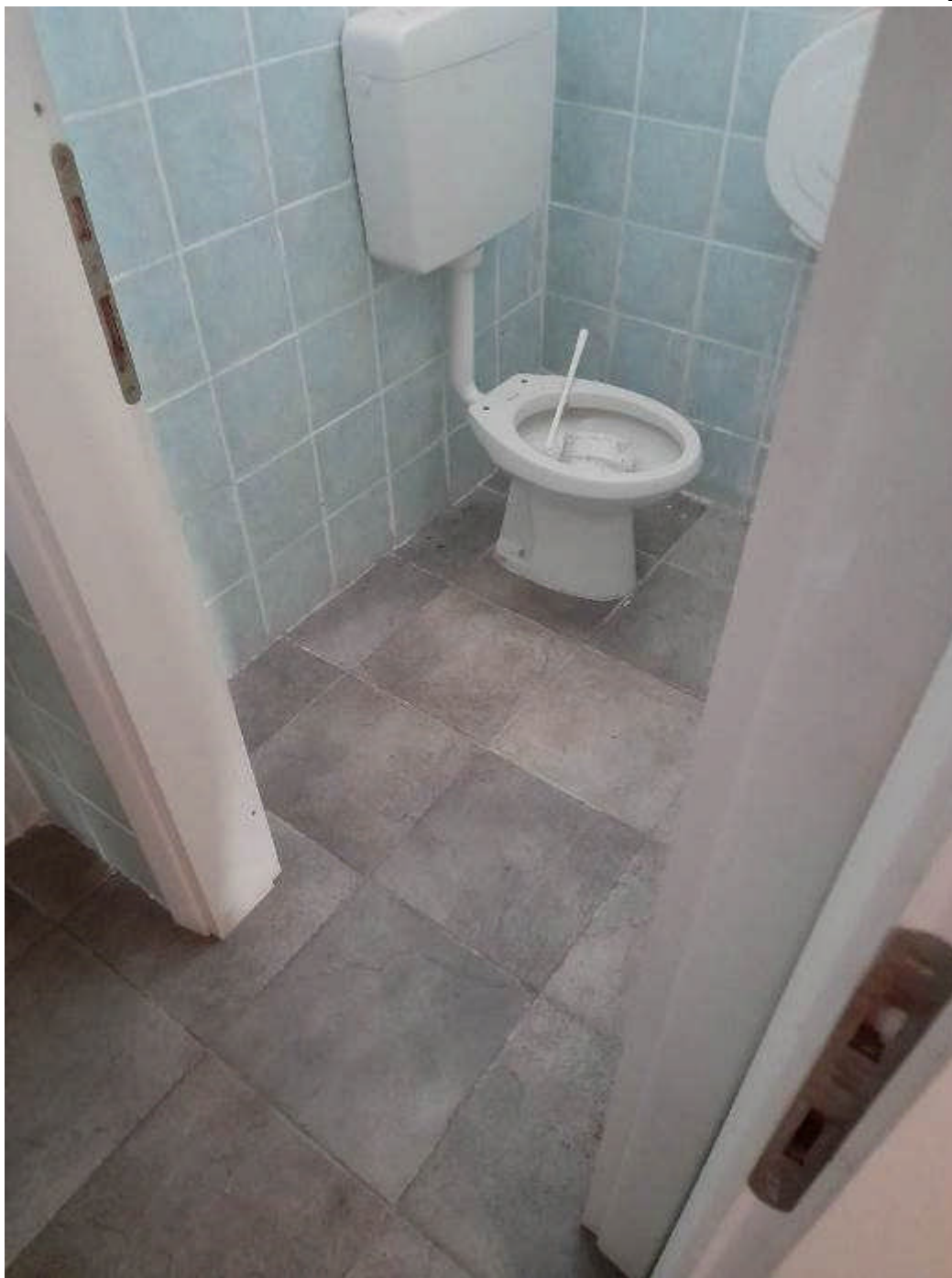
VISTA SERVIZI IGIENICI SUB 6
