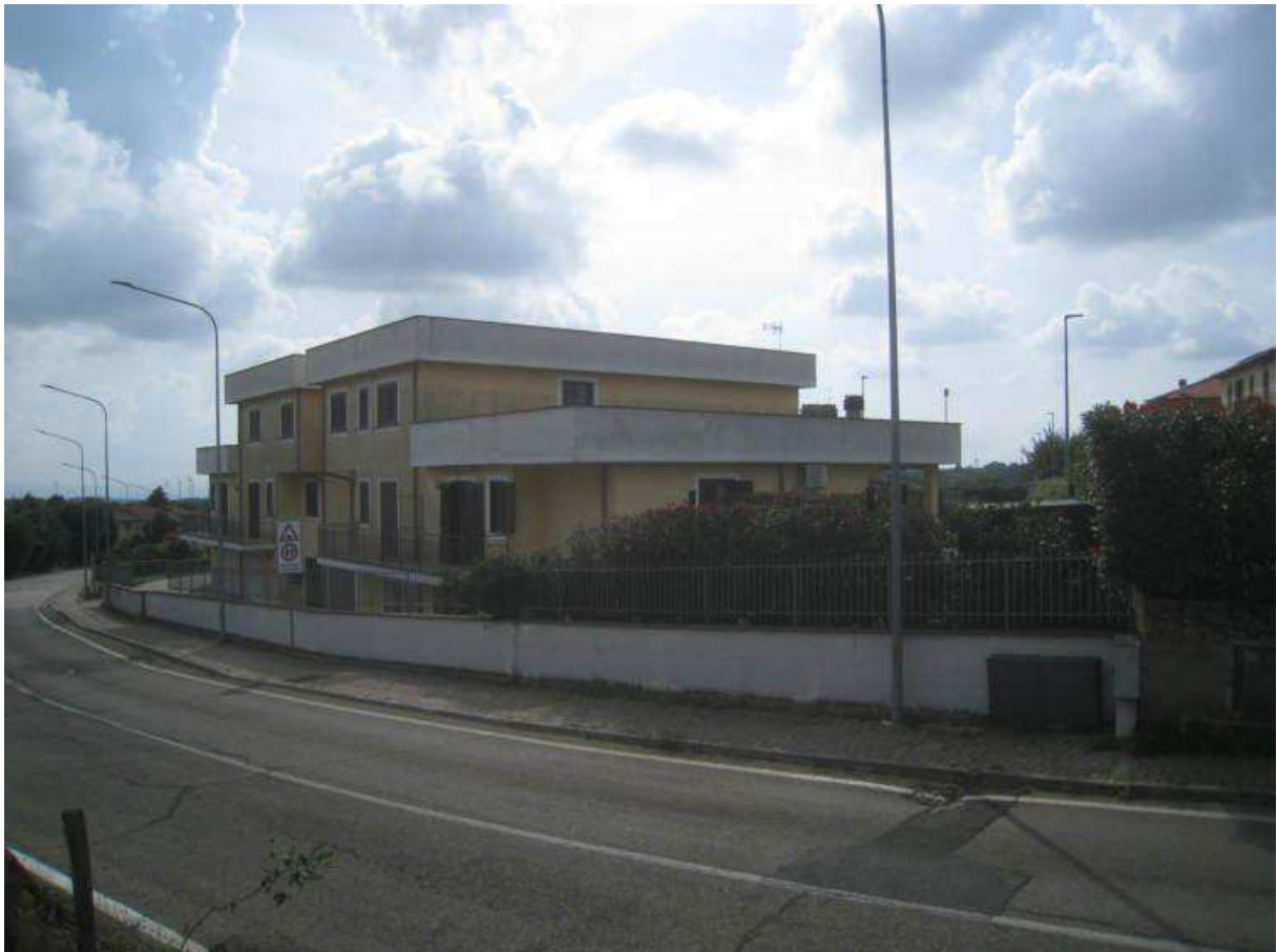
Veduta lotto n. 4 terrazzo distinto al C.F. nel f. 1 part.lla 925 sub. 15
