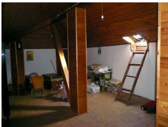
P. secondo: soffitta
