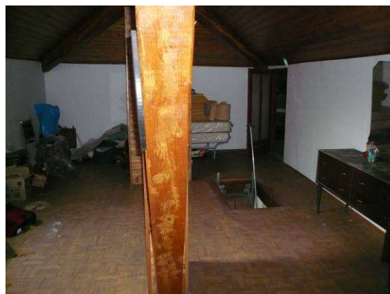
P. secondo: soffitta
