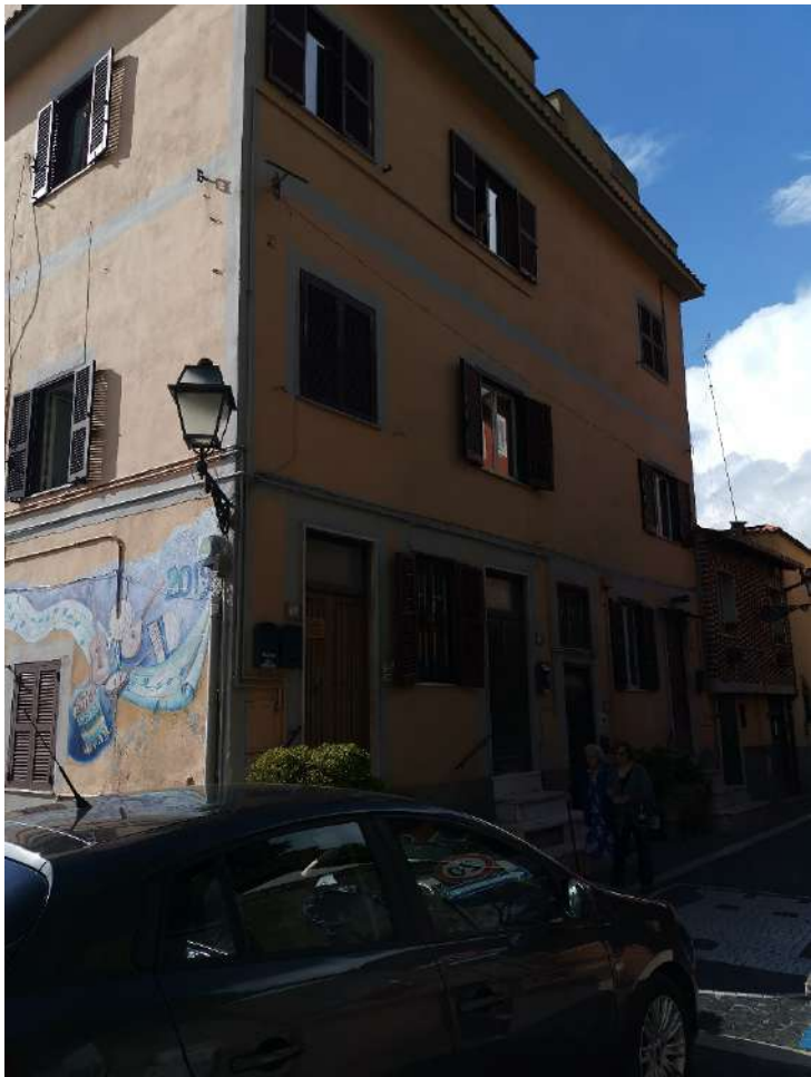
Fabbricato, Via A. Gramsci 72
