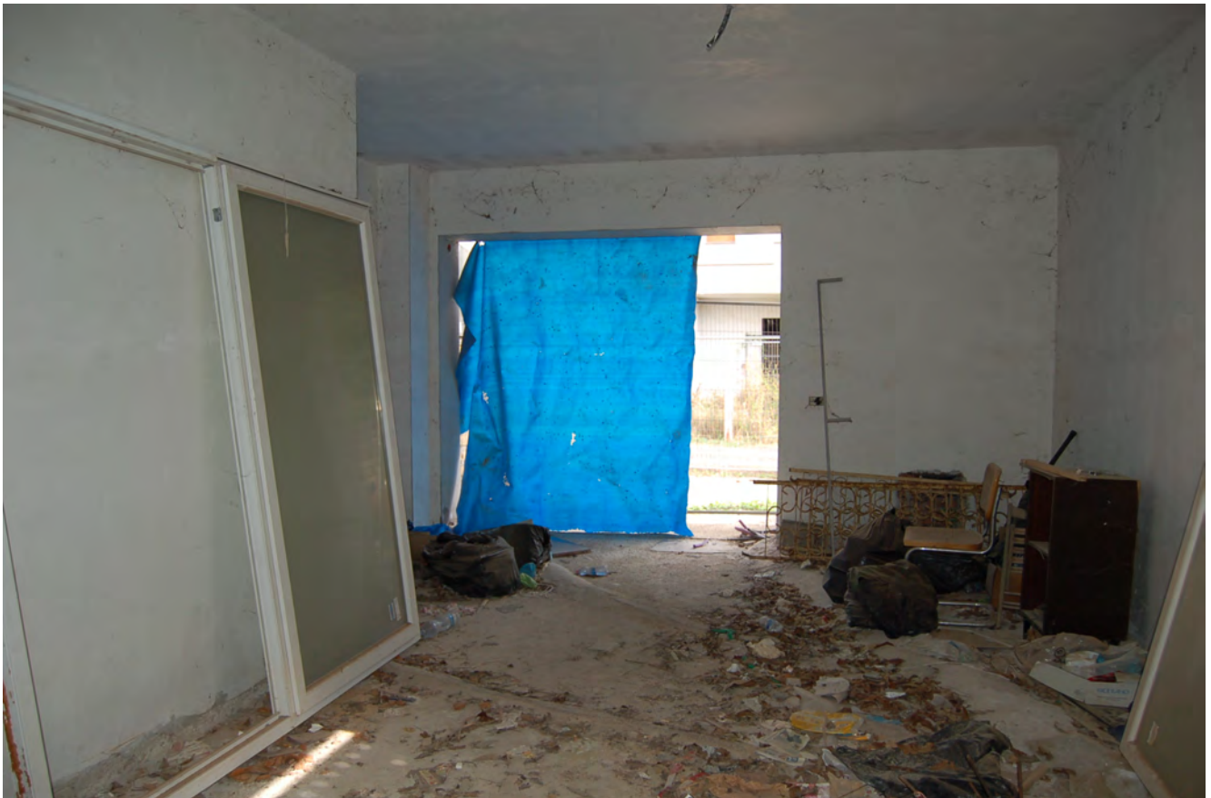
Foto 7 - Locali piano seminterrato (Villino distinto al N.C.E.U al fg.2 particella 1227, sub. 4)
