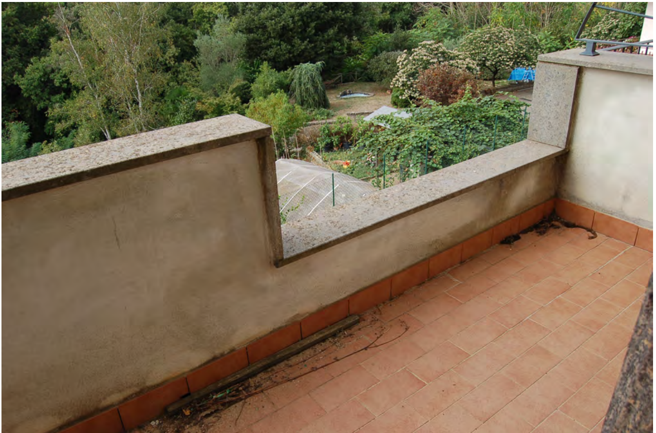
Foto 21 – Balcone piano primo (Villino distinto al N.C.E.U al fg.2 particella 1227, sub. 2)
