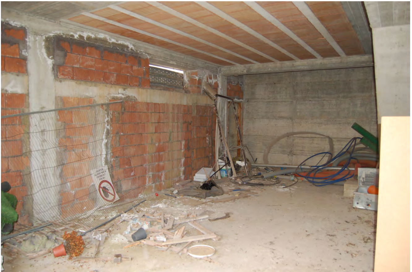
Foto 15 – Locali piano seminterrato (Villino distinto al N.C.E.U al fg.2 particella 1227, sub. 2)
