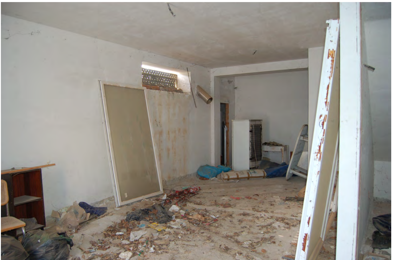
Foto 6 - Locali piano seminterrato (Villino distinto al N.C.E.U al fg.2 particella 1227, sub. 4)
