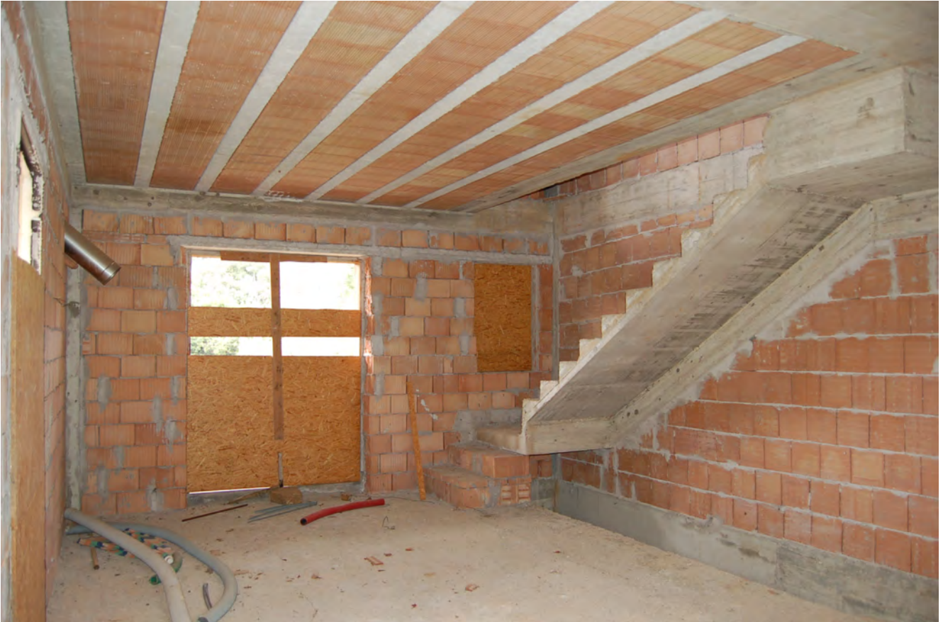
Foto 17 - Locali piano terra (Villino distinto al N.C.E.U al fg.2 particella 1227, sub. 2)
