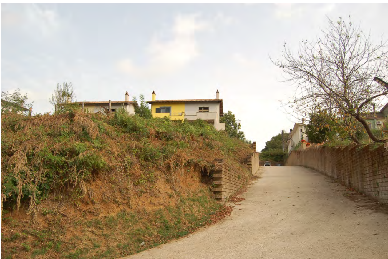
Foto 2 – Strada d'accesso al complesso residenziale
