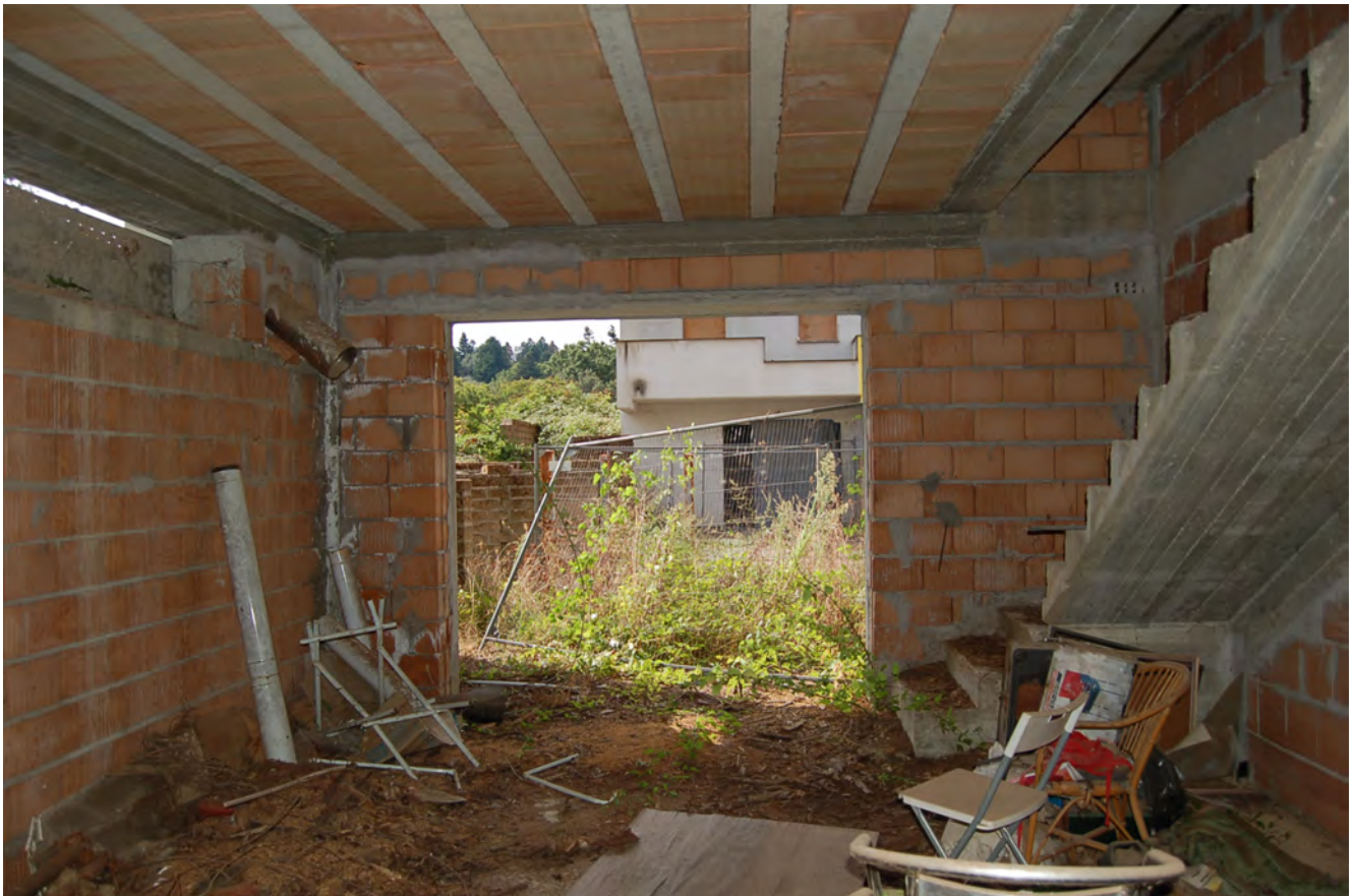
Foto 23 - Locali piano seminterrato (Villino distinto al N.C.E.U al fg.2 particella 1250, sub. 4)
