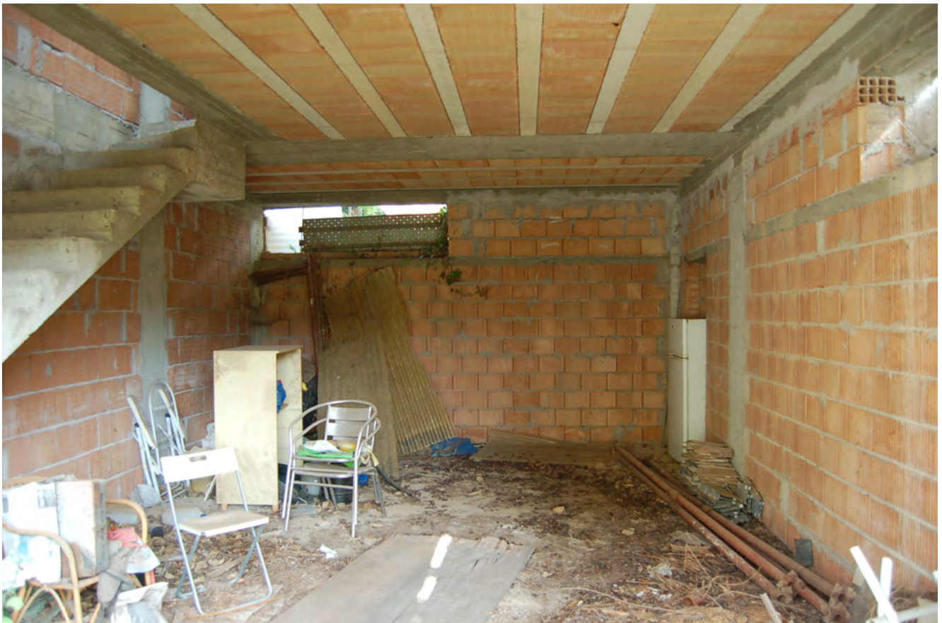
Foto 24 - Locali piano seminterrato (Villino distinto al N.C.E.U al fg.2 particella 1250, sub. 4)
