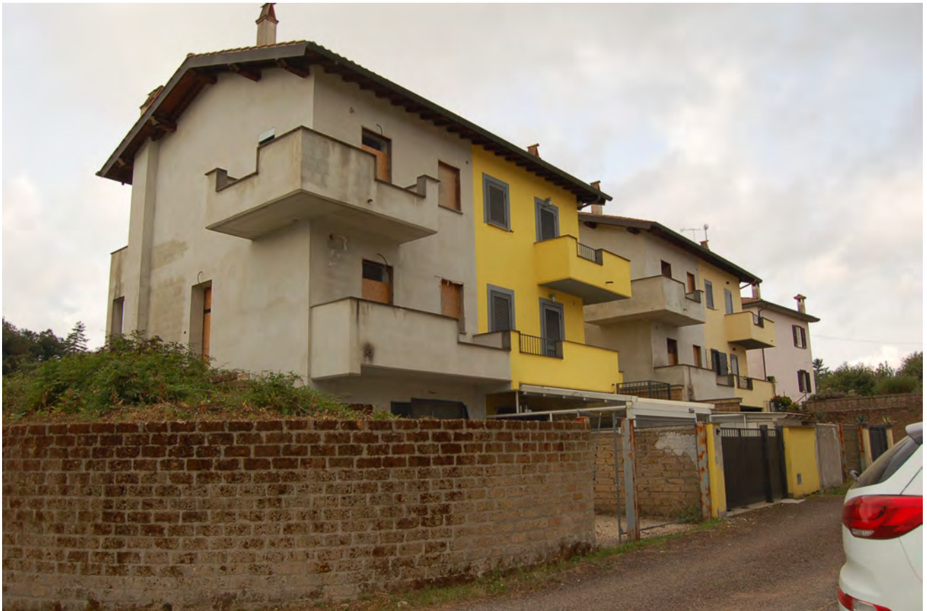
Foto 3 - Primo e secondo blocco di villini bifamiliari (villini a sud della lottizzazione)
