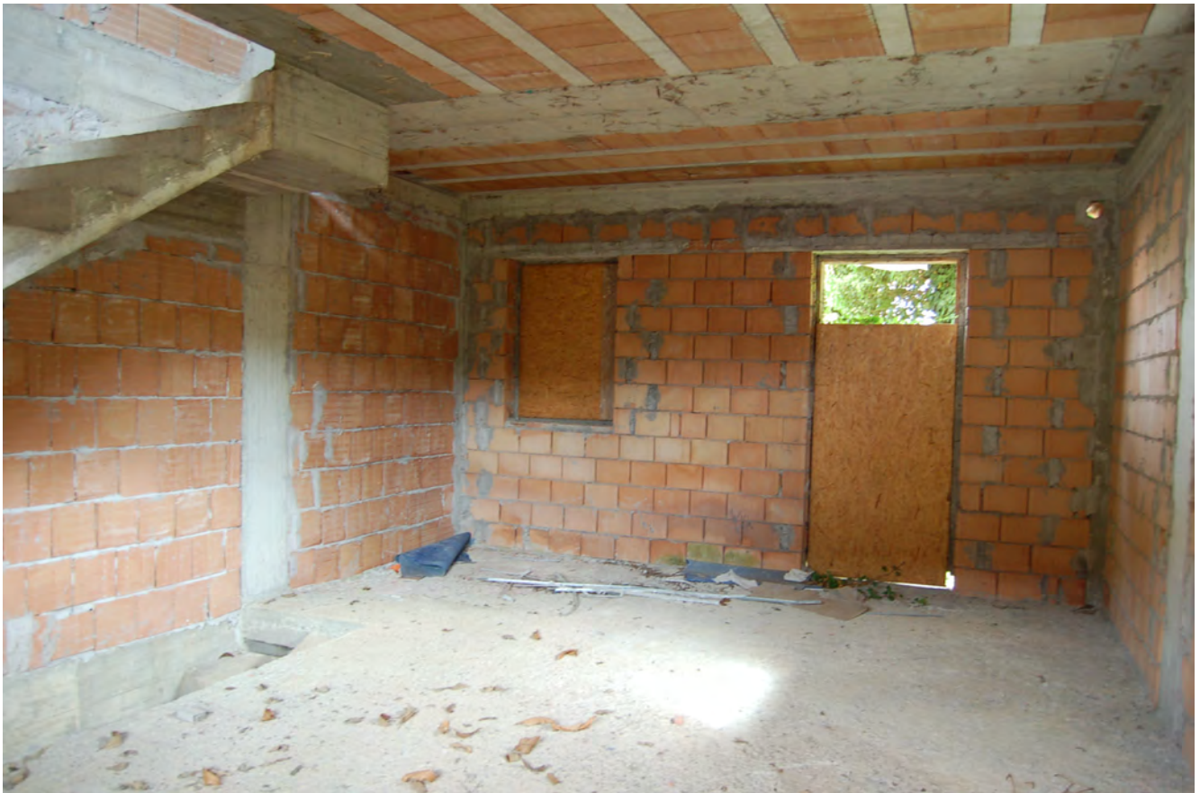
Foto 27 - Locali piano terra (Villino distinto al N.C.E.U al fg.2 particella 1250, sub. 4)
