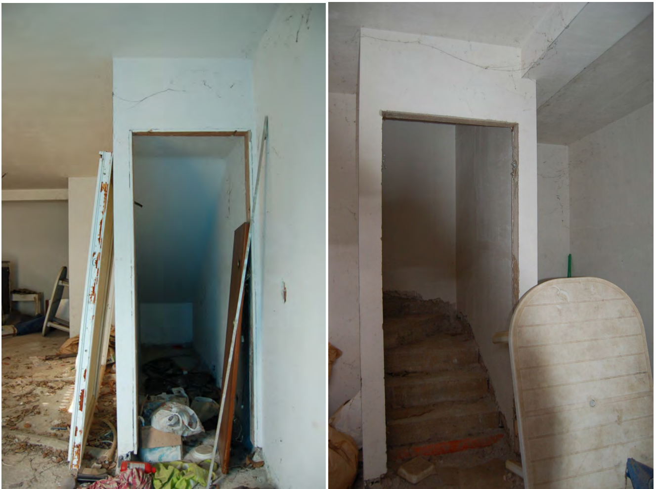
Foto 8 – Sottoscala e rampa di accesso dal piano seminterrato al piano terra
