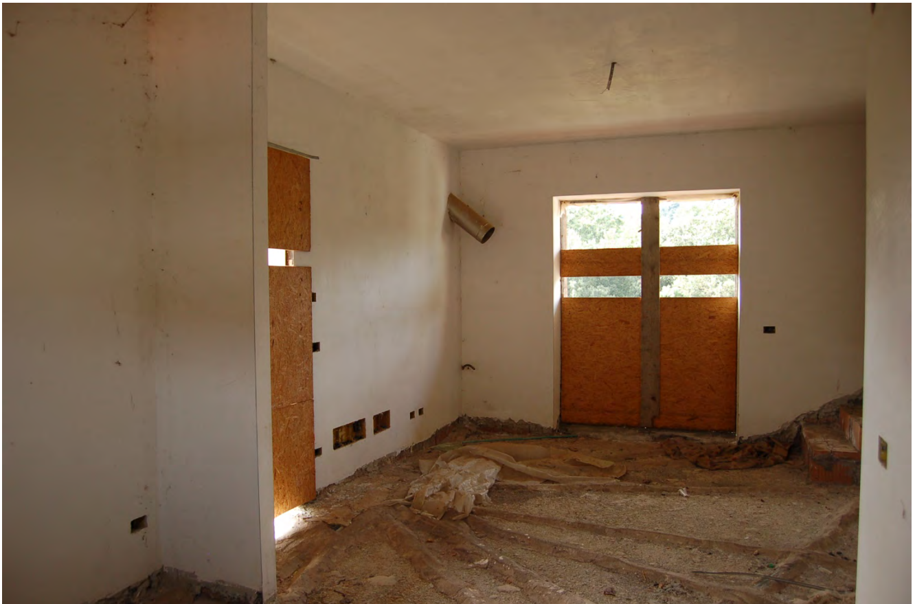
Foto 9 - Locali piano terra (Villino distinto al N.C.E.U al fg.2 particella 1227, sub. 4)
