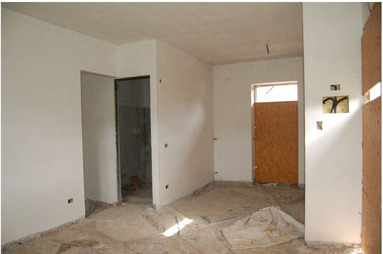
Foto 10 - Locali piano terra (Villino distinto al N.C.E.U al fg.2 particella 1227, sub. 4)
