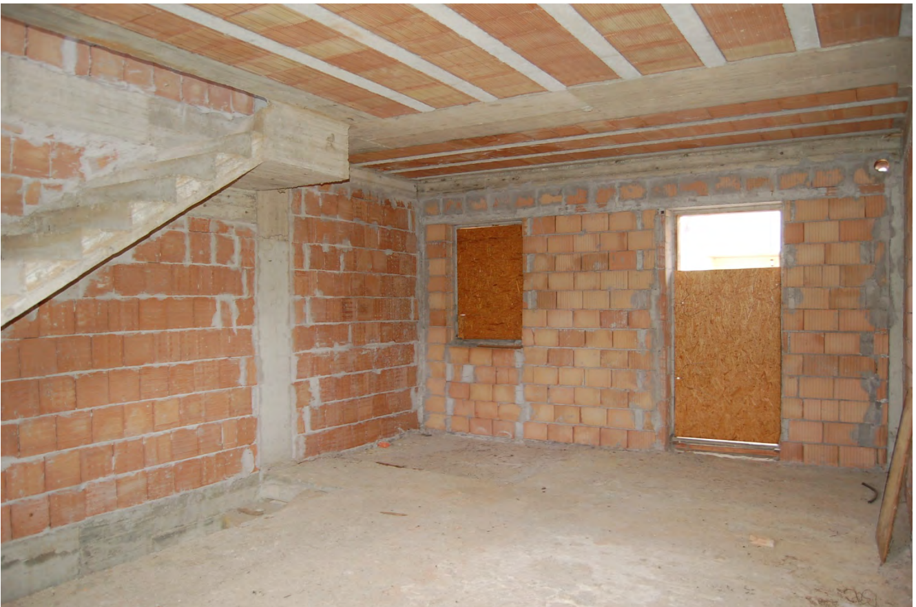
Foto 18 - Rampa di collegamento tra piano terra e il piano primo (Villino distinto al N.C.E.U al fg.2 particella 1227, sub. 2)
