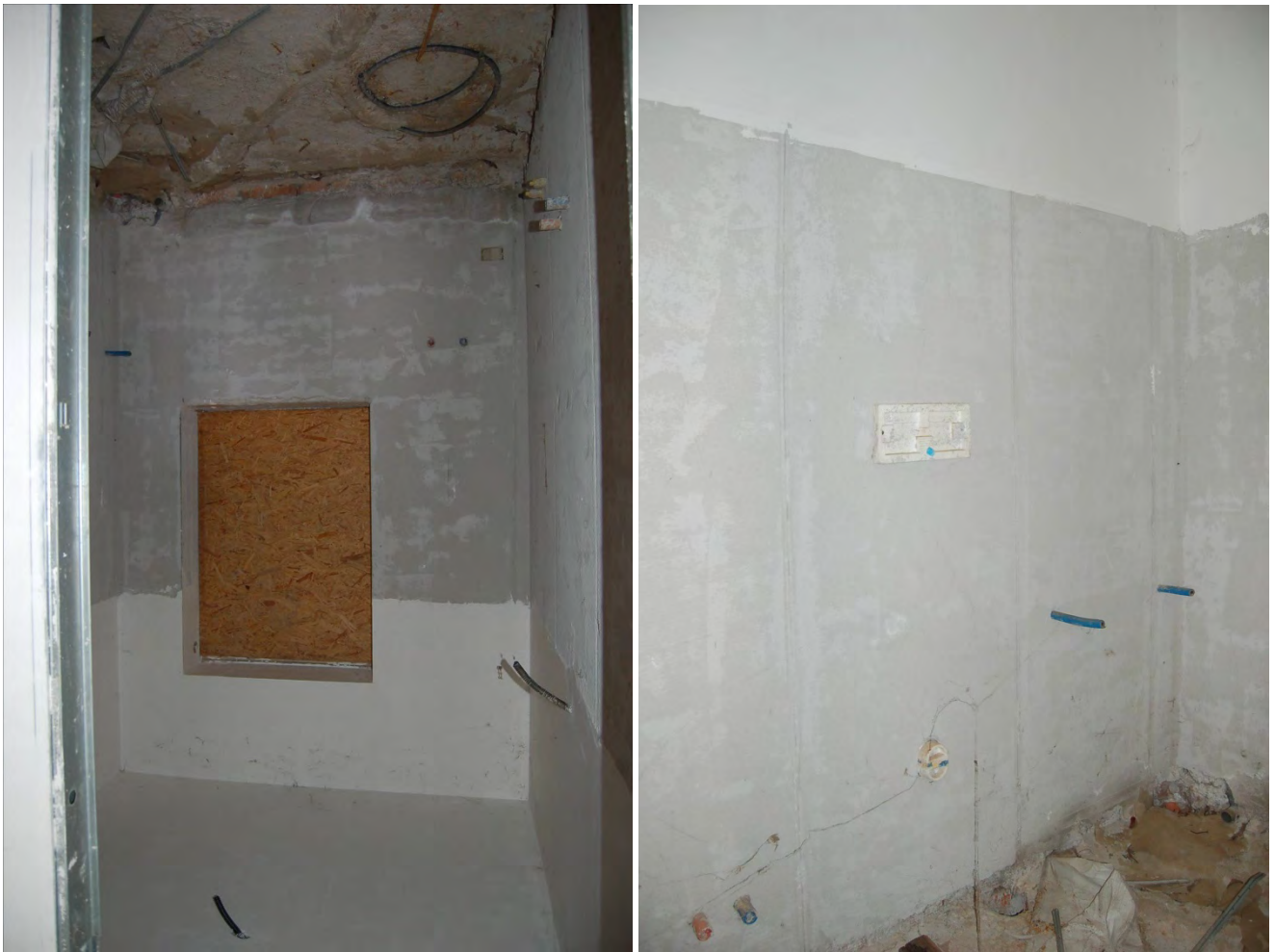
Foto 11 - Bagno piano primo (Villino distinto al N.C.E.U al fg.2 particella 1227, sub. 4)
