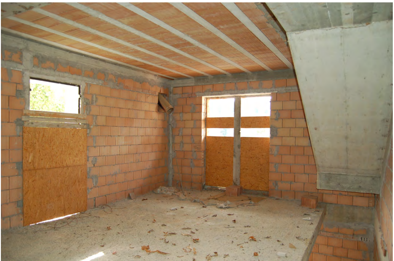
Foto 26 - Locali piano terra (Villino distinto al N.C.E.U al fg.2 particella 1250, sub. 4)
