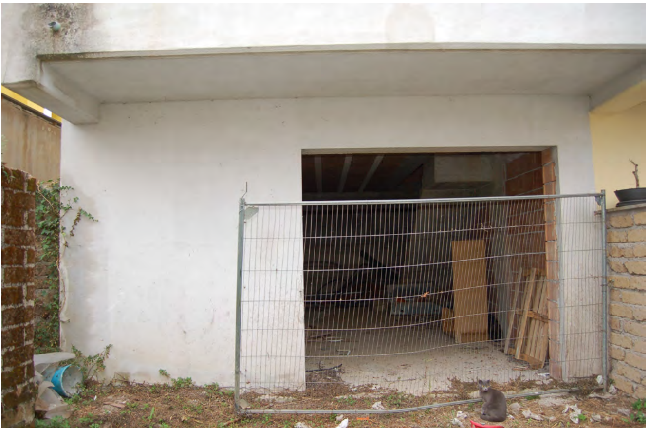
Foto 14 – Ingresso locali primo piano seminterrato (Villino distinto al N.C.E.U al fg.2 particella 1227, sub. 2)
