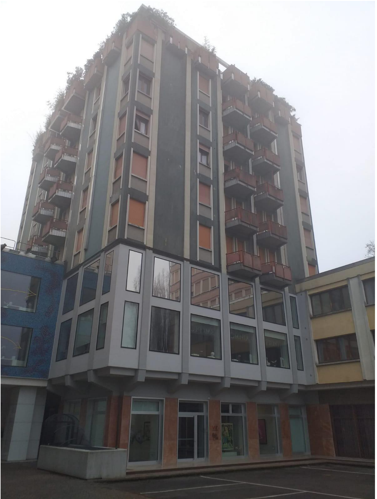
Prospetto ovest su Piazzetta Bussolin, il terrazzo più a sinistra è diviso a metà da una struttura in vetro
