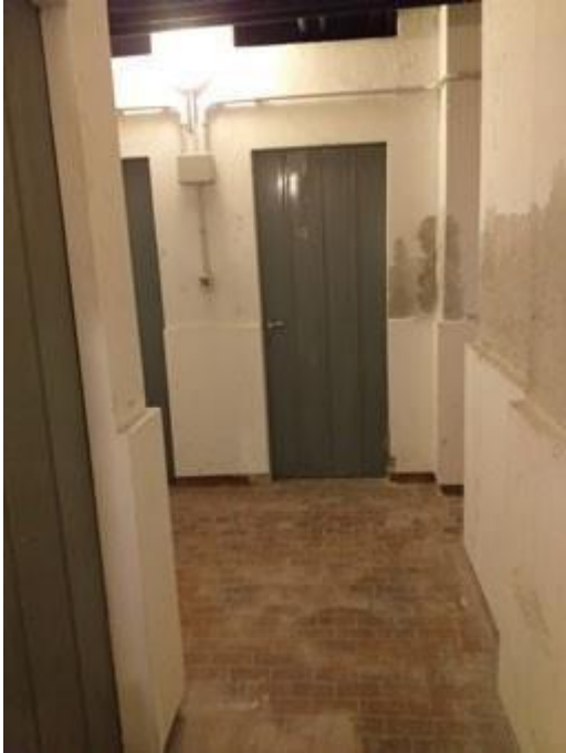
Ripostiglio al secondo piano sottostrada
