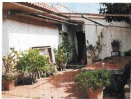
F1 - ACCESSO POSTERIORE LATO W
