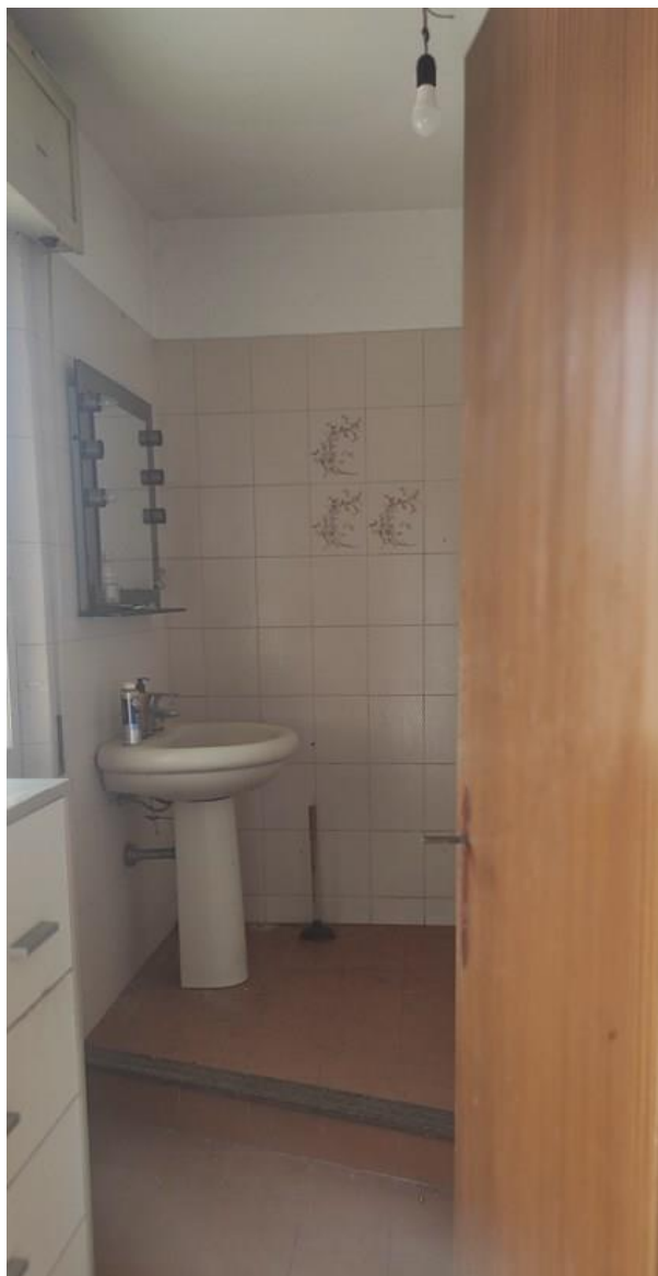
Figura 57: INTERNO 4B - vista del bagno posto al piano secondo
