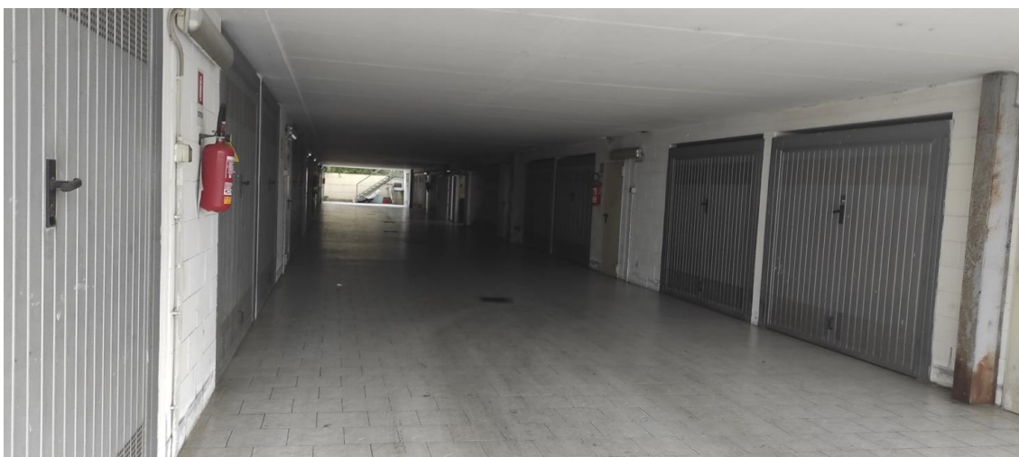
Figura 38: Esterno 4 - corsello carraio alle autorimesse e cantine
