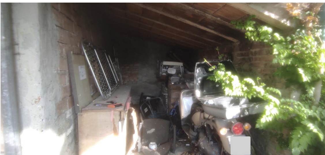
Figura 61: INTERNO 8B - vista interna del deposito posto al piano terra della particella 136
