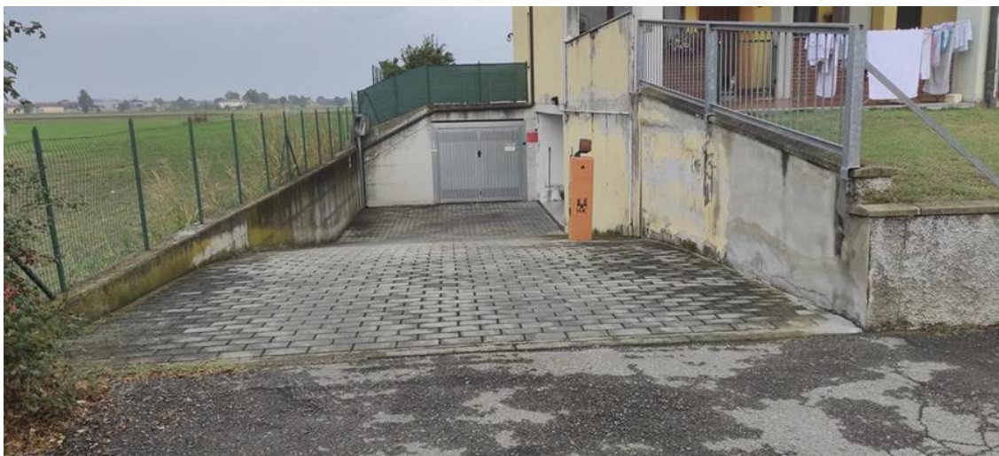
Figura 37: Esterno 3 - vista dell'accesso carraio alle autorimesse e cantine
