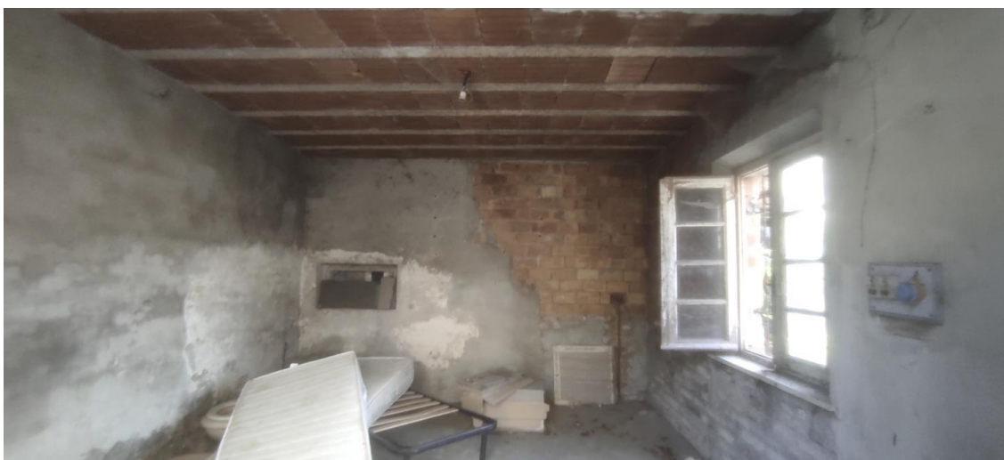
Figura 60: INTERNO 7B - vista interna dell'autorimessa, nella particella identificata catastalmente al n. 136
