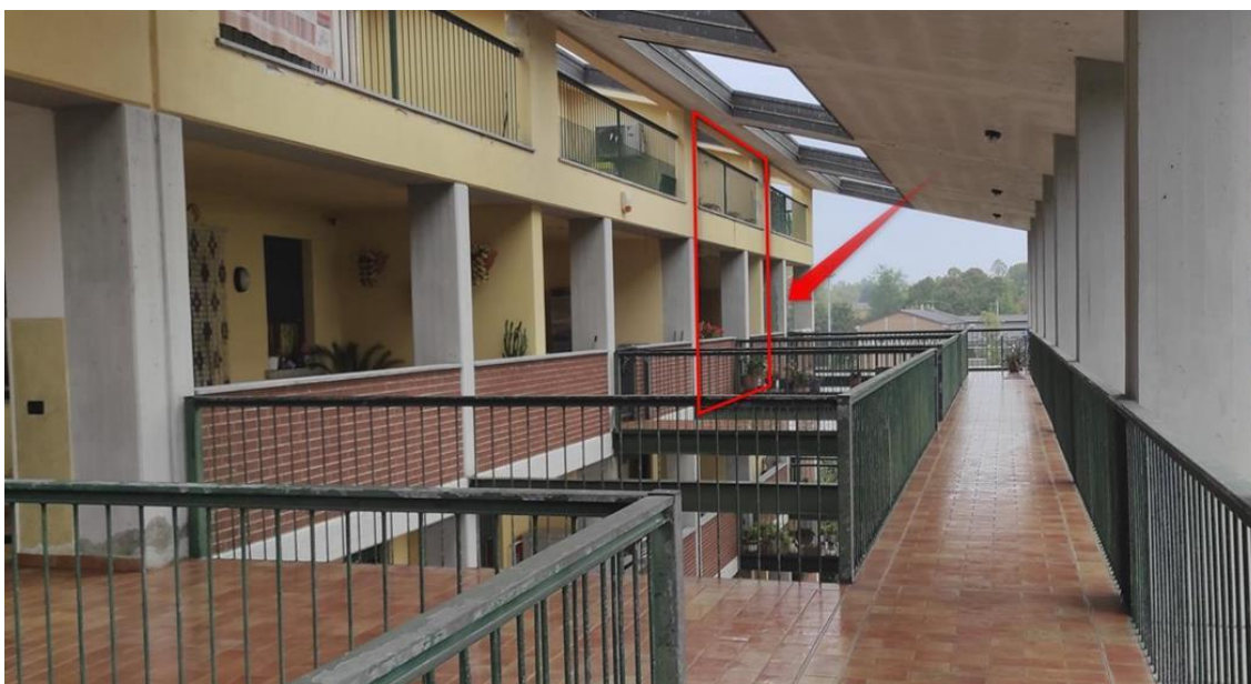
Figura 36: Esterno 2 - vista del ballatoio del secondo piano, con indicazione della posizione dell'appartamento oggetto di perizia (freccia rossa)
