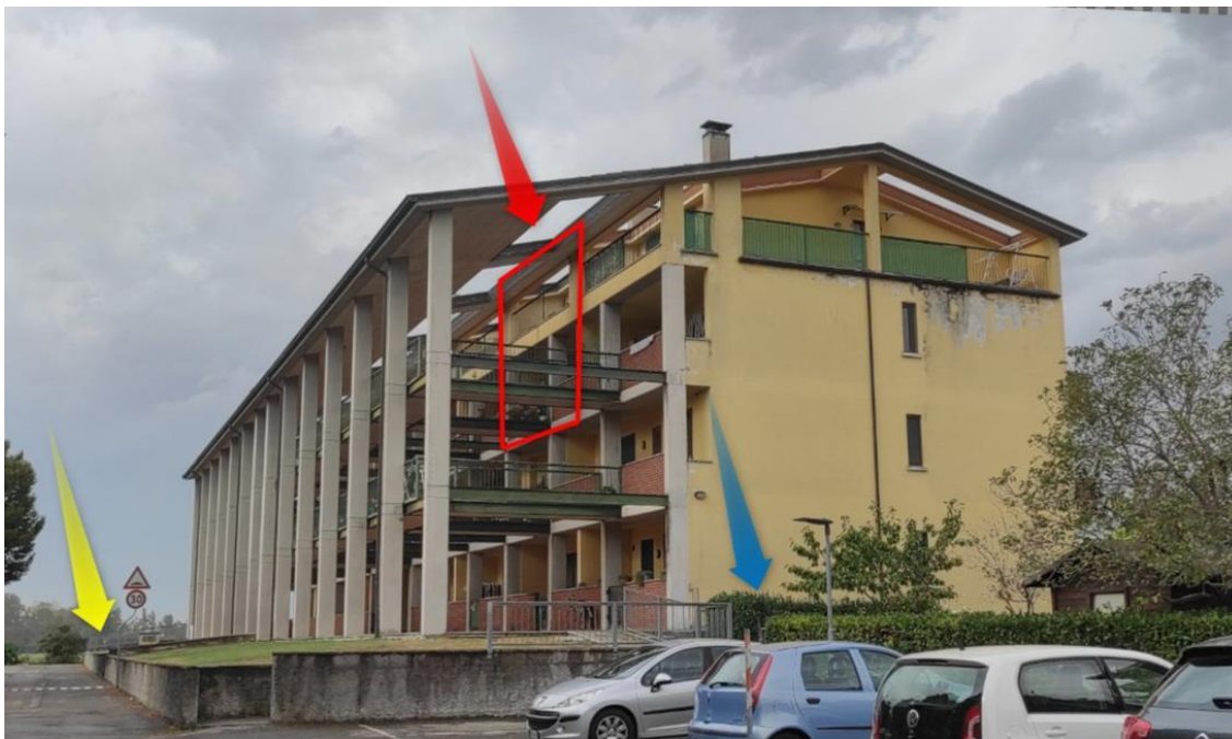
Figura 35: Esterno 1 -Prospetti Sud ed Est dell'immobile al cui interno insistono le unità immobiliari oggetto di pignoramento - in rosso è indicata la posizione dell'appartamento - la freccia azzurra indica l'accesso pedonale agli appartamenti, alle cantine ed alle autorimesse - la freccia gialla indica l'accesso carraio alle autorimesse e cantine
