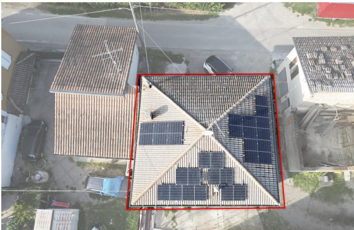
Figura 51: ESTERNO 3B - vista aerea della copertura dell'edificio posto sulla particella 135
