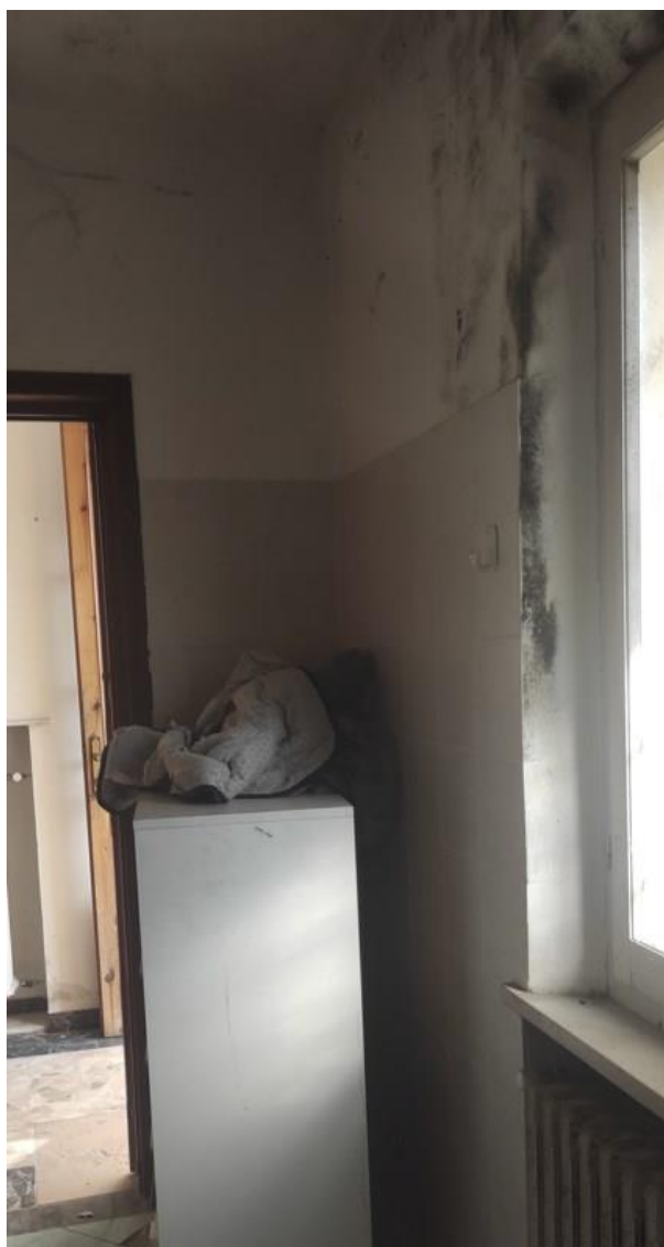
Figura 54: INTERNO 1B – vista del bagno posto al piano terra
