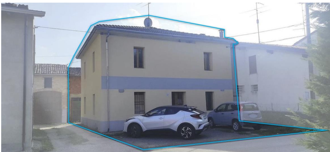
Figura 52: ESTERNO 4B - Prospetto Nord, vista da Via Vignoli delle unità immobiliari che compongono il LOTTO 4 (abitazione particella 135, autorimessa e servizi particella 136)
