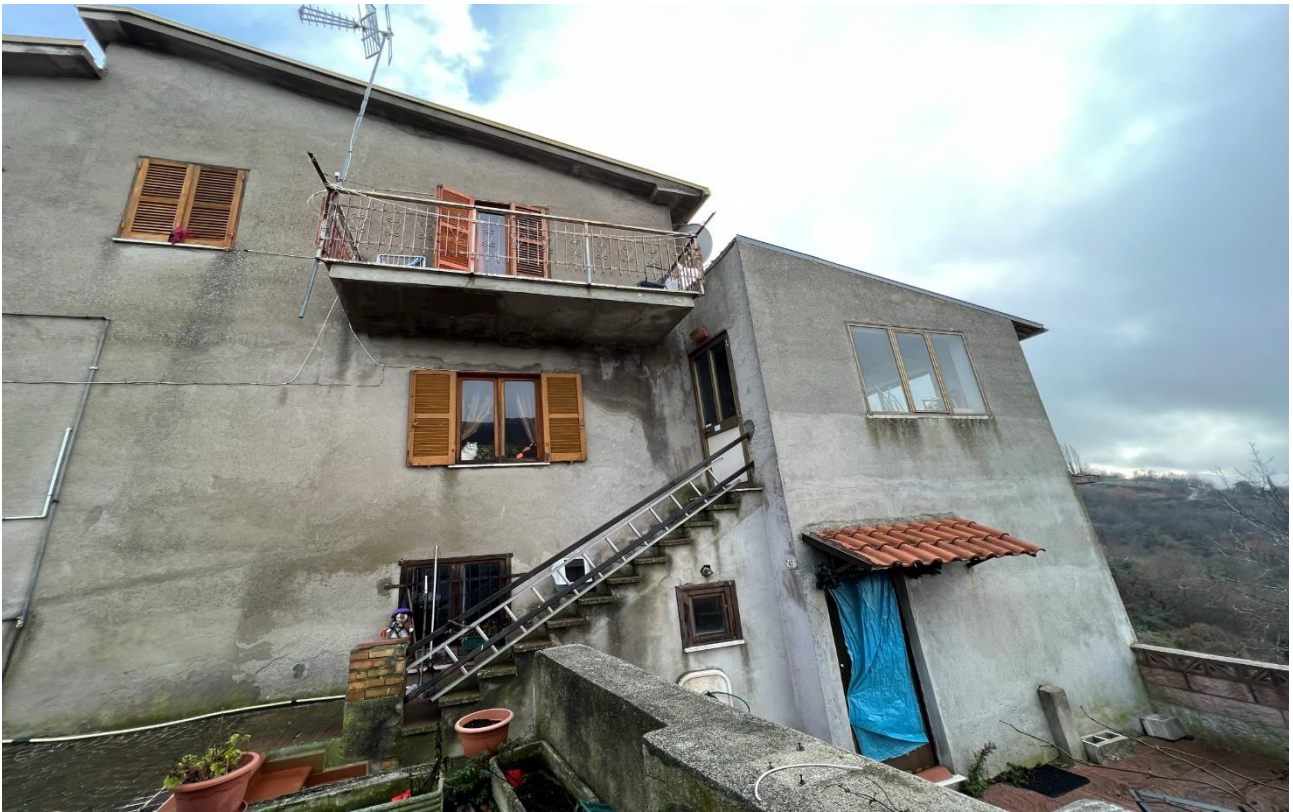
FOTO 3: Veduta esterna prospetto ovest abitazione
