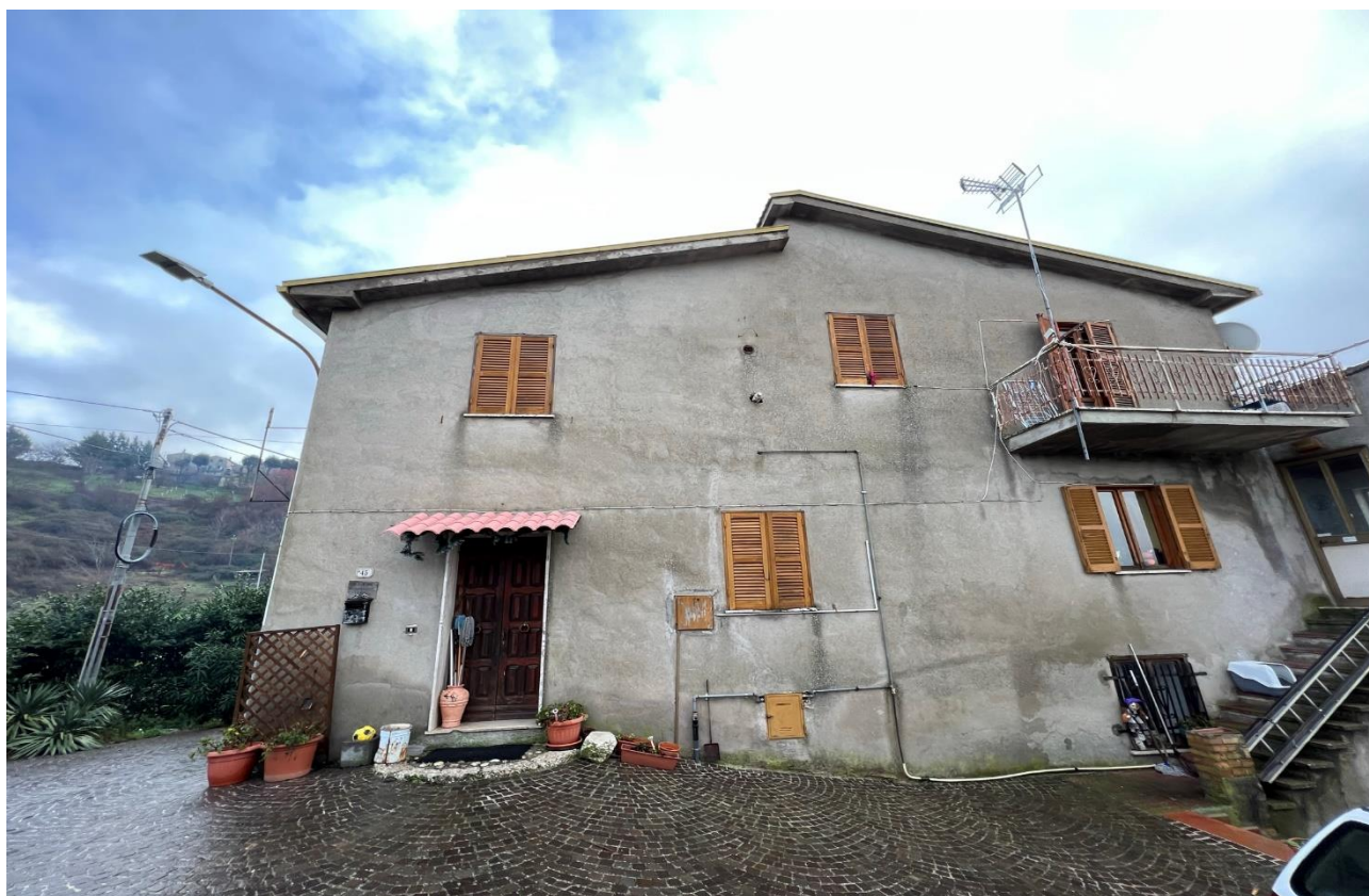
FOTO 1: Veduta esterna prospetto ovest abitazione
