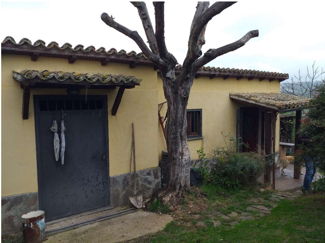
Foto n.19 Vista esterna locale accessorio - magazzino
