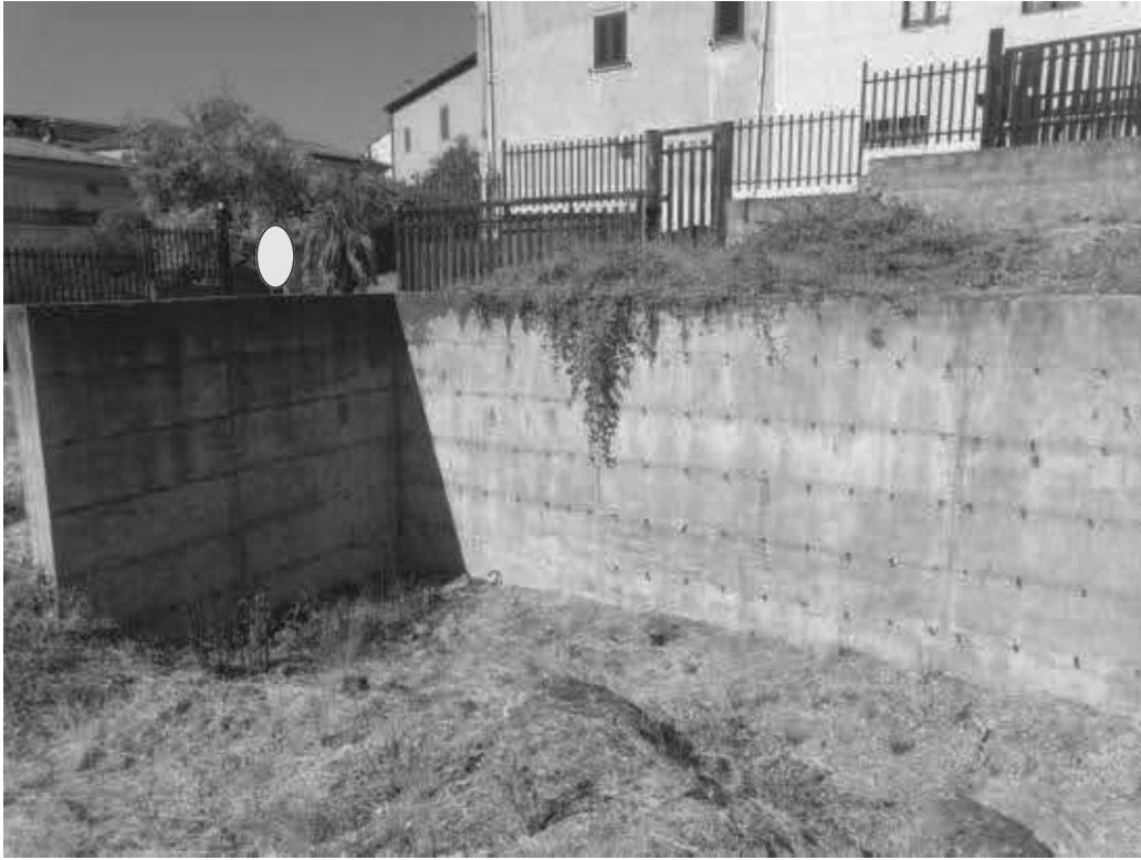
FOTO N. 13 ( p.lla 586 muro contenimento in c.a.)
