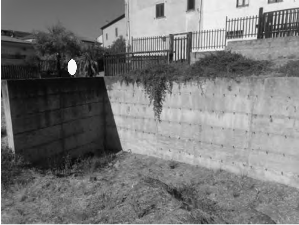
FOTO N. 13 ( p.lla 586 muro contenimento in c.a.)
