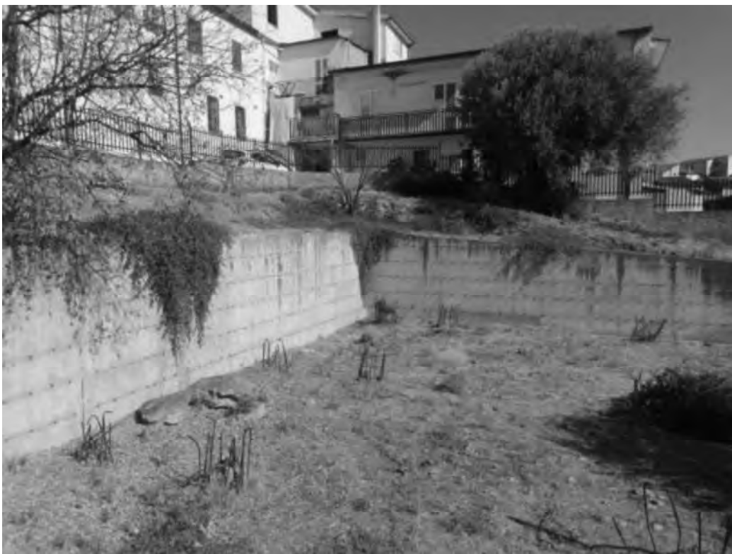
FOTO N. 14 ( p.lla 586 muro contenimento in c.a.)
