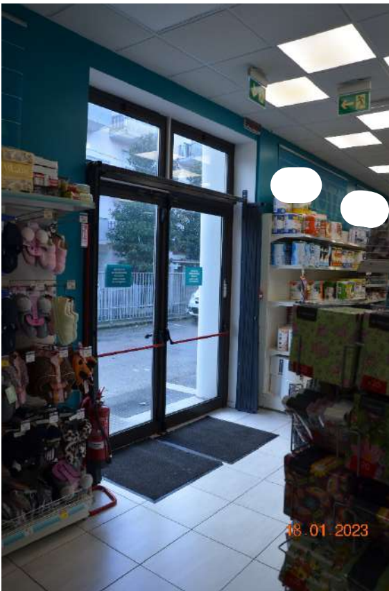
All'interno alcune uscite di sicurezza dotate di maniglioni antipánico, il locale è munito di controsoffitto con illuminazione ad incasso
