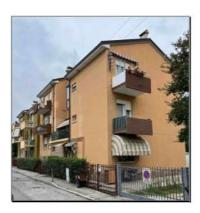
**Strutture:** tipologia tradizionale, in muratura portante di laterizio su fondazioni in c.a., solaio latero-cemento, copertura con struttura latero-cemento a falde, facciate intonacate e tinteggiate.
