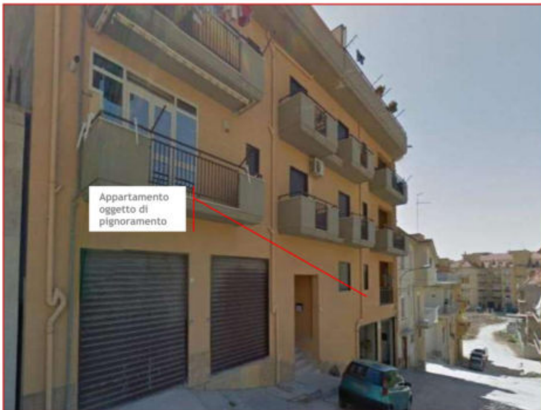
Foto 1 – Vista Complesso Edilizio – Lato Nord
