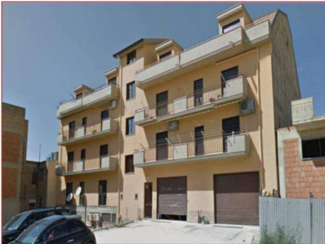
Foto 2 – Vista Complesso Edilizio – Lato SUD
