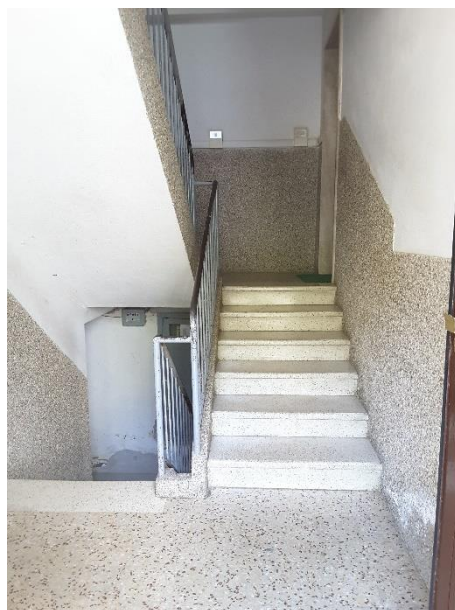
Vista scala comune condominiale per accedere all'appartamento (oggetto di pignoramento) posto al piano terzo del fabbricato condominiale
