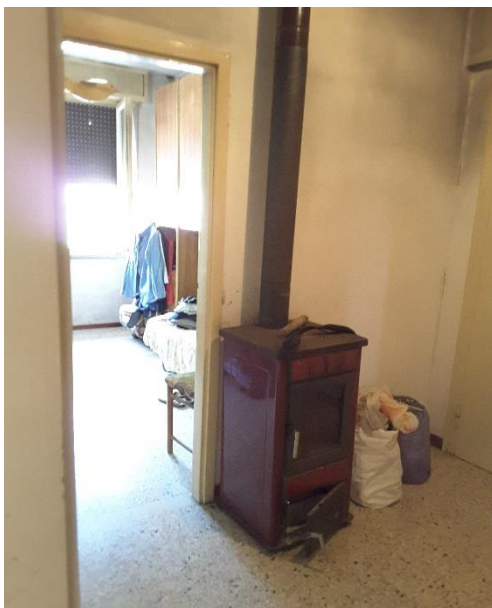
Vista vecchia stufa a legna per il riscaldamento dell'alloggio
