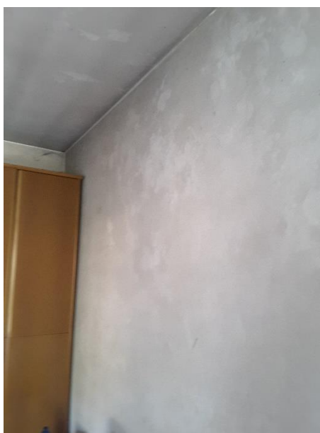
Vista pareti e soffitto intonacate e tinteggiate al civile
