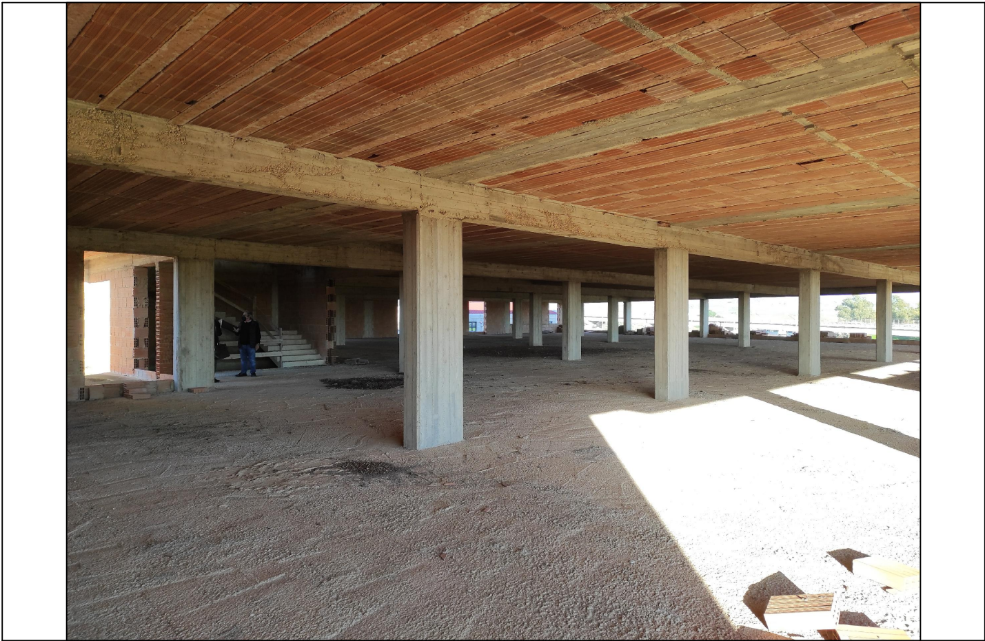
Foto 14: Lotto 1 - Piano primo - Vista interna
