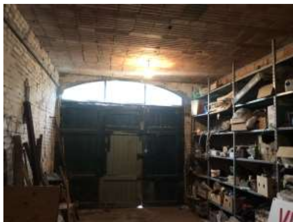
Fig. 14 – Interno 8: Rimessa sub. 6
