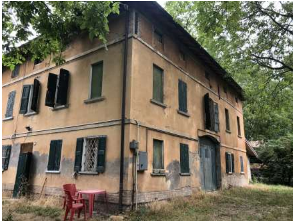
Fig. 3 – Esterno 1: Porzione di fabbricato in oggetto (sud-est)
