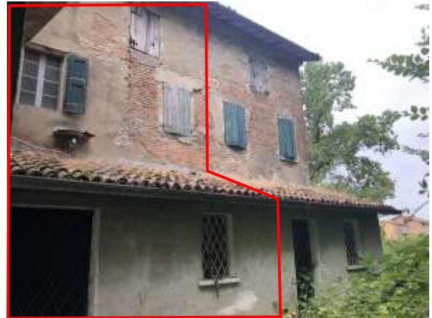
Fig. 4 – Esterno 2: Porzione fronte nord
