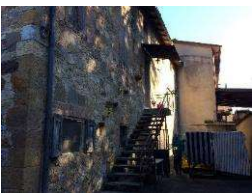
Fronte Sud (accesso al sub 10 P.1)
