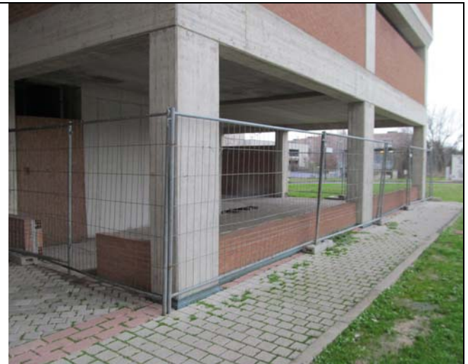
Palazzina G piano terra negozi
