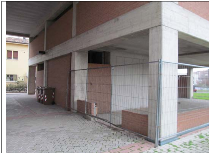
Palazzina G piano terra negozi
