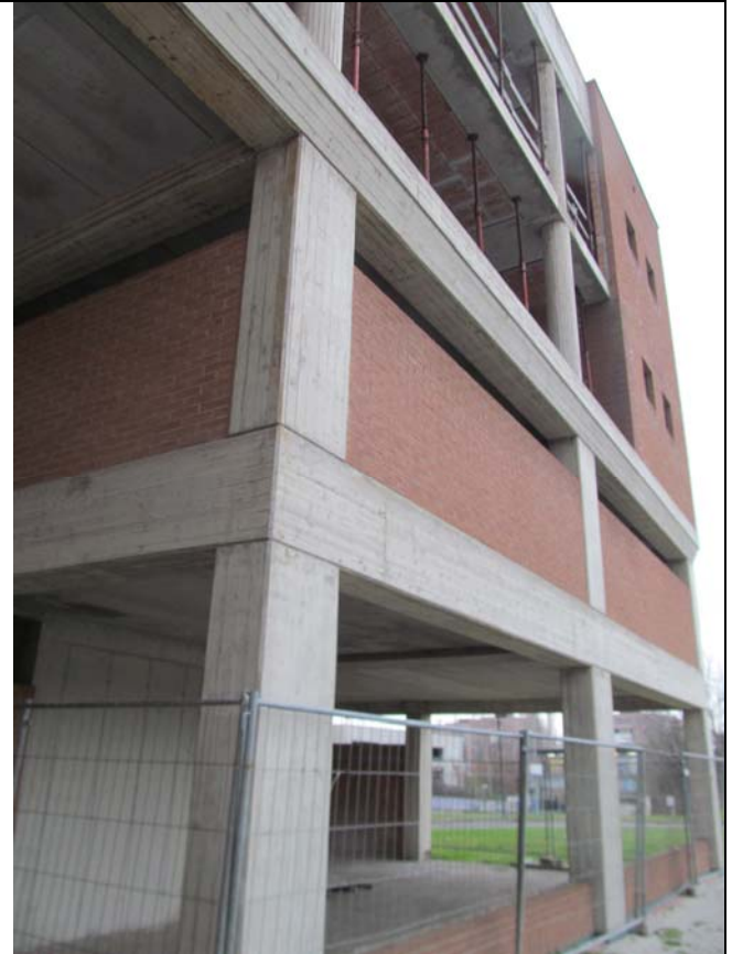
Palazzina G prospetto esterno est
