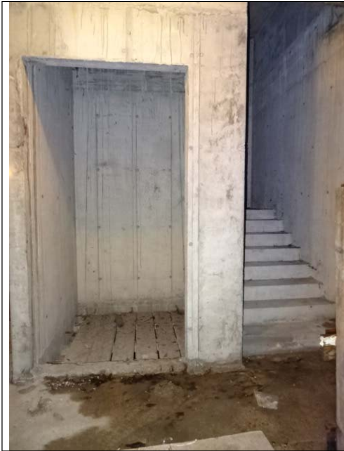
Palazzina G piano interrato vano ascensore e scale
