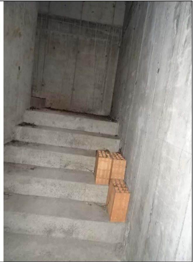
Palazzina G piano terra vano scale
