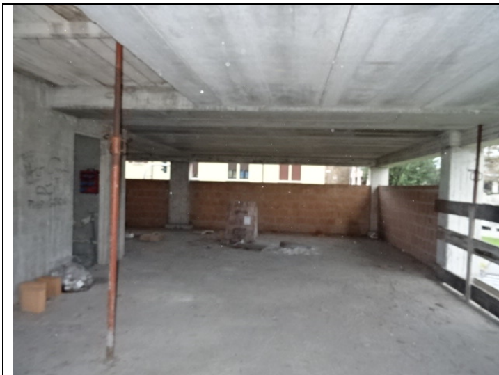
Palazzina G piano rialzato
