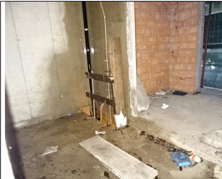
Palazzina G piano interrato vano scala e servizi
