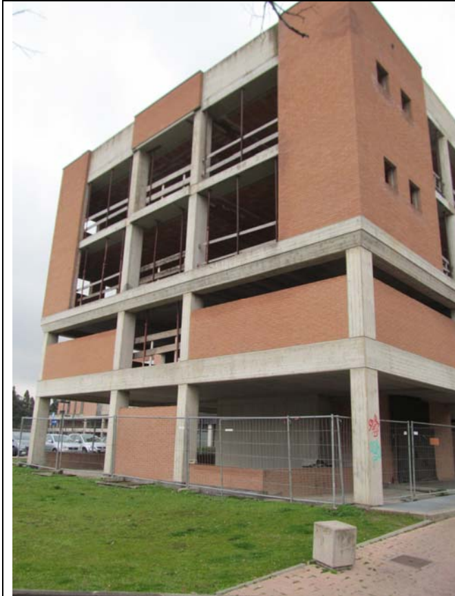
Palazzina G prospetto esterno nord ovest
