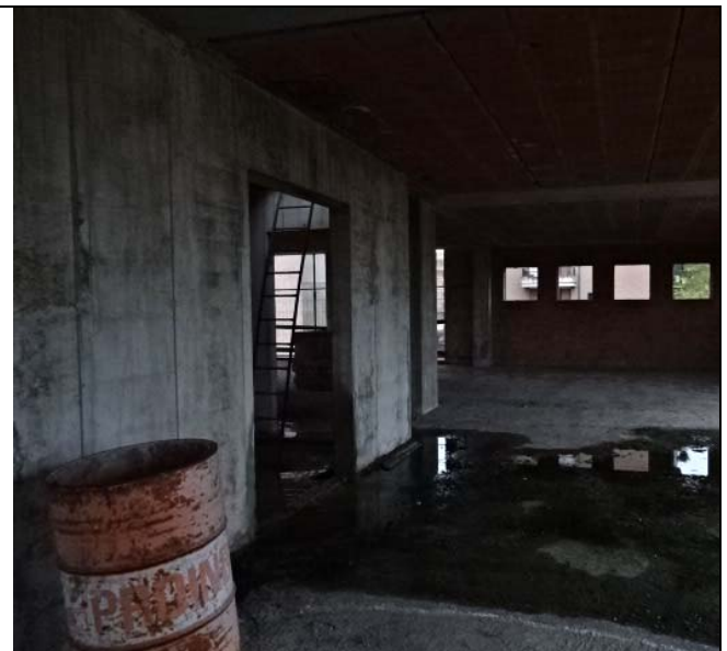
Palazzina G piano secondo
