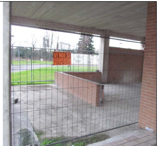
Palazzina G piano terra negozi
