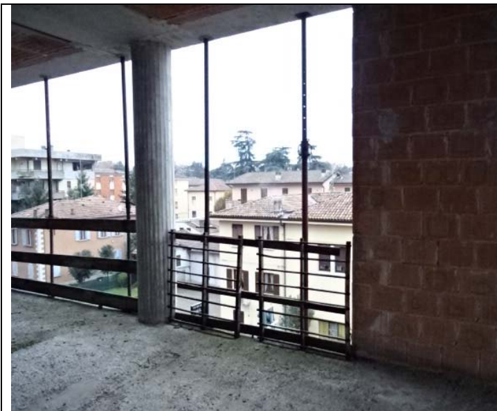
Palazzina G piano secondo
