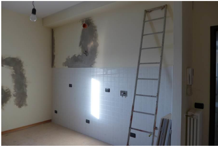
Figura 5: viste interne appartamento al piano secondo sub. 2.
