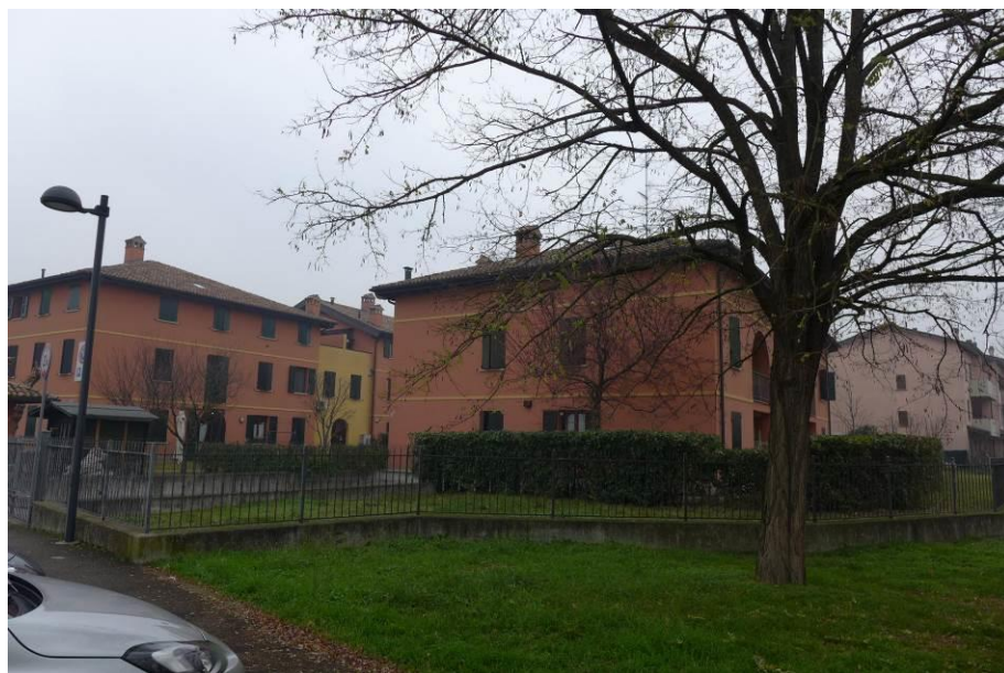
Figura 2: vista dell'autorimessa e del complesso edilizio.
