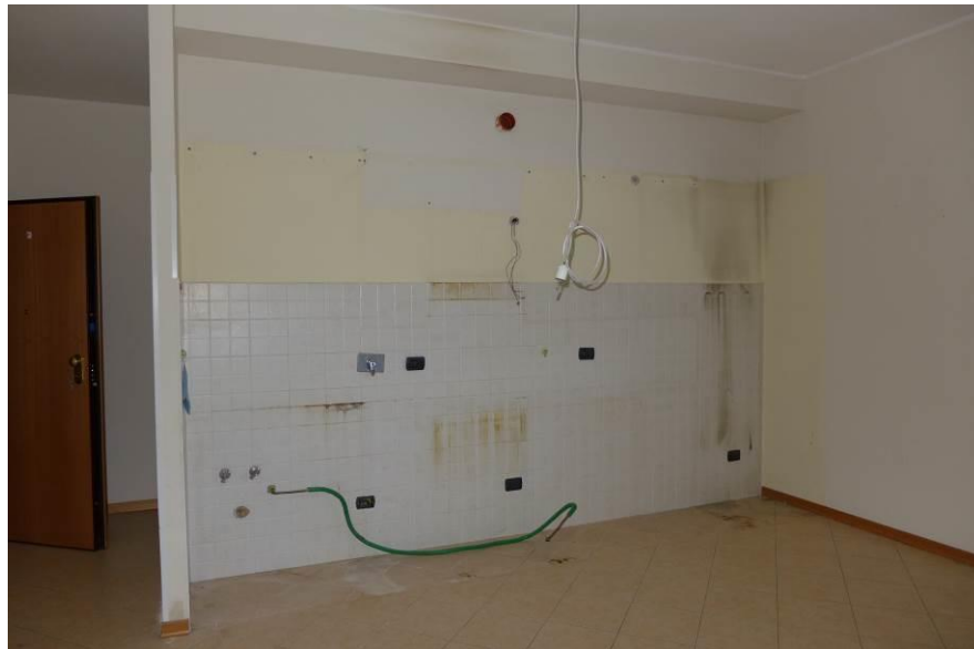
Figura 6: viste interne appartamento al piano secondo sub. 3.
