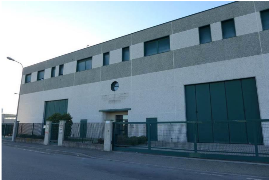
Figura 2: viste esterne dell'immobile.
