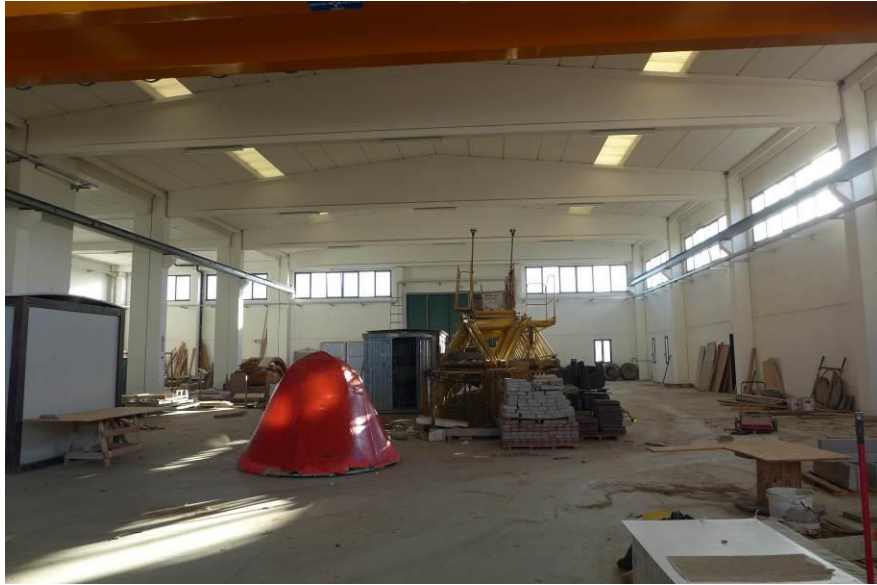
Figura 3: viste interne capannone piano terra.
